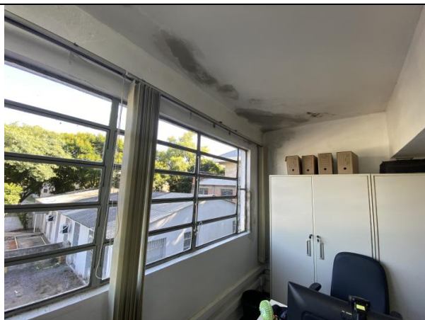
Foto 11 – Reparos realizados nas lajes com problemas devido a infiltração.
