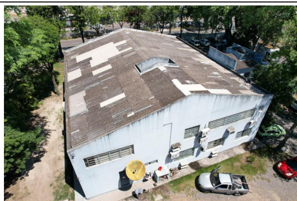
Foto 2 – Vista aérea da fachada dos fundos e cobertura.
