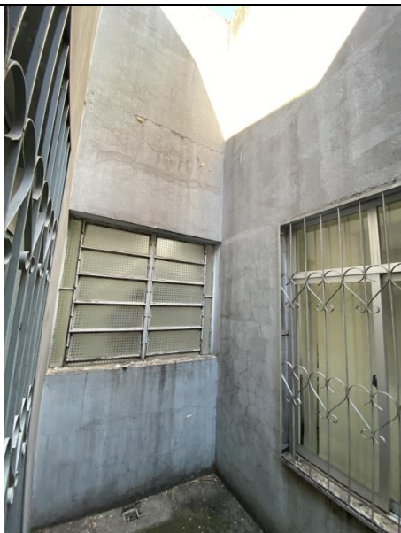
Foto 7 – Poço de luz - pavimento superior.
