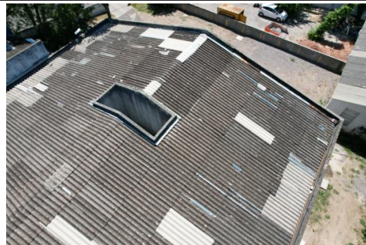
Foto 4 – Vista aérea da cobertura.
