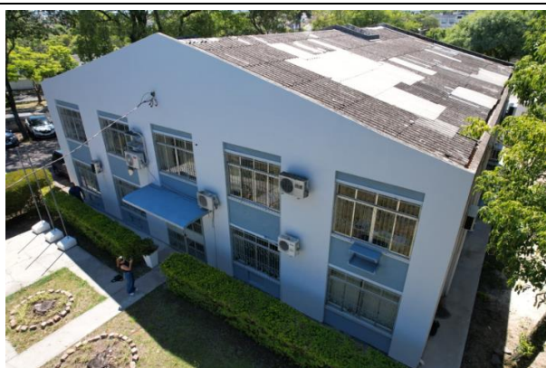
Foto 1 – Vista aérea da fachada frontal e cobertura.
