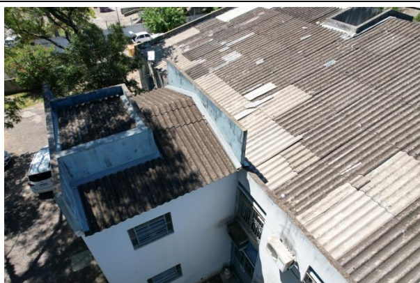
Foto 5 – Vista aérea da cobertura.
