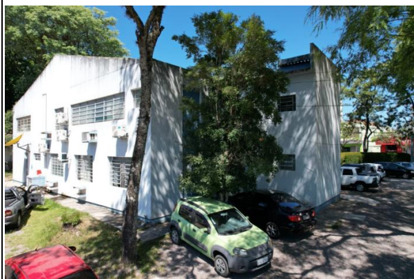
Foto 8 – Fachadas do fundo e lateral.
