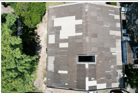
Foto 3 – Vista aérea da cobertura.
