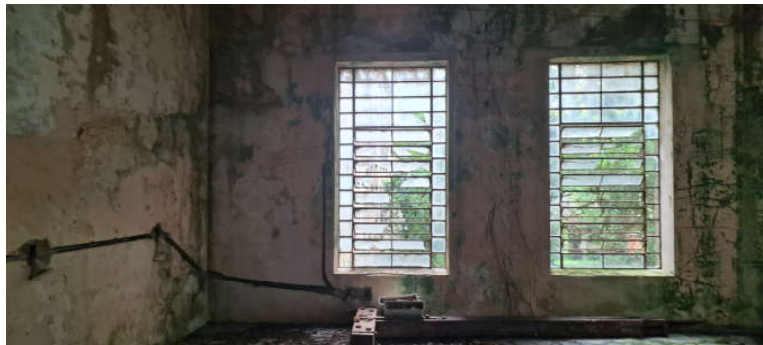
Parede de fachada externa com infiltrações e mofos. Sugere-se a substituição dos cabos presentes nestes eletrodutos.
