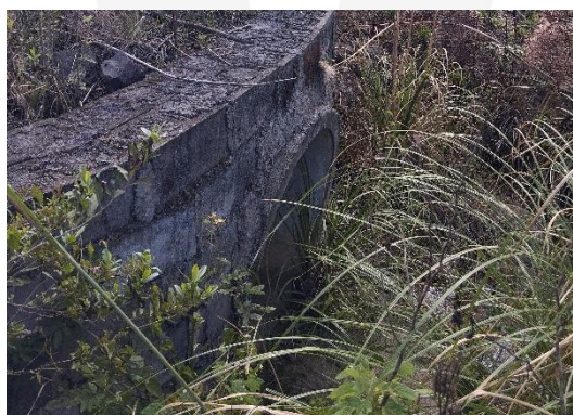
FIGURA 10 – BOCA DE LOBO – FONTE: FOTOS LEVANTAMENTO PLANIALTIMÉTRICO
