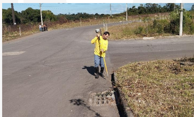
FIGURA 10 – BOCA DE LOBO – FONTE: FOTOS LEVANTAMENTO PLANIALTIMÉTRICO
