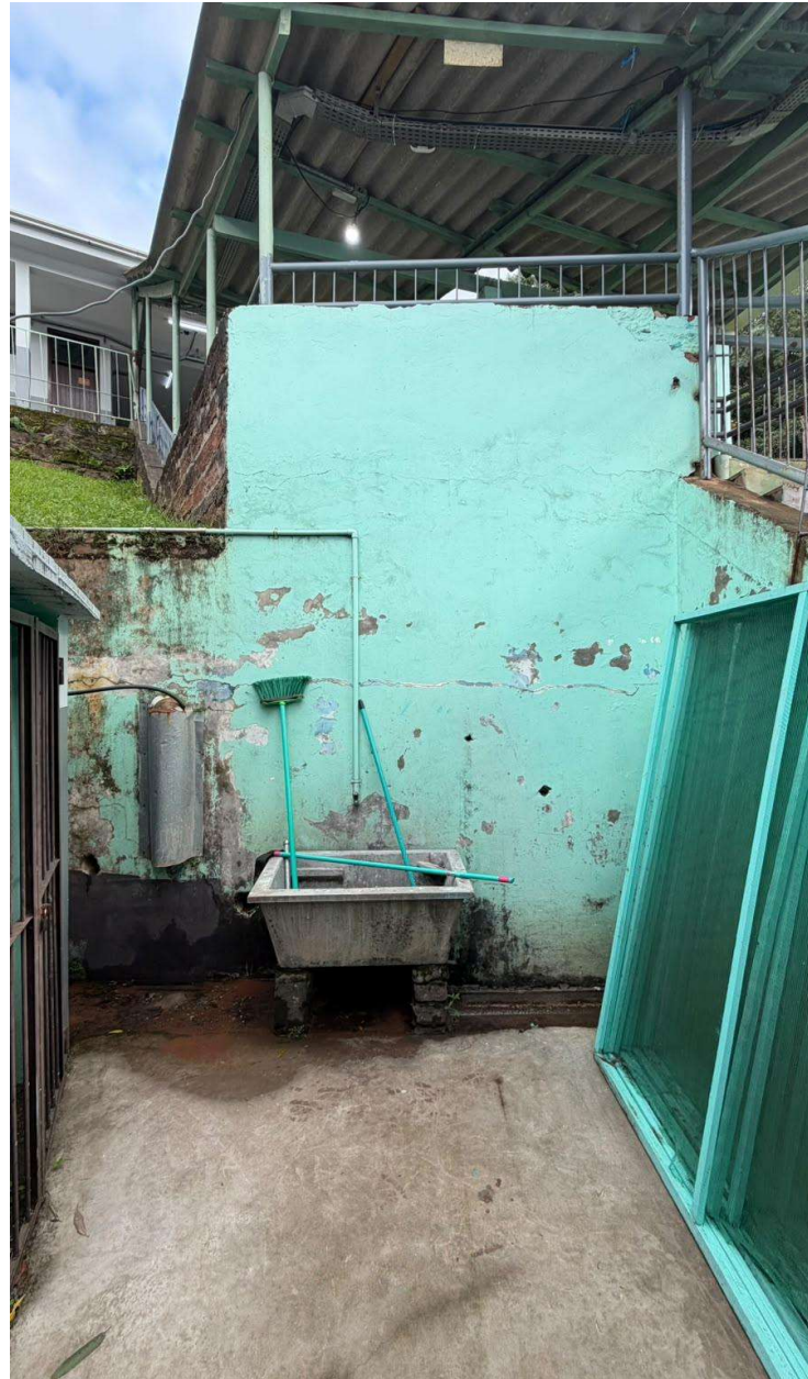
Figura 5: Muro de contenção no primeiro pavimento da escola.
