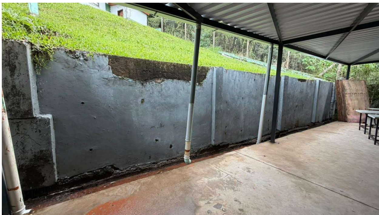
Figura 3: Muro de contenção no primeiro pavimento da escola.
