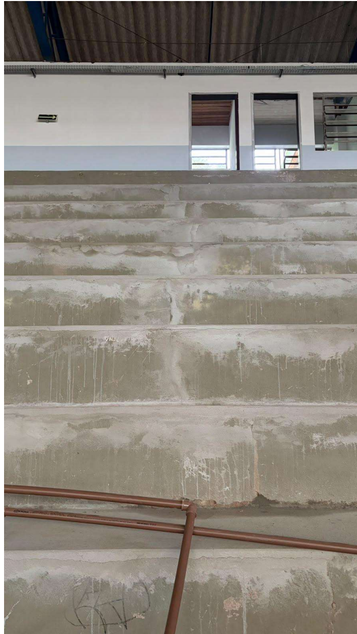
Figura 31: Reparos realizados na arquibancada do ginásio.
