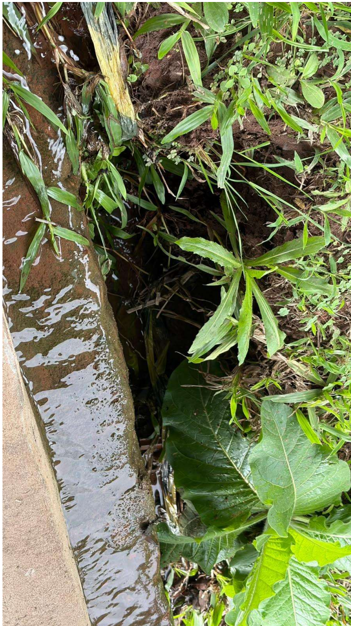
Figura 14: Cavidade com presença de água constante.
