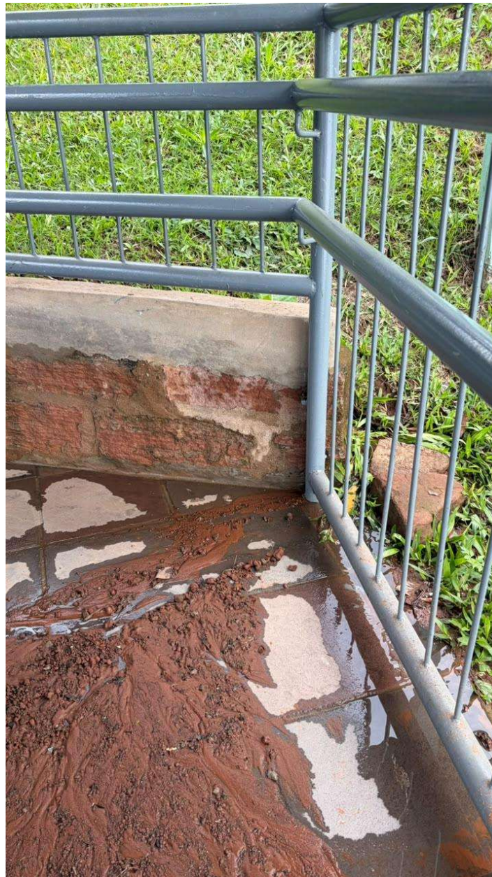
Figura 10: Resíduo de solo proveniente de uma das cavidades do talude.
