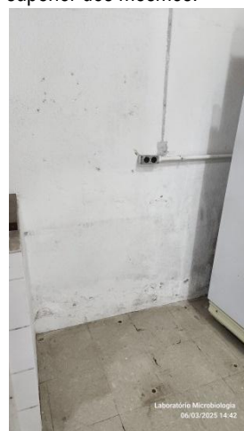
Dutos a serem retirados e ou remanejados em sua função, assim como acúmulo de pó na parte superior dos mesmos.
