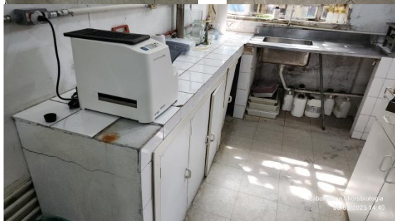
Estado atual do piso e bancadas em azulejo com juntas porosas, mobiliário destruído pelo tempo e umidade.
