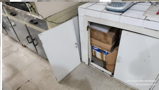
Estado atual do piso e bancadas em azulejo com juntas porosas, mobiliário destruído pelo tempo e umidade.
