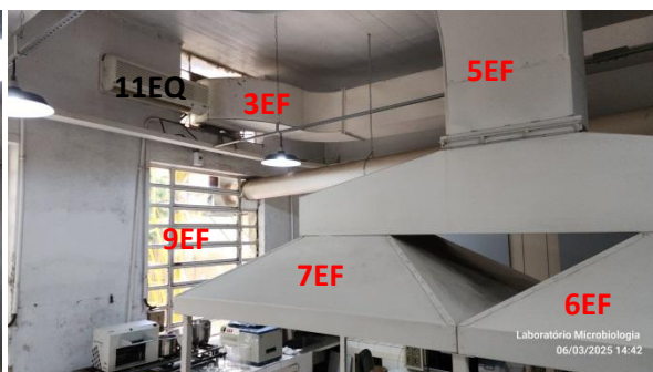
Dutos a serem retirados e ou remanejados em sua função, assim como acúmulo de pó na parte superior dos mesmos.
