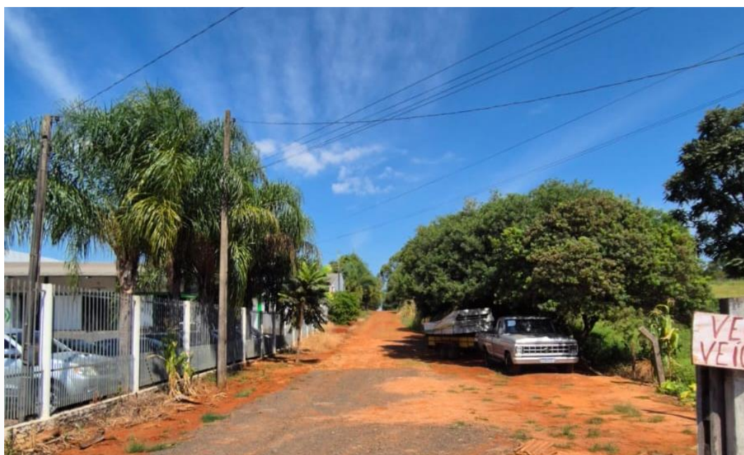
Figura 23 – Rua sem pavimentação - Fonte: Própria
