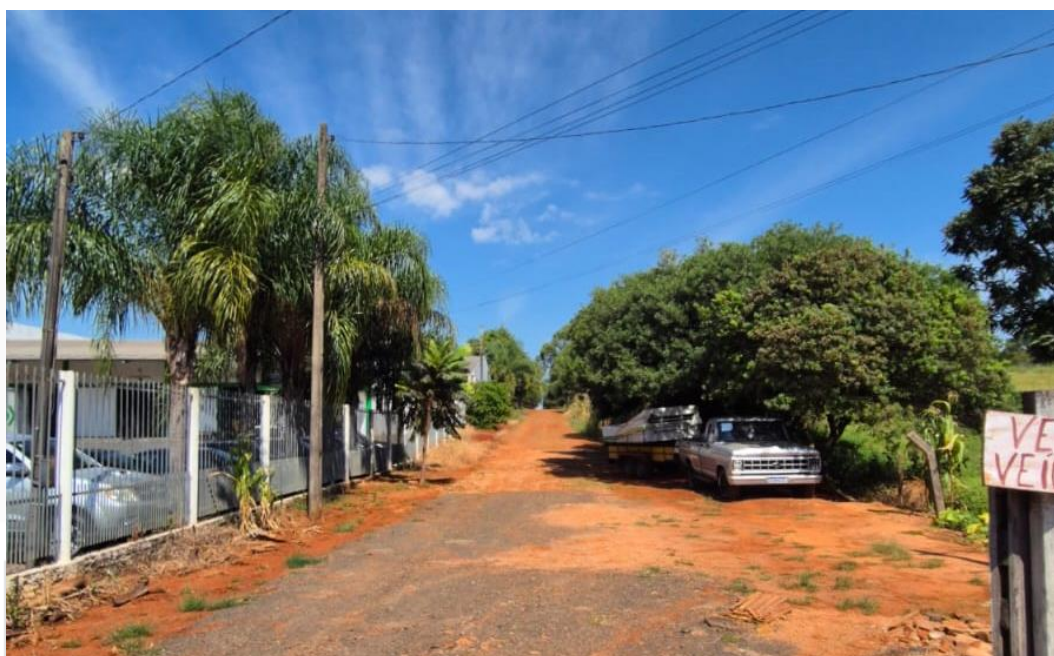
Figura 14 – Via sem pavimentação - Fonte: Própria
