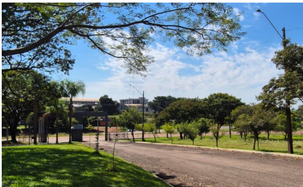
Figura 15 – Via sem pavimentação - Fonte: Própria
