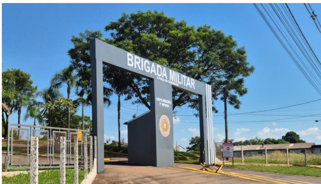
Figura 18 – Pórtico de acesso ao CRPO Missões e 7º Regimento da Polícia Montada - Fonte: Própria
