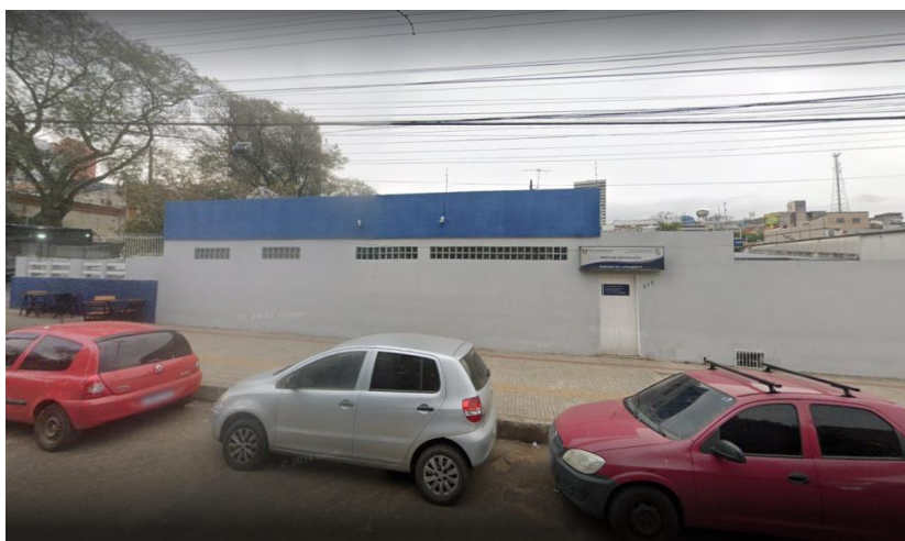
R. VASCO ALVES 542 – ACESSO POSTO DE IDENTIFICAÇÃO
