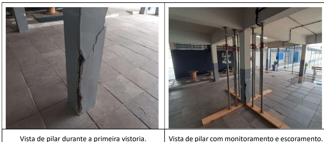
Imagem 02: Fotografias de pilar a ser reforçado.
