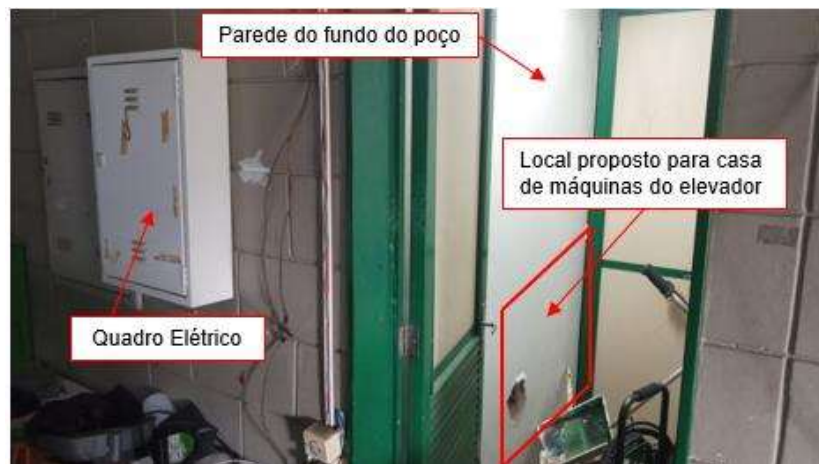
Figura 5 – Localização do quadro elétrico e casa de máquinas do elevador
