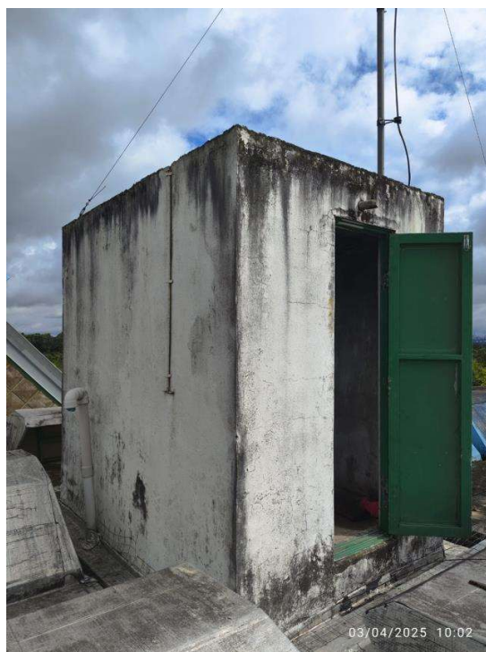
Figura 8 – Vista externa da casa de máquinas
