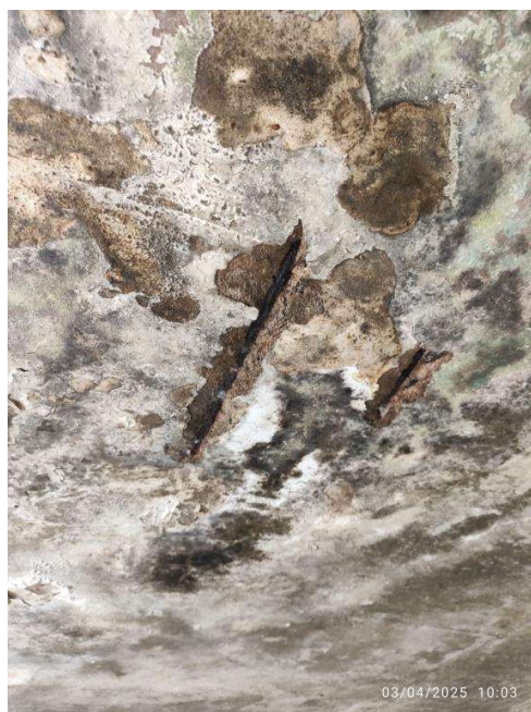
Figura 9 – Vista interna da laje casa de máquinas
