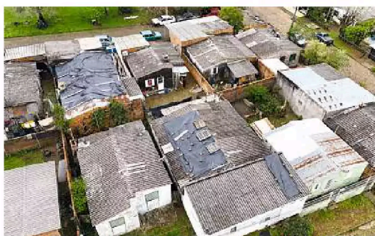
Em Quaraí, 287 casas precisaram de lonas nas coberturas
