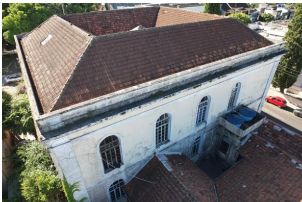
F01 – Vista geral cobertura escola Rivadavia Correa
