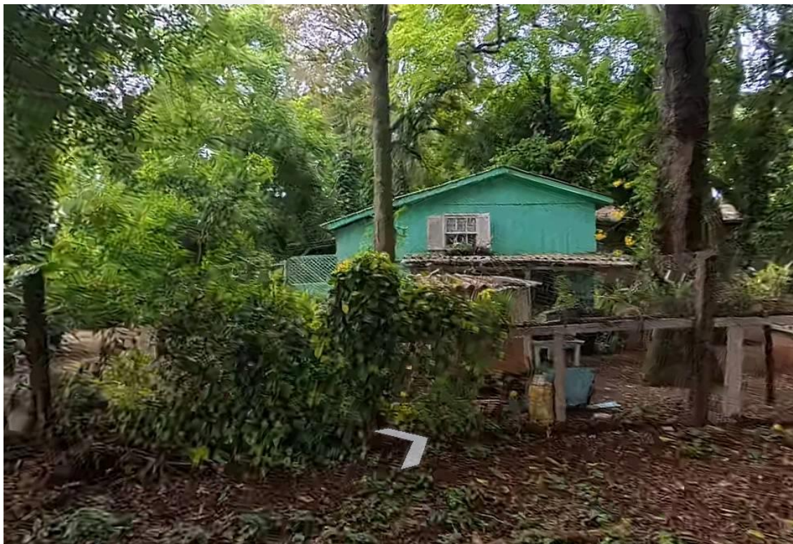
Imagem 42 - Fachada Direita - Edificação Existente 4
