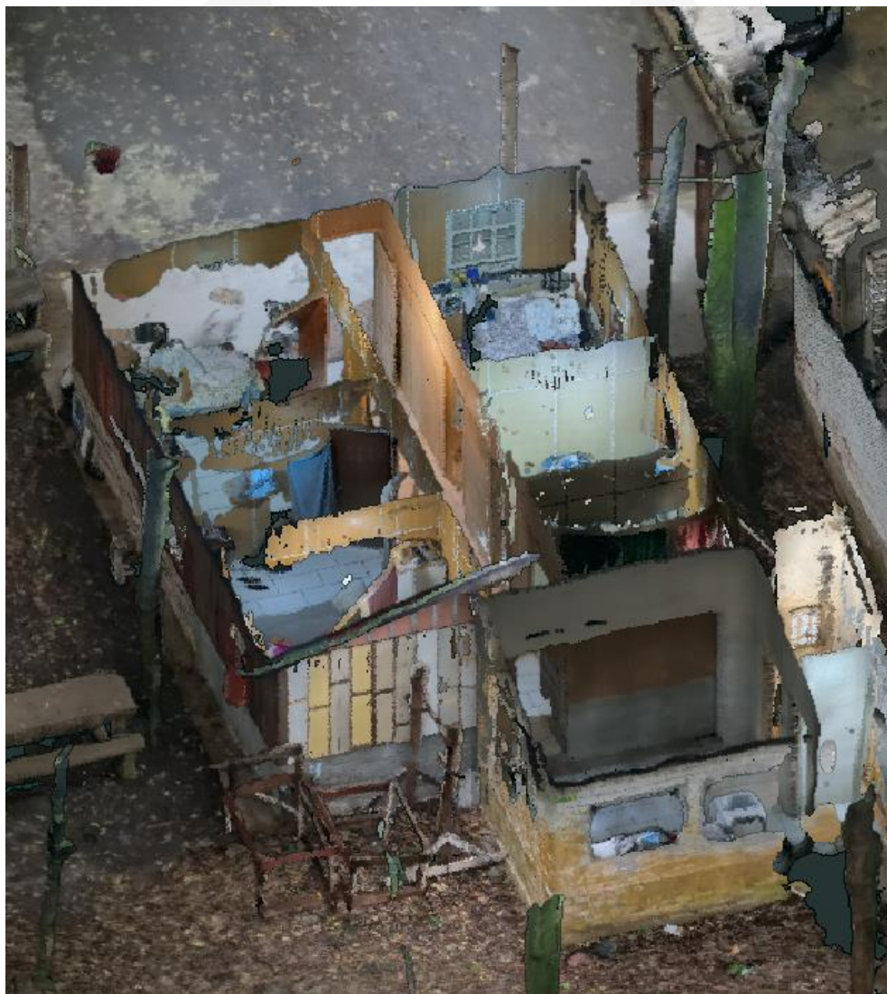
Imagem 35 - 3D - Edificação Existente 3
