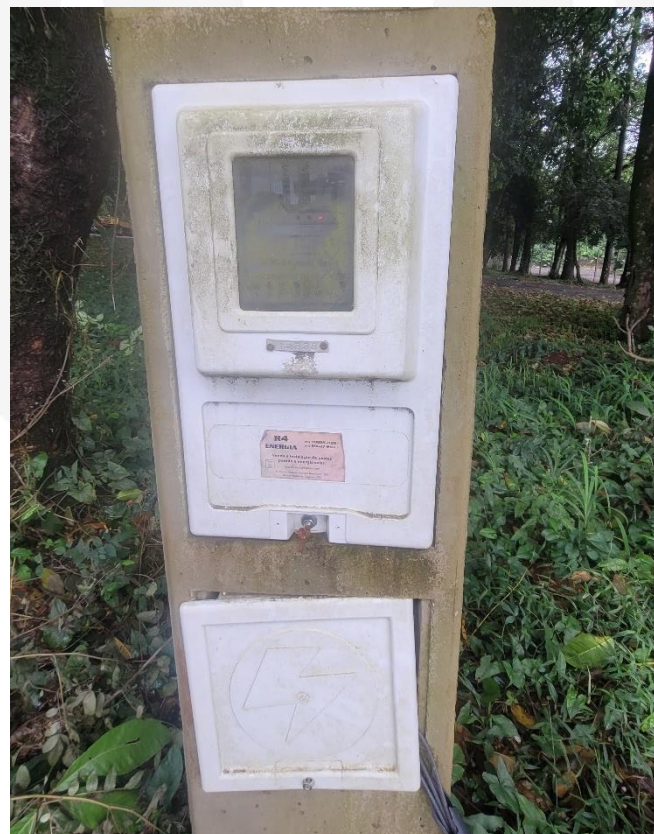
Imagem 18 - Medidor de energia
