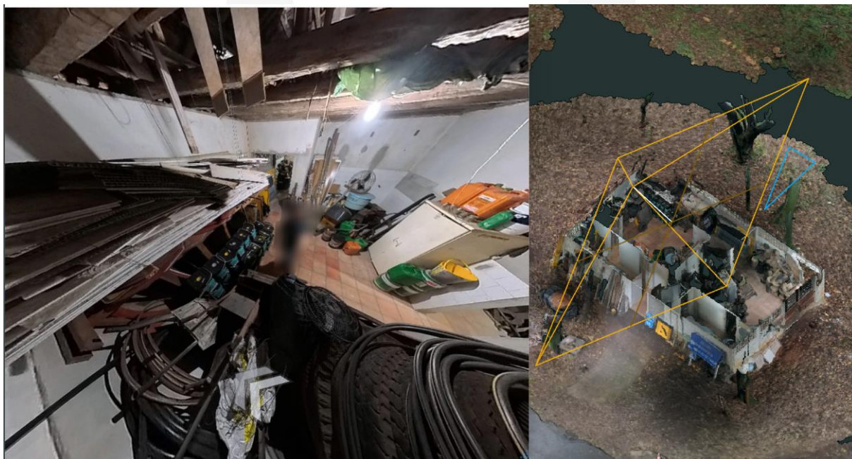
Imagem 29 - Edificação Existente 1 - Ambiente 05
