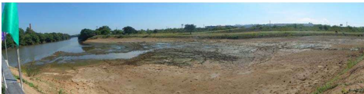
Figura 57 - Confluência do canal secundário com o canal principal, a jusante da ponte da BR-116 Fonte: DNIT - Departamento Nacional de Infraestrutura de Transportes, Projeto executivo para recuperação, reforço e reabilitação de pontes rodoviárias na BR-116 - RS, Abril/2014
