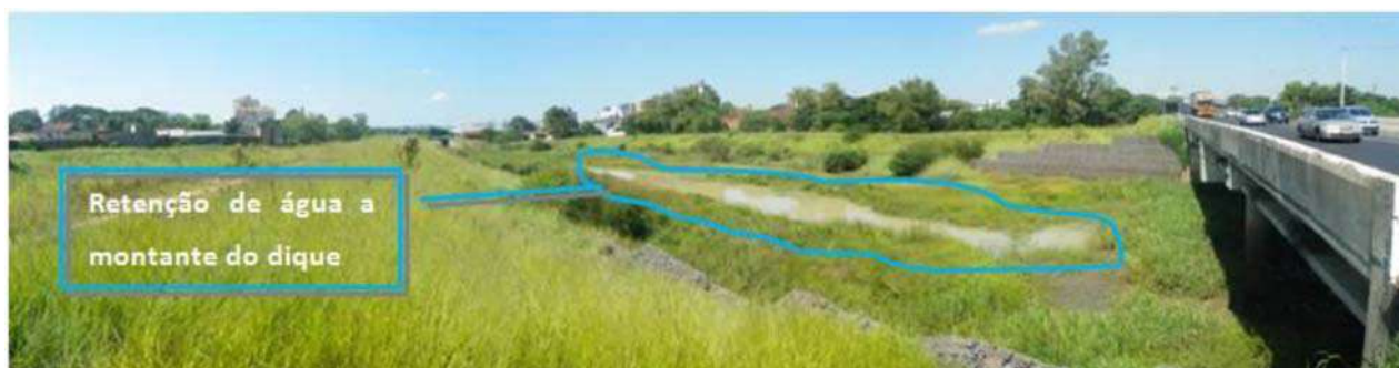
Figura 56 - Trecho do canal secundário a montante da ponte da BR-116 Fonte: DNIT - Departamento Nacional de Infraestrutura de Transportes, Projeto executivo para recuperação, reforço e reabilitação de pontes rodoviárias na BR-116 - RS, Abril/2014
