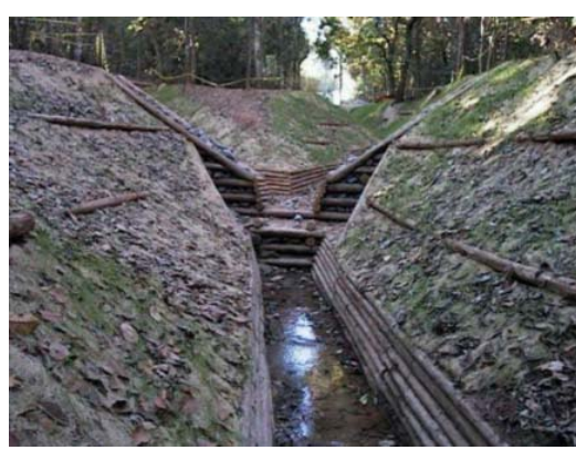
Figura 124 - Recuperação de voçoroca com uso de técnicas de engenharia naturalística (Fonte: Sponga, M. e Coelho, I / 2001)
