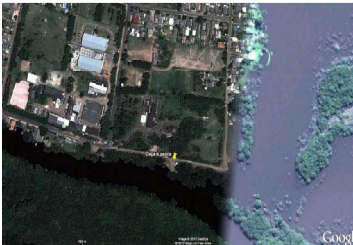
Figura 72 - Ocupação residencial com elevação de 3m, (Bairro Parque dos Anjos / Gravataí) (Fonte: SCHEREN, 2014)
