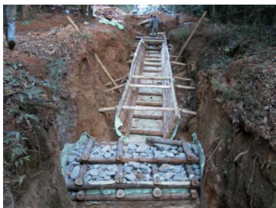
Figura 124 - Recuperação de voçoroca com uso de técnicas de engenharia naturalística (Fonte: Sponga, M. e Coelho, I / 2001)
