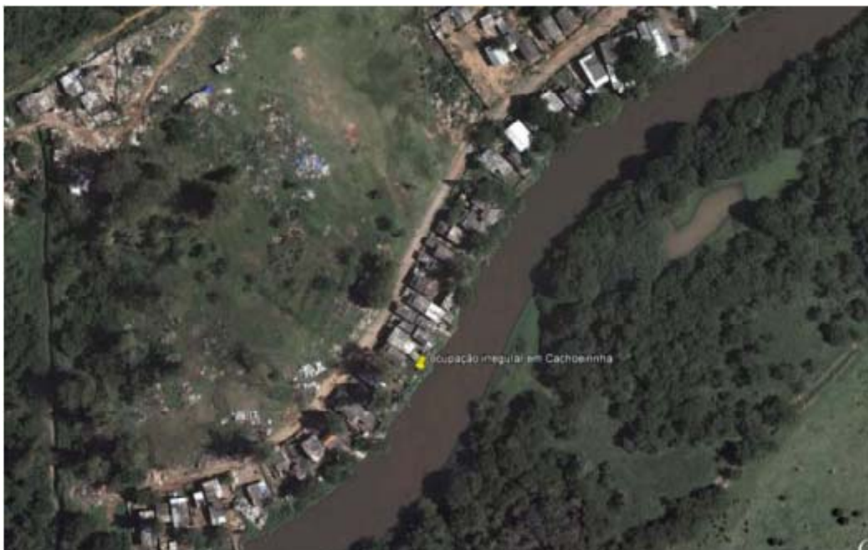
Figura 66 - Ocupação irregular, 2,5 m acima do nível do Rio (Cachoeirinha) (Fonte: SCHEREN, 2014)
