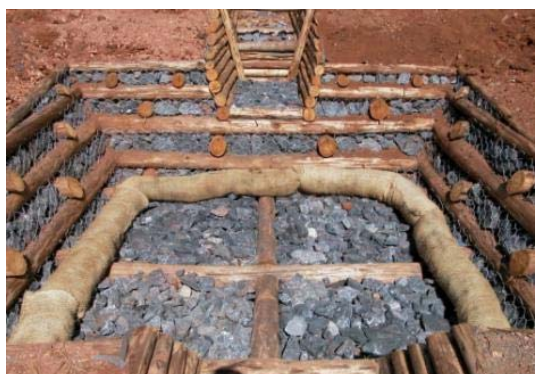
Figura 123 - Estrutura para dissipação de energia e contenção de sedimentos (Fonte: http://verticalgreen.com.br )
