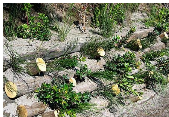
Figura 122 - Contenção de margens com engenharia naturalística (Fontes: http://tecnicaelogica.blogspot.com.br e http://naturlink.pt )
