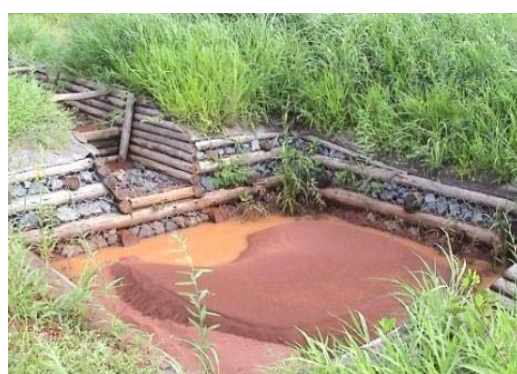
Figura 123 - Estrutura para dissipação de energia e contenção de sedimentos (Fonte: http://verticalgreen.com.br )
