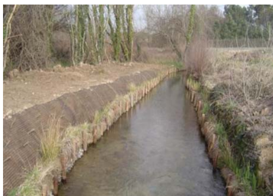
Figura 122 - Contenção de margens com engenharia naturalística (Fontes: http://tecnicaelogica.blogspot.com.br e http://naturlink.pt )
