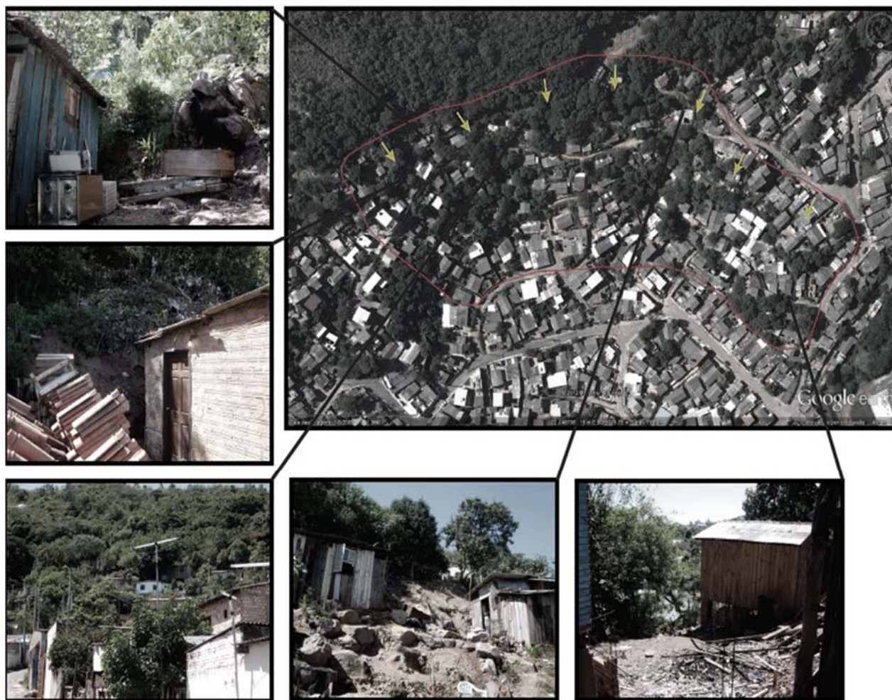
Figura 38 - Moradias inseridas em área de risco do Setor RS_POA_SR_18_CPRM (Fonte: CPRM)
