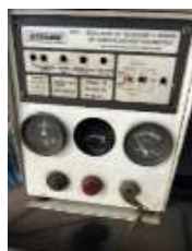
Controlador Analógico Baterias 24v
