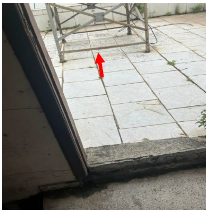
Figura 6: Estrutura metálica (antena) a ser demolida
