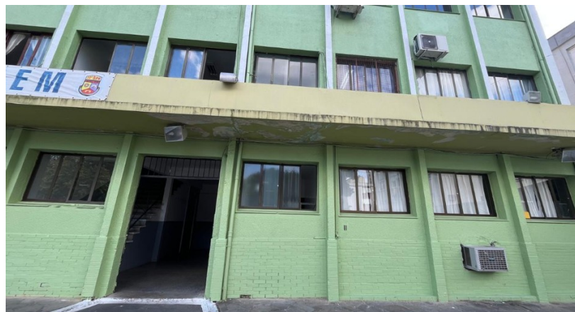
Figura 5: Marquise a ser demolida
