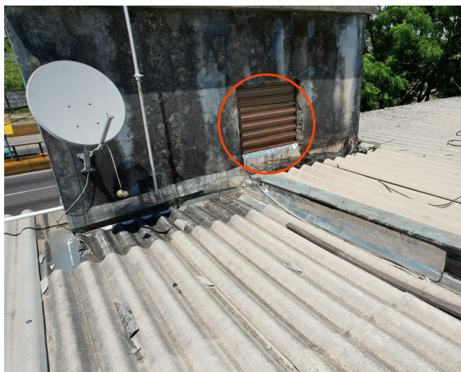
Figura 12 – acesso à cobertura
