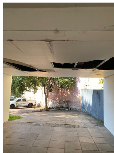
Figura 05 – queda de forro de PVC na área da figura 03
