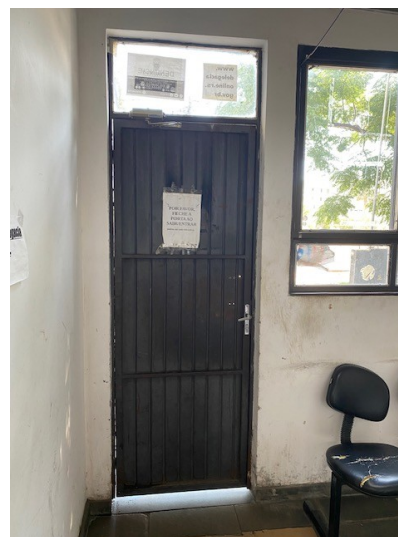
Figura 07 – Porta de entrada (vista interna)
