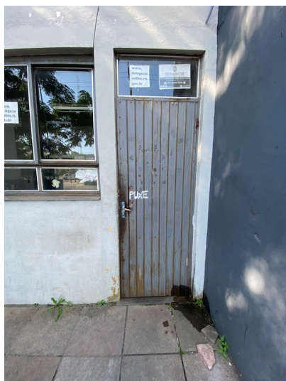
Figura 06 – única porta de entrada (vista externa)
