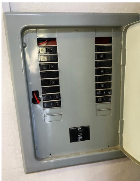
Figura 20 – CD com disjuntores antigos
