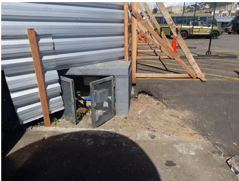
Foto 5: Tapume fazendo o fechamento dentro do pátio do quartelamento, visto pelo lado de dentro do imóvel.
