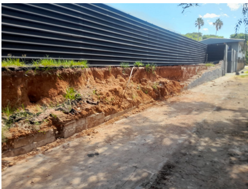
Foto1: Muro de arrimo com altura de 1,10 metros e com fechamento por tapume.
