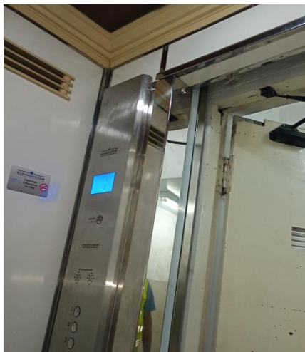
Fotografia 01 Nova porta de cabina
