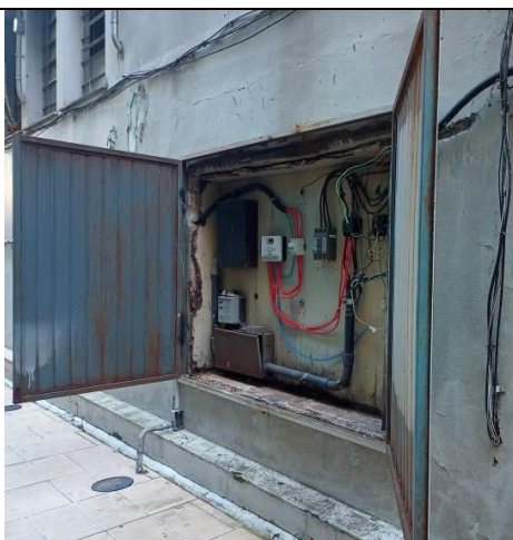
Fotografia 26 Painel elétrico de entrada e medição de energia existente no pavimento térreo
