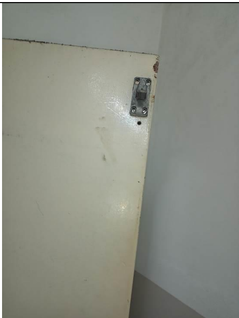
Fotografia 32 Antiga trava de segurança de porta de pavimento
