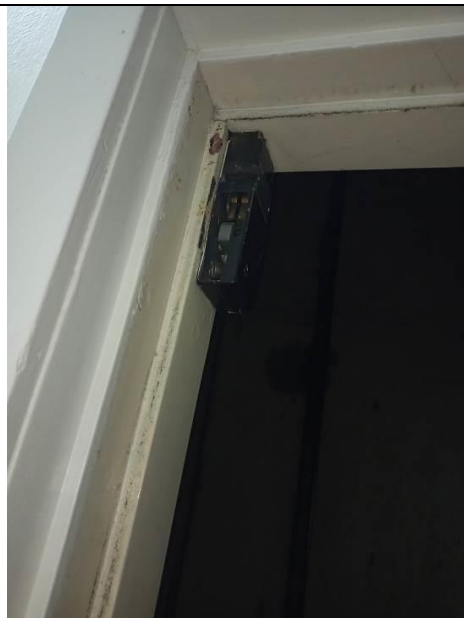
Fotografia 33 Antiga trava de segurança de porta de pavimento
