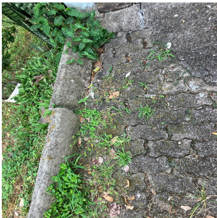
20 – Piso em blocos de concreto – Acesso à Garagem - Lateral Esquerda da Edificação
