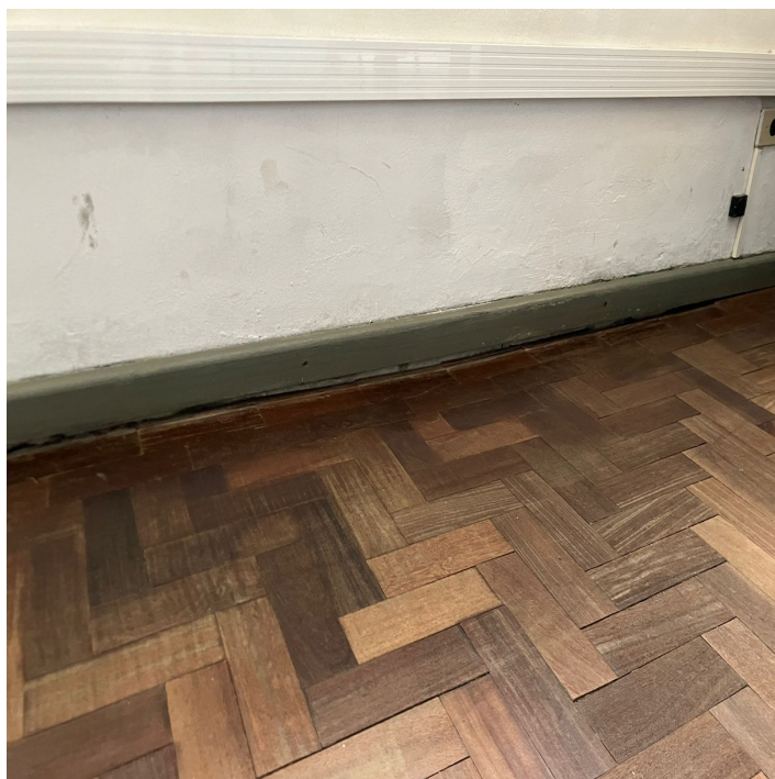
57 – Piso Solapado – Sala.
