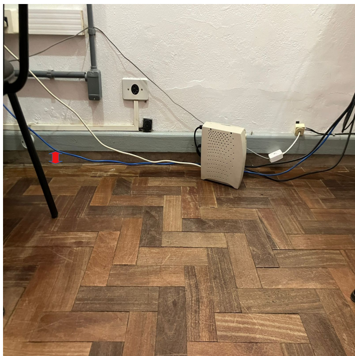
48 – Piso Solapado – Sala.
