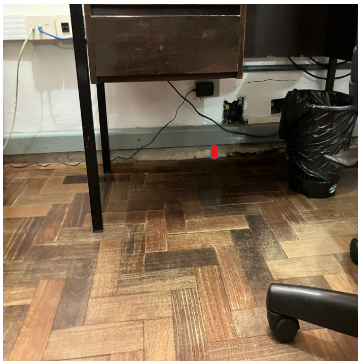
49 – Piso Solapado – Sala.
