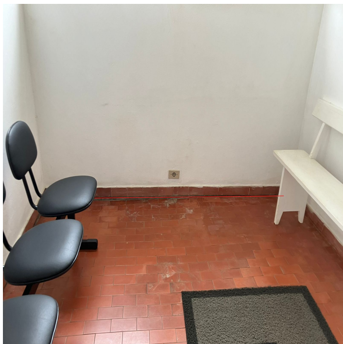
53 – Piso Solapado – Sala.
