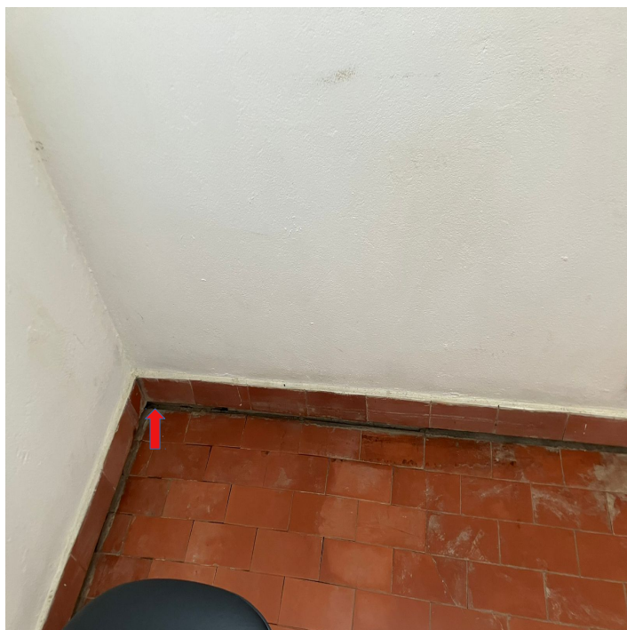
54 – Piso Solapado – Sala.
