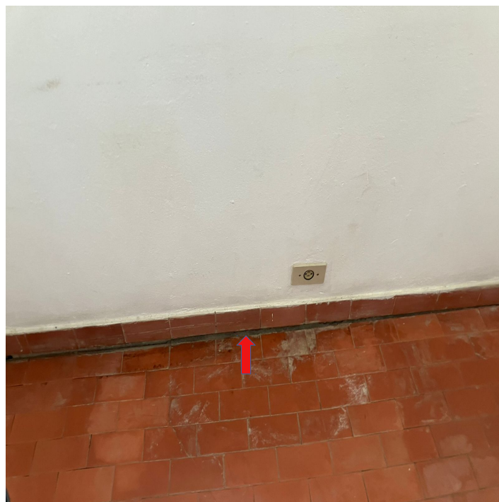
55 – Piso Solapado – Sala.
