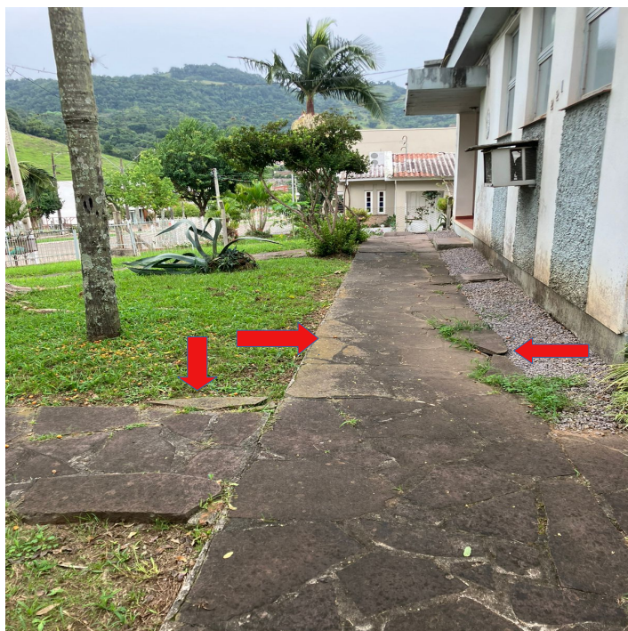
15 – Piso em Basalto Solapado – Fachada Principal da Edificação.
