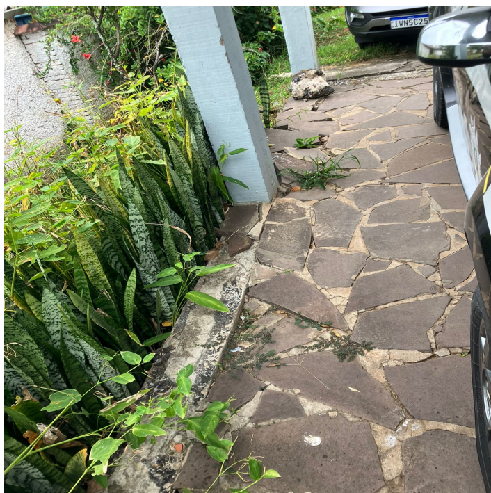
19 – Piso em Basalto Solapado – Garagem - Lateral Esquerda da Edificação
