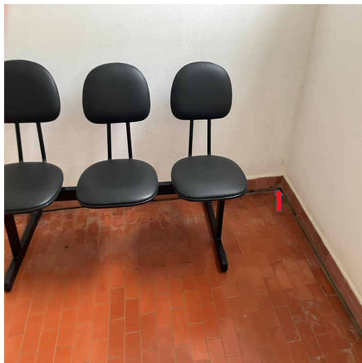
56 – Piso Solapado – Sala.
