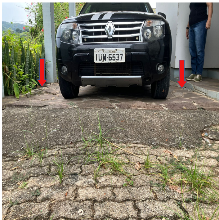
18 – Piso em Basalto Solapado – Garagem - Lateral Esquerda da Edificação
