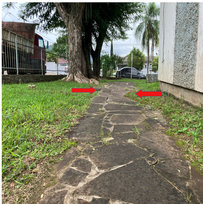
17 – Piso em Basalto Solapado – Fachada Lateral Direita da Edificação.
