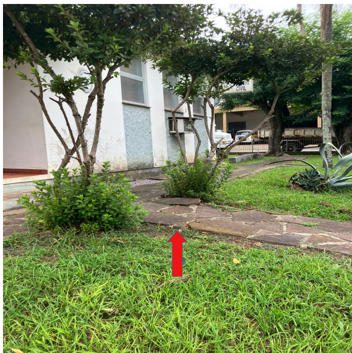
16 – Piso em Basalto Solapado – Fachada Principal da Edificação.
