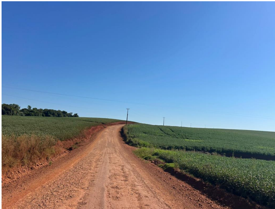
Foto 6: Situação do pavimento.
