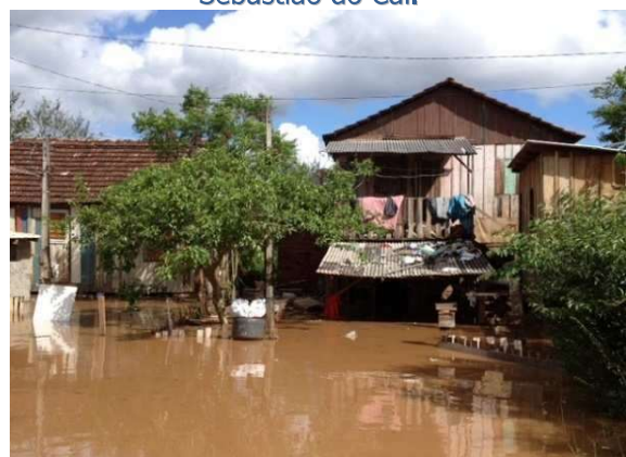
Figura 3.6: Inundação de 2012 na cidade de São Sebastião do Caí. 6
