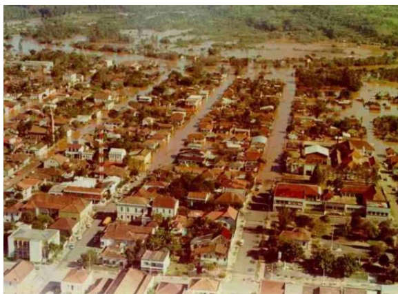
Figura 3.2: Inundação de 1982 na cidade de São Sebastião do Caí. 2
