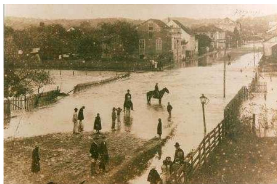
Figura 3.1: Enchente em São Sebastião do Caí (1920) 1
