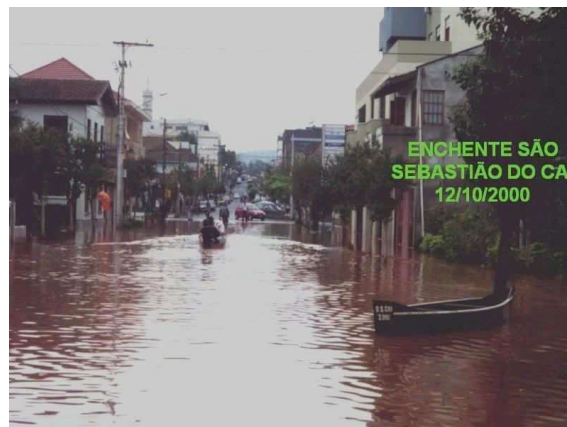
Figura 3.3: Inundação de 2000 na cidade de São Sebastião do Caí. 3
