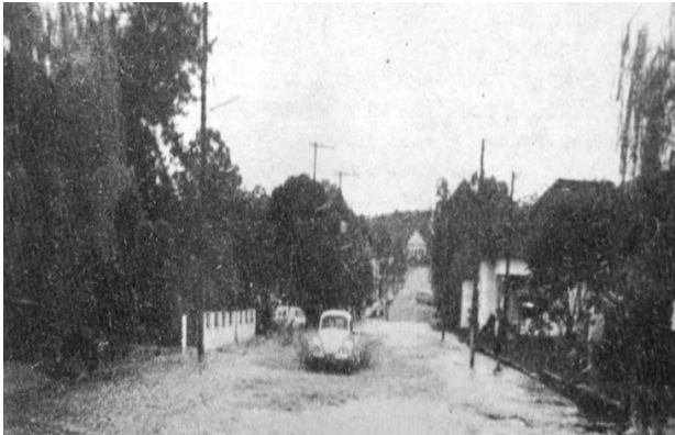
Figura 2.19: Inundação em Harmonia, em 1984 18
