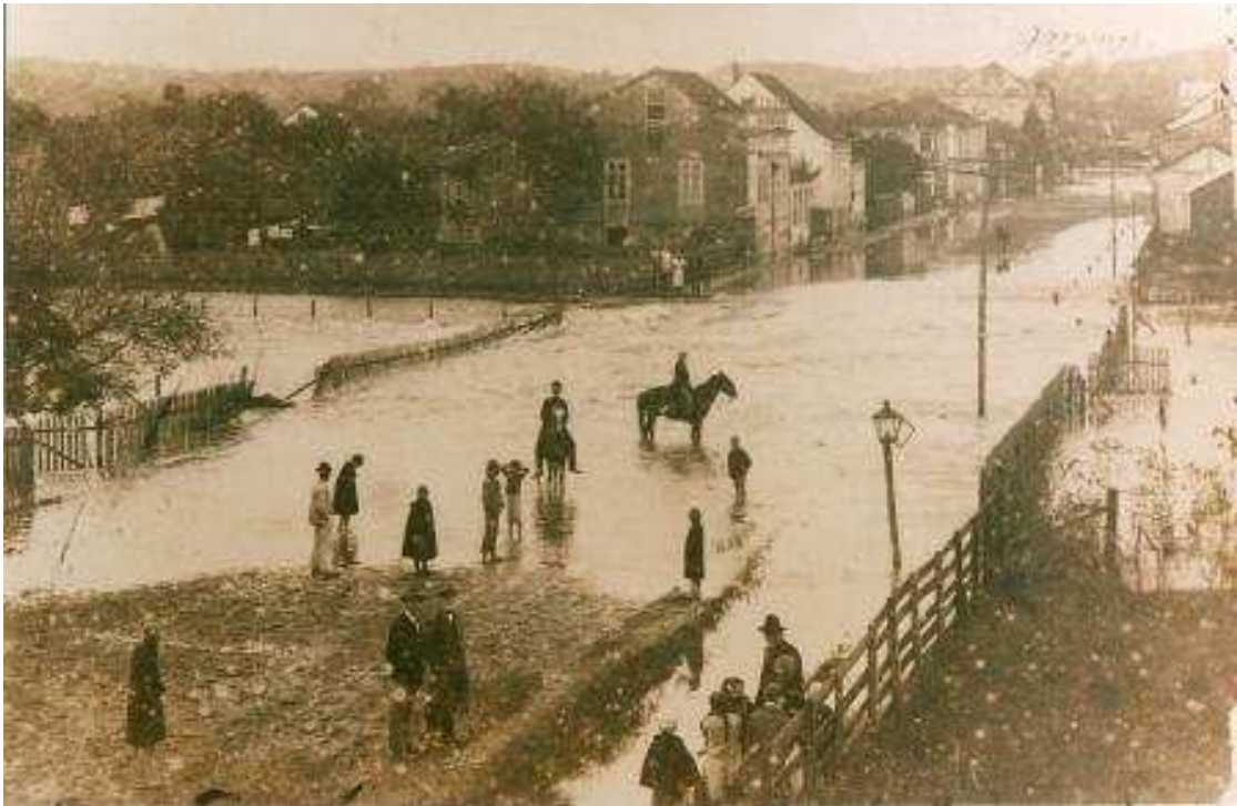
Figura 2.1: Enchente em São Sebastião do Caí (1920) 1
