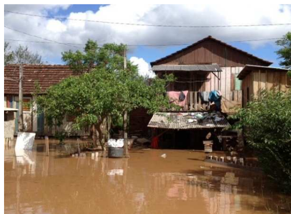
Figura 2.6: Inundação de 2012 na cidade de São Sebastião do Caí. 6
