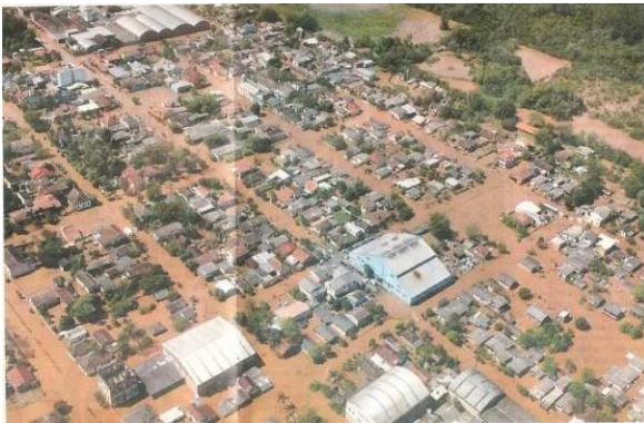
Figura 2.4: Inundação de 2007 na cidade de São Sebastião do Caí. 4
