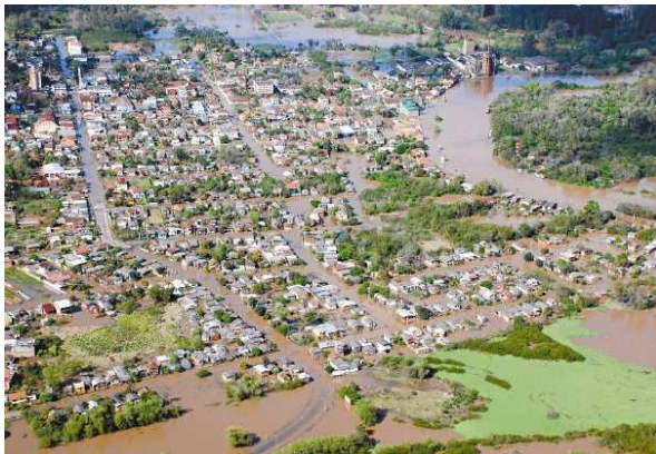
Figura 2.11: Inundaç o em Montenegro em julho de 2009 10
