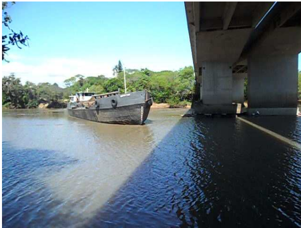
Passagem de Barcos sob a Ponte da Sessão Topobatimétrica S06
