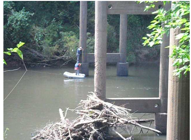
Levantamento da Ponte da Sessão Topobatimétrica S23
