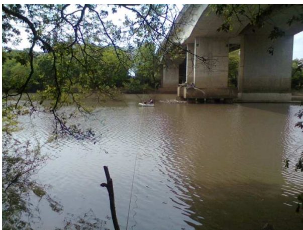
Levantamento da Ponte da Sessão Topobatimétrica S06
