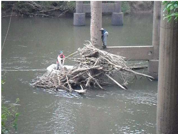
Levantamento da Ponte da Sessão Topobatimétrica S23
