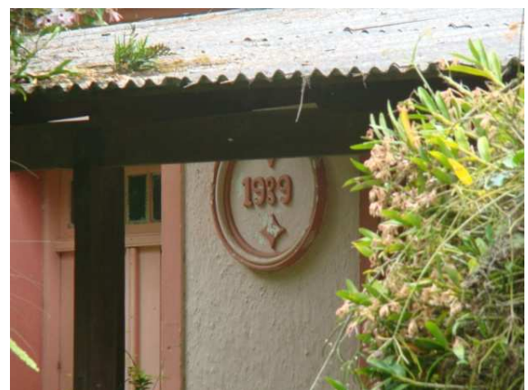
Casa do ano de 1939 localizada próxima ao camping
