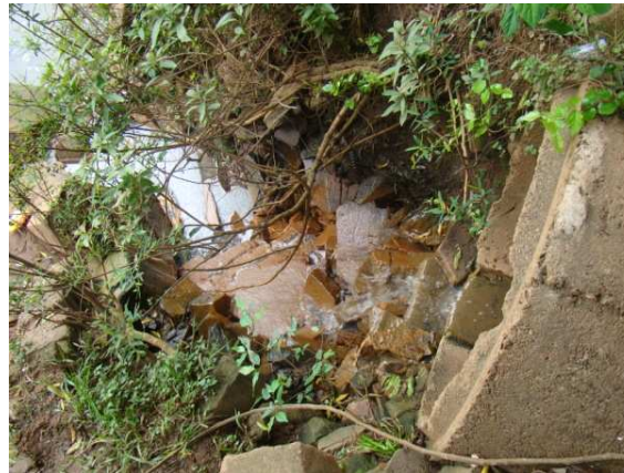
Lançamento de efluentes no rio Caí
