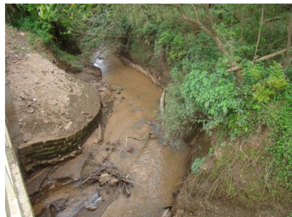
Vista do arroio urbano do outro lado da ponte.
