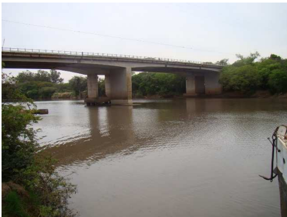
Vista do rio Caí junto a ponte rodoviária da BR-386
