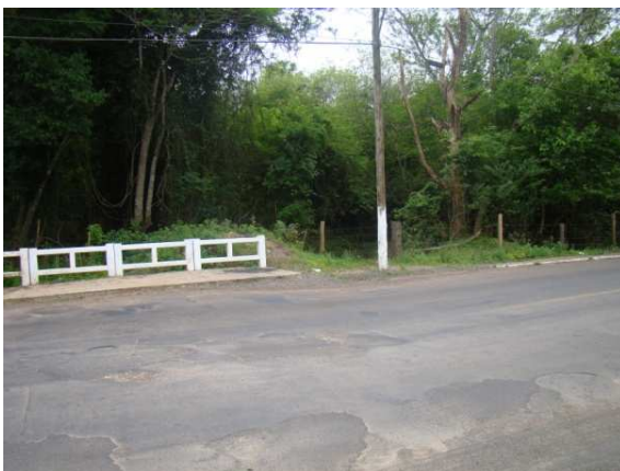
De acordo com os funcionários da TANAC na enchente de agosto de 2013 a água sob a ponte atingiu a altura da parte branca do poste localizado no outro lado da rua.
