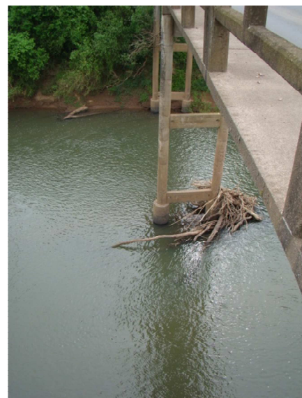
Detalhe do pilar da ponte
