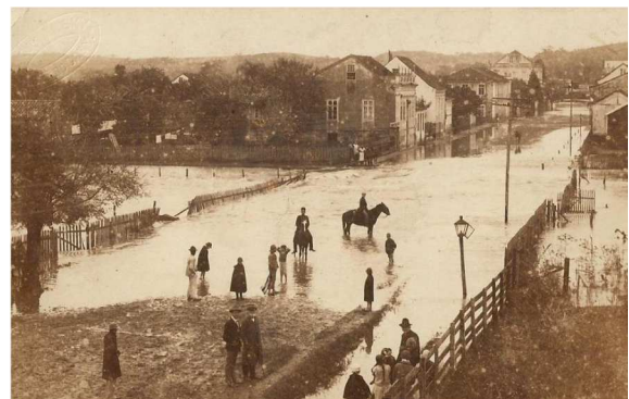
Enchente de 1920: Cercas sendo levadas pela água. Acervo da família Selbach.
