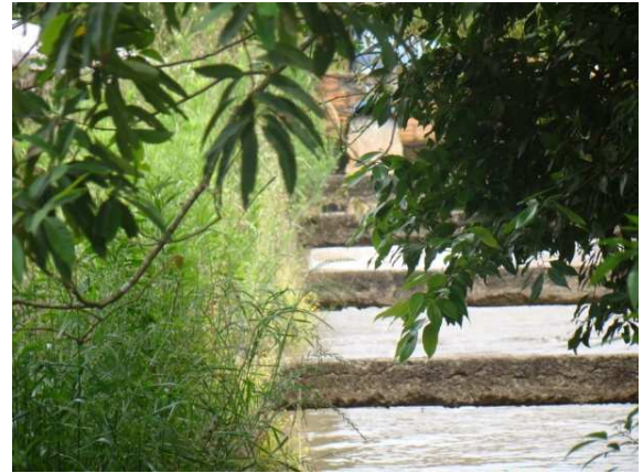
Canal onde é realizado bombeamento de água para uso na Granja Nene
