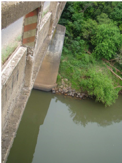
Detalhe dos pilares da ponte da RS-240
