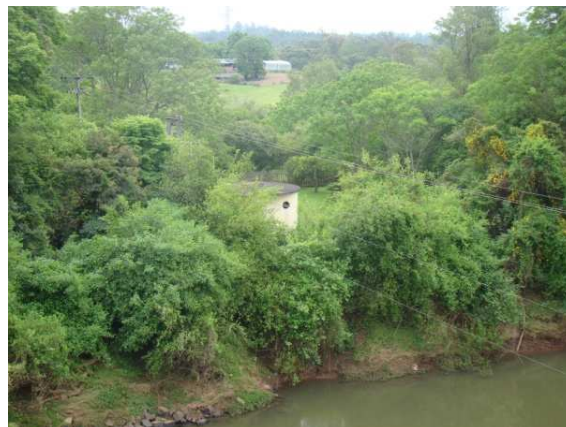
Detalha da estrutura na margem do rio Caí.
