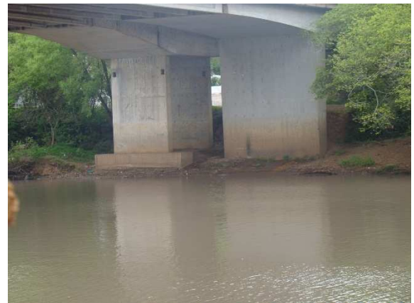
Detalhe do pilar da ponte rodoviária
