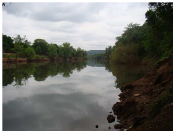
Erosão nas margens do rio Caí
