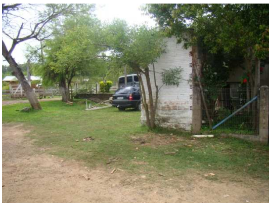
Marcas da enchente na construção
