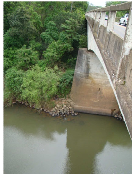
Detalhe dos pilares da ponte da RS-240
