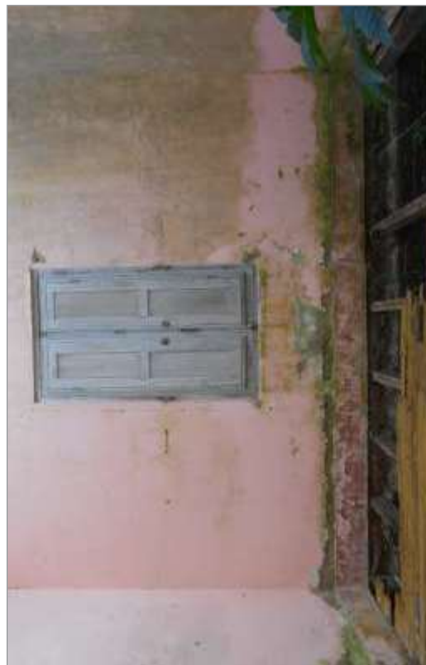
foto 88/168 - Vista do Ambiente 03: parede oposta ao acesso interno.
