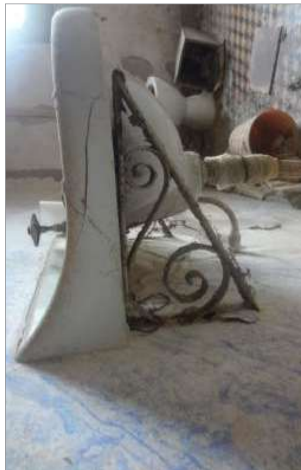
foto 129/168 - Detalhe do lavatório do banheiro.
