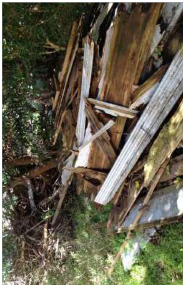
foto 156/168 - Deposição de material de construção no pátio.
