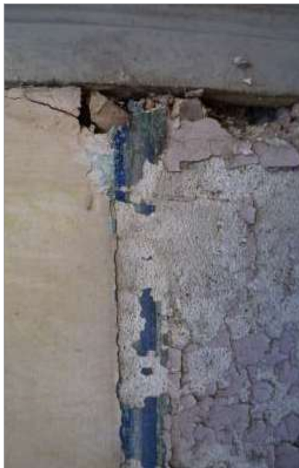
foto 100/168 - Detalhe pintura mural no Ambiente 04.
