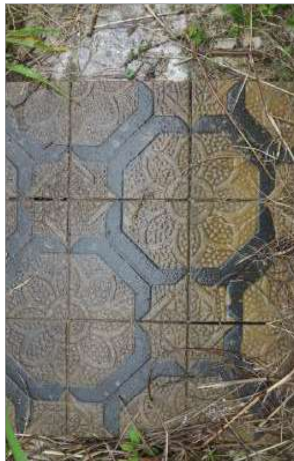
foto 164/168 - Ladrilho hidráulico externo.
