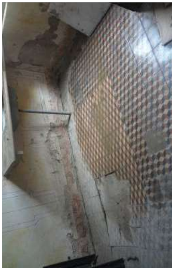
foto 144/168 - Piso da cozinha.
