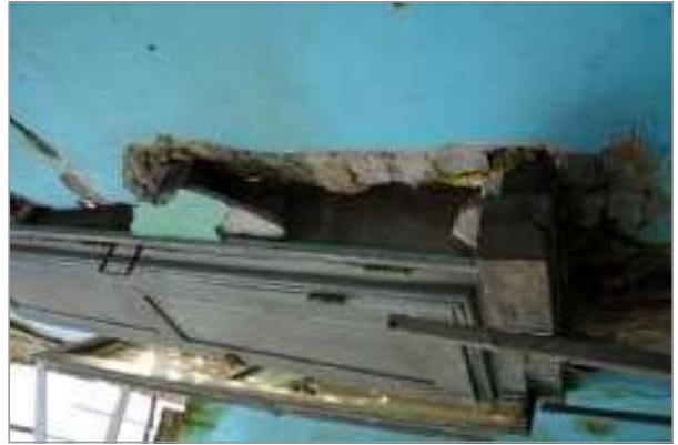
foto 86/168 - Detalhe de esquadria do Ambiente 02.
