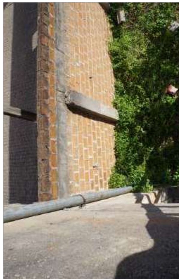
foto 168/168 - Vista do muro pela Rua Andrade Neves.
