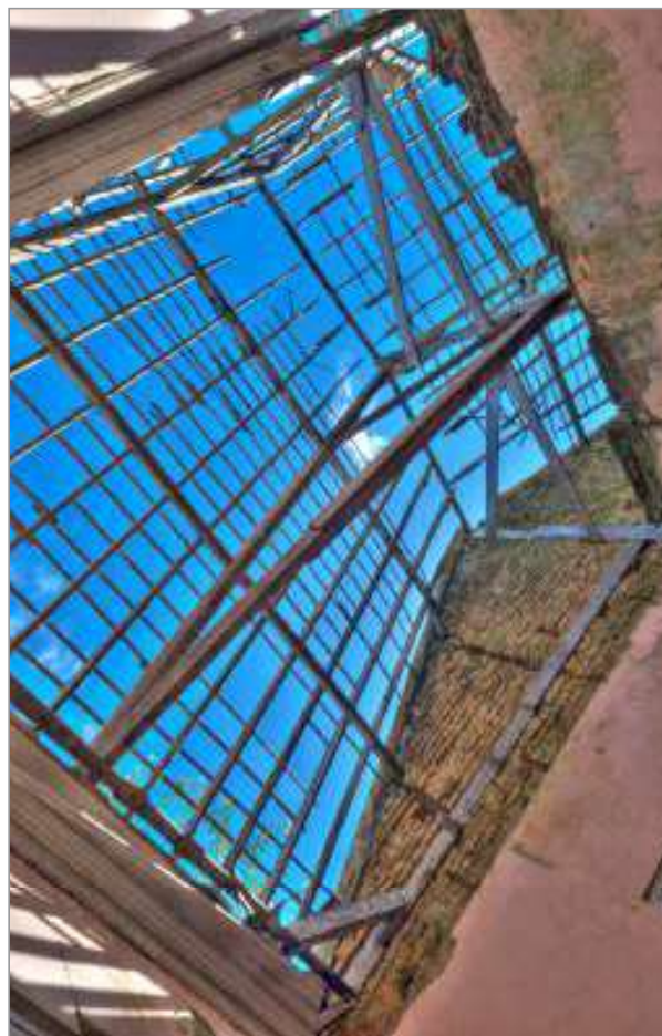
foto 90/168 - Estrutura de telhado em arruinamento sobre o Ambiente 03.
