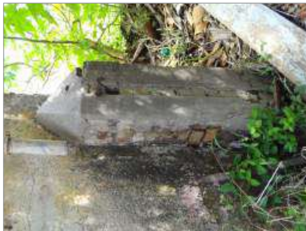
foto 154/168 - Detalhe do pilarete.
