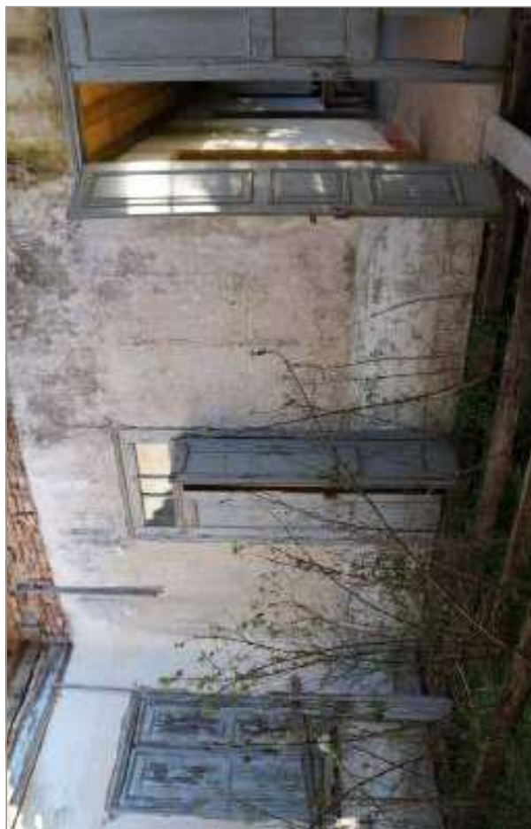
foto 95/168 - Ambiente 04 visto desde a proximidade do Hall.
