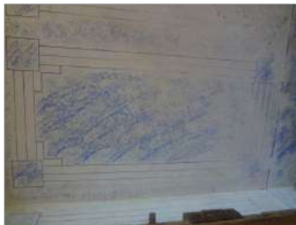
foto 136/168 - Escaiola do banheiro.
