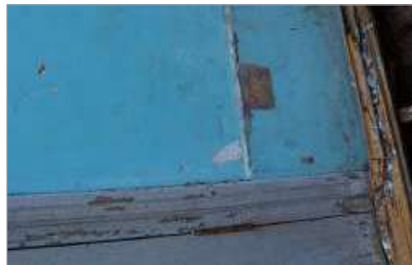
foto 83/168 - Detalhe de rodapé.
