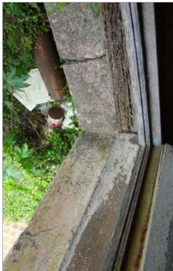
foto 143/168 - Parapeito da janela da cozinha.
