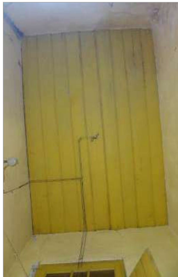
foto 132/168 - Forro do banheiro.
