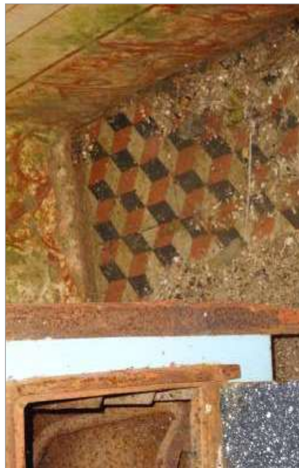
foto 147/168 - Detalhe do canto da cozinha.
