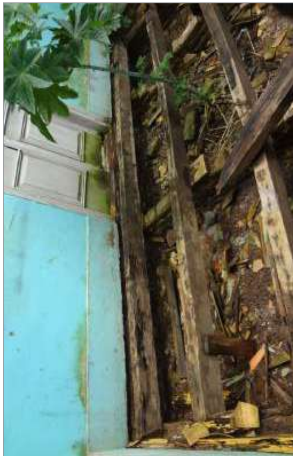
foto 82/168 - Detalhe da estrutura de piso em arruinamento no Ambiente 02.
