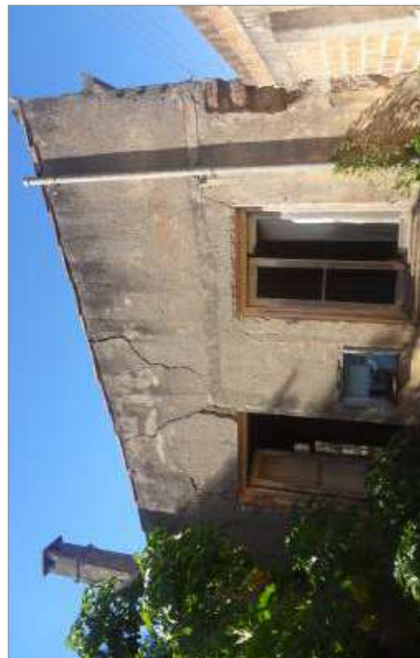
foto 166/168 - Vista da fachada posterior
