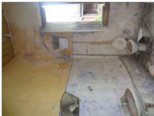
foto 128/168 - Vista parcial do banheiro.
