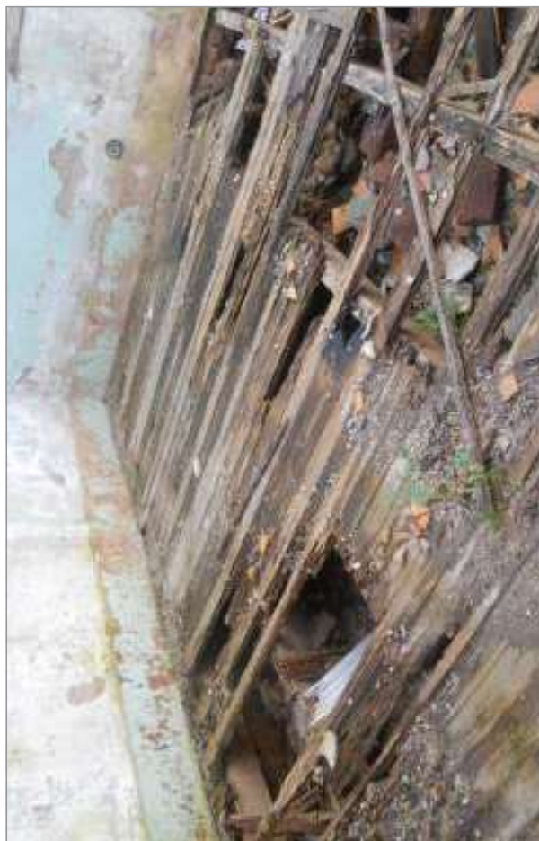
foto 72/168 - Vista do piso do Ambiente 01.
