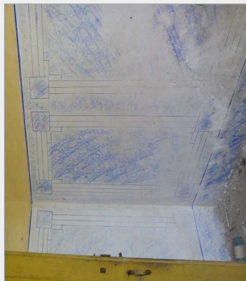
figura 13 – paredes do banheiro em escaiola a ser restaurada
