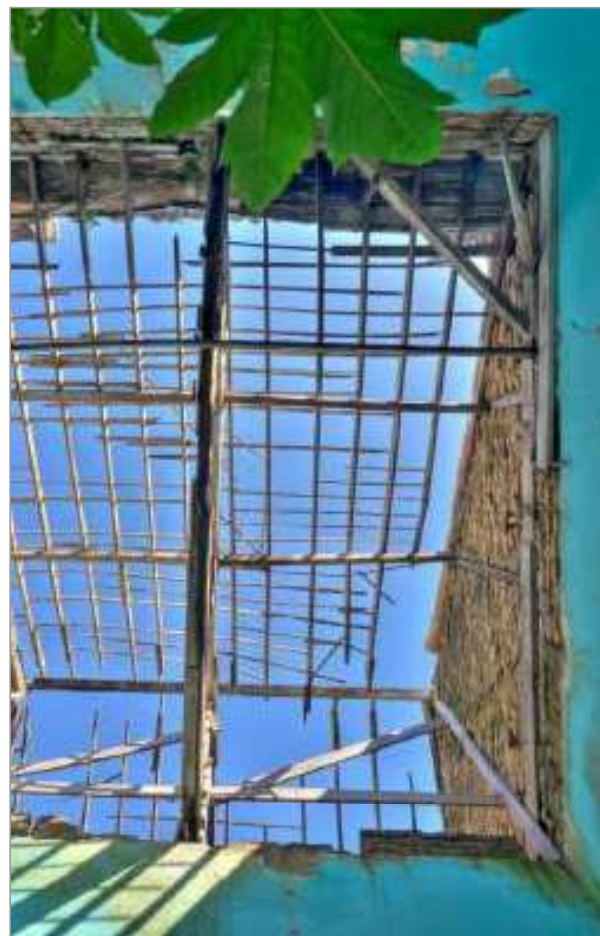
foto 36/168 - Vista do telhado no Ambiente 02.
