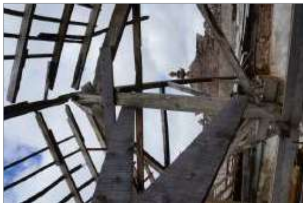
foto 43/168 - Detalhe da estrutura de telhado.
