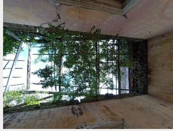
figura 18 – forro metálico do hall a ser completamente refeito
