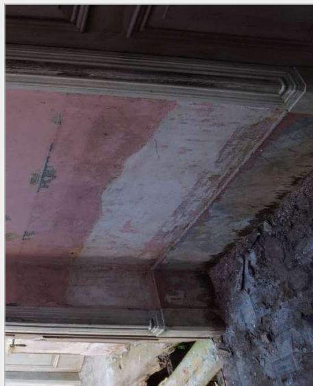
figura 12 – paredes do hall em escada a ser restaurada
