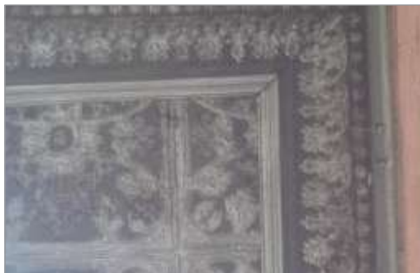
foto 61/168 - Chapa metálica de forro.
