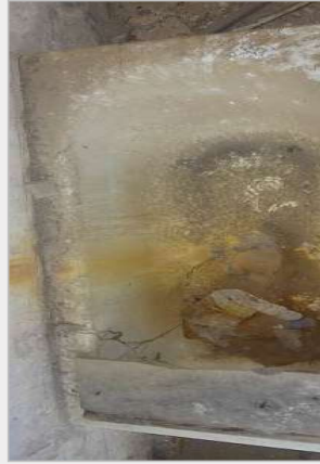
figura 33 – banheira a ser restaurada
