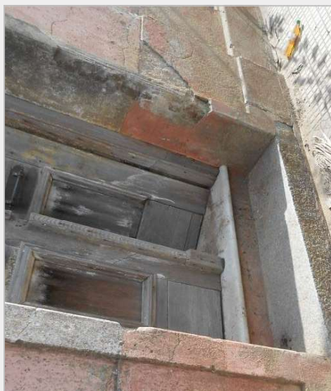
figura 10 – golas das portas a serem restaurados
