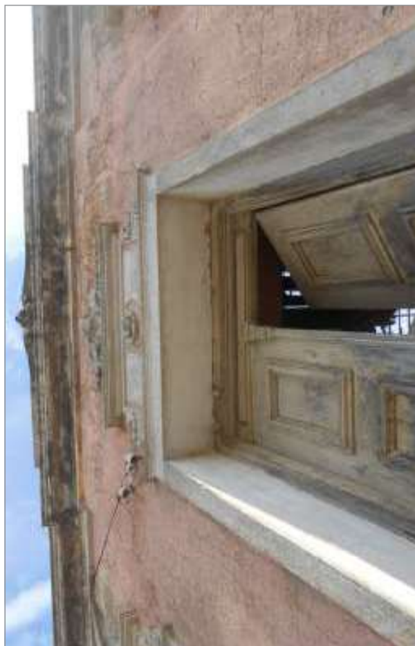
foto 16/168 - Detalhe da entrada principal.
