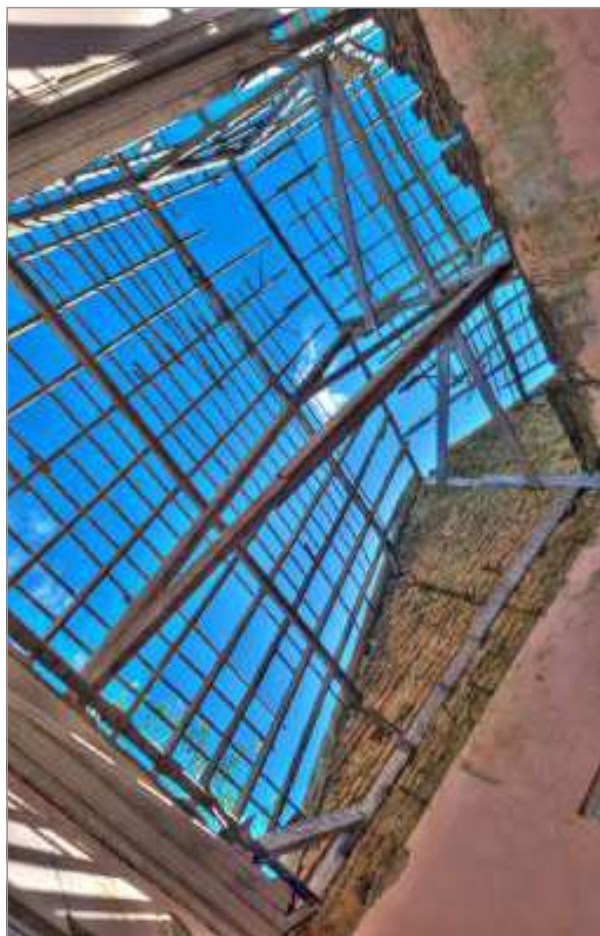
foto 37/168 - Vista do telhado no Ambiente 03.
