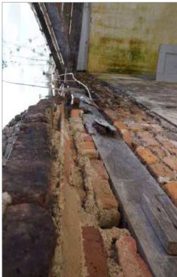
foto 28/168 - Detalhe do apoio do telhado junto á alvenaria.
