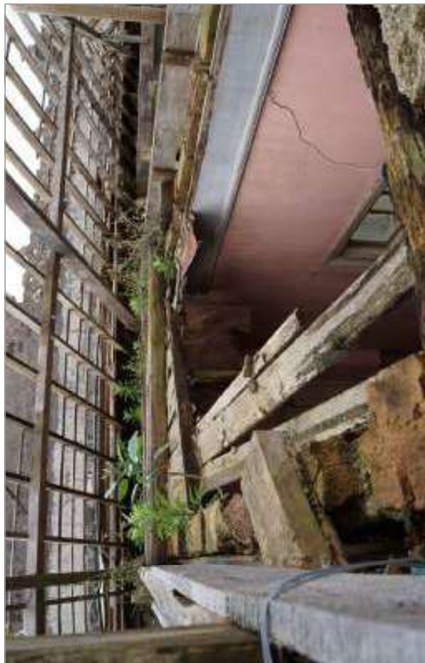
foto 39/168 - Vista da cobertura em arruinamento sobre o Hall.
