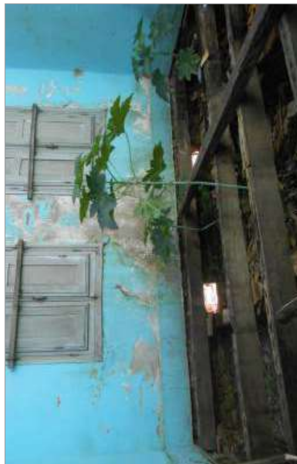
foto 77/168 - Outra vista interna do Ambiente 02.
