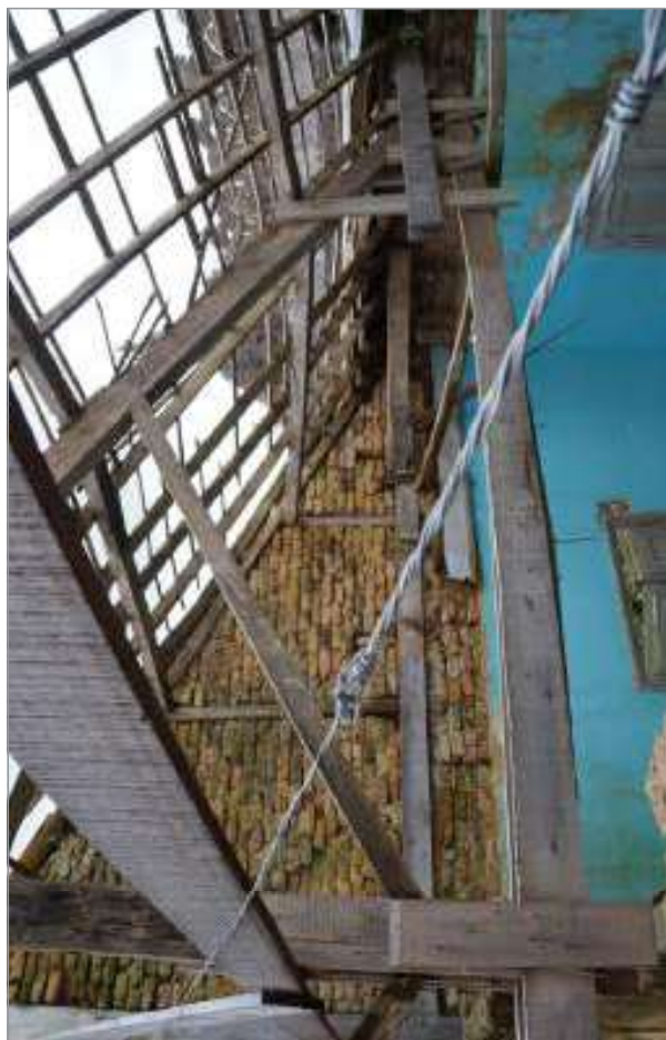
foto 41/168 - Estrutura de telhado em arruinamento sobre o Ambiente 02.
