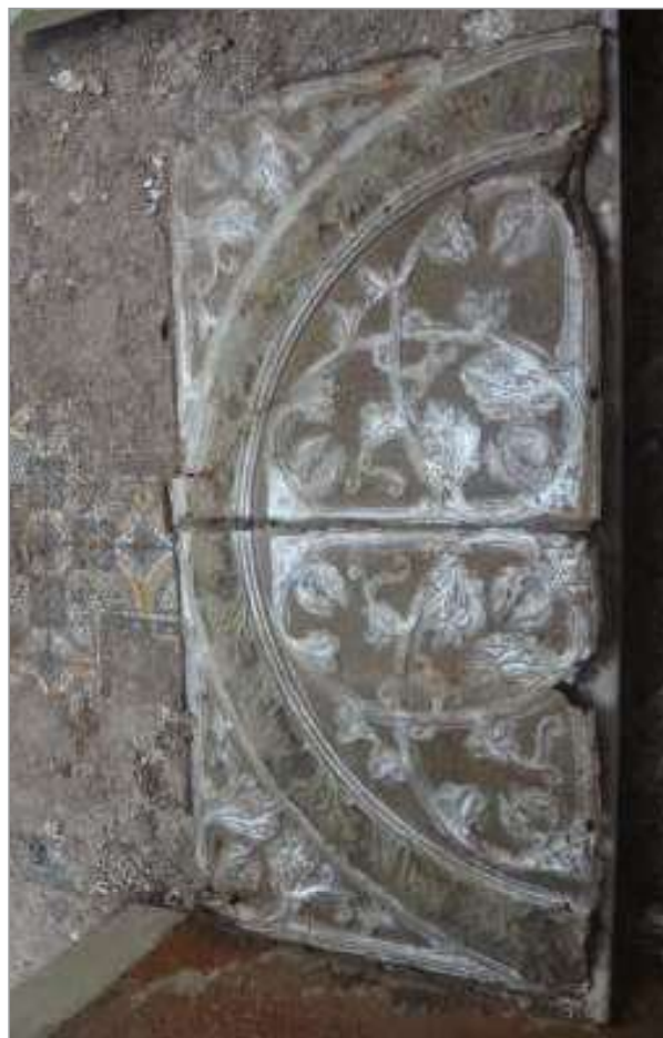
foto 63/168 - Detalhe de duas peças da chapa metálica de forro.
