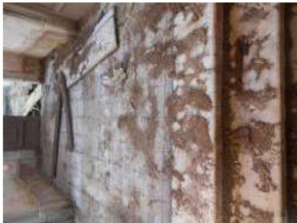
foto 55/168 - Hall: degraus de acesso.
