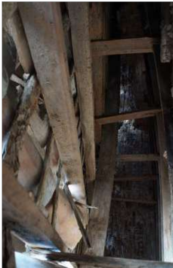
foto 50/168 - Estrutura da cobertura na porção da edificação.
