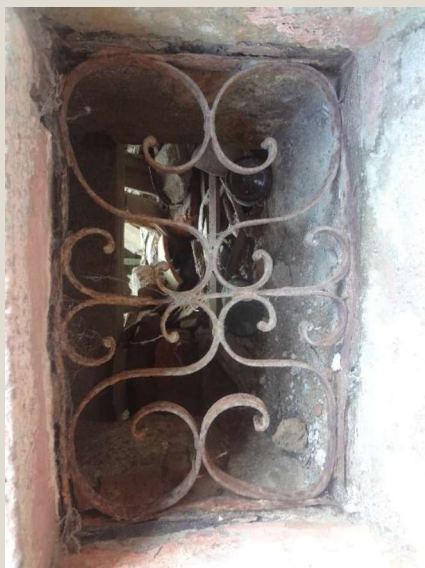
Figura 08 – Foto da gateira existente no prédio Fonte: Foto equipe SNA
