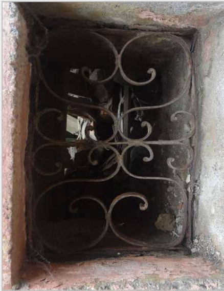
figura 31 – modelo original gateira em ferro a ser restaurada
