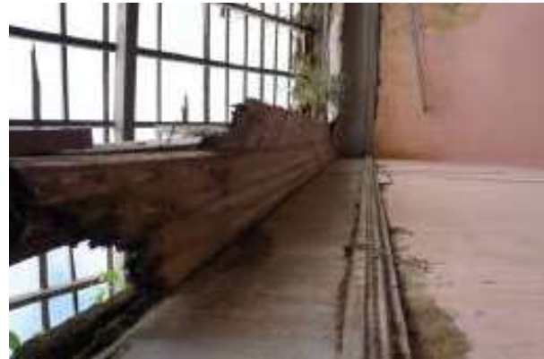
foto 49/168 - Detalhe do Ambiente 03.
