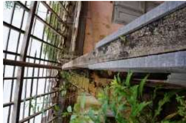
foto 48/168 - Divisa dos ambientes 03 e 04.
