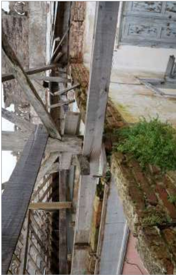
foto 47/168 - Vista da estrutura de telhado.
