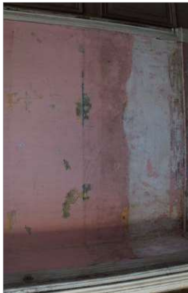
foto 58/168 - Detalhe da parede do Hall.
