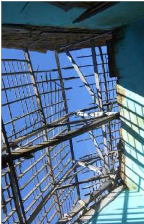
foto 80/168 - Vista da estrutura de telhado remanescente sobre o Ambiente 02.
