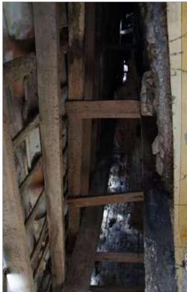
foto 51/168 - Vista da cobertura no outro sentido.
