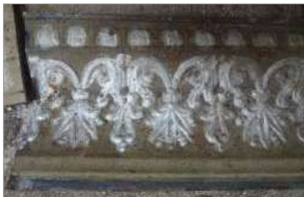
foto 62/168 - Detalhe: chapa de forro.
