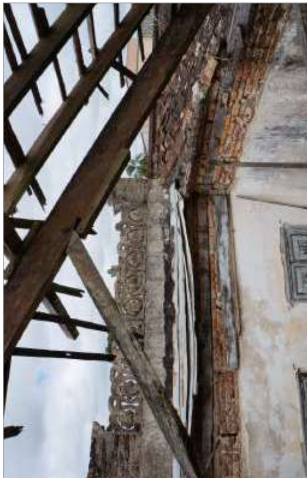
foto 45/168 - Elementos da estrutura do telhado.
