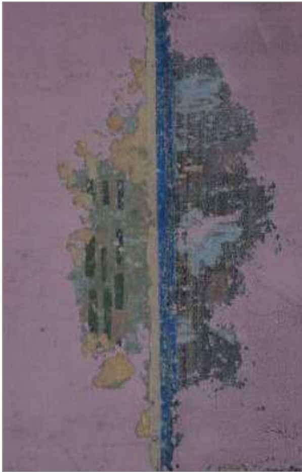
foto 59/168 - Detalhe aproximado da escaiola na parede do Hall.
