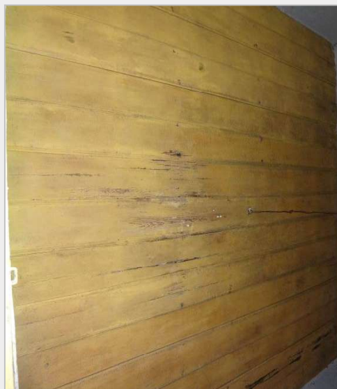
figura 17 – forro tipo saia e camisa a ser restaurado
