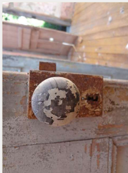
figura 30 – modelo de fechadura tipo bola original a ser executada nova.
