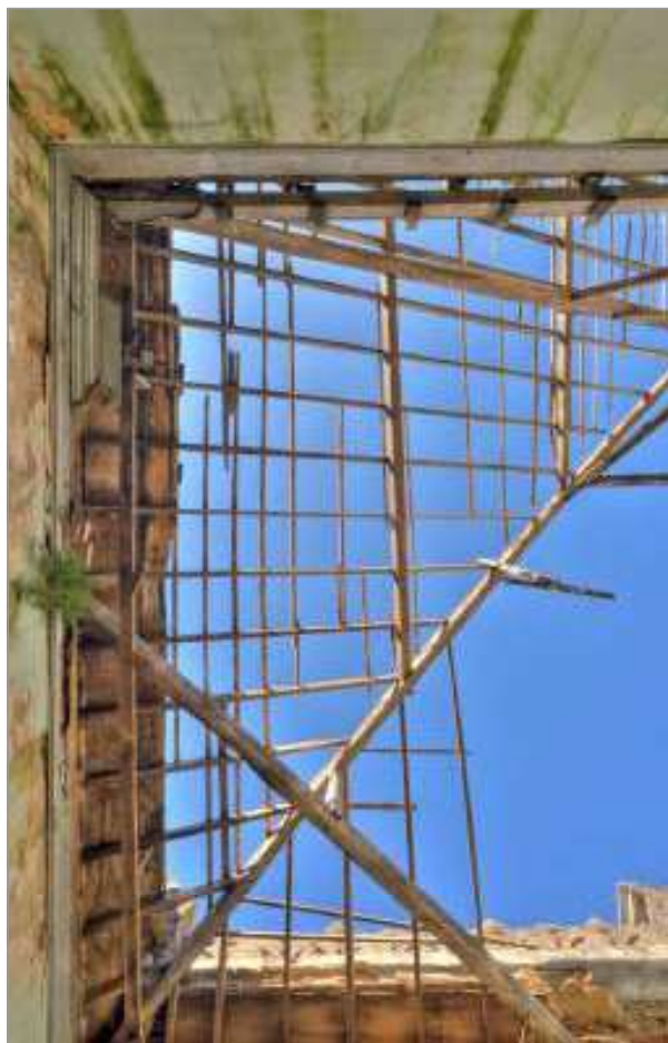
foto 35/168 - Vista do telhado no Ambiente 01.
