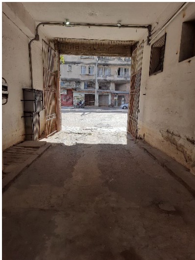
Figura 43 Situação atual do acesso principal.
