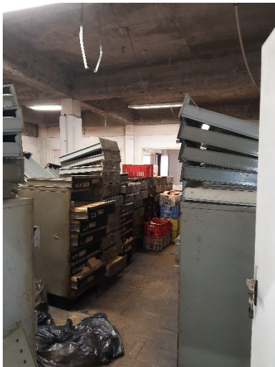
Figura 15 Sala SEMID com acervo destruído pela enchente.
