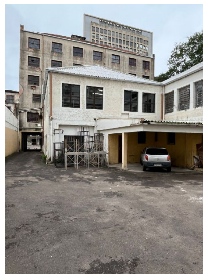
Figura 4 Parte dos prédios anexos com pavilhões e apoios.
