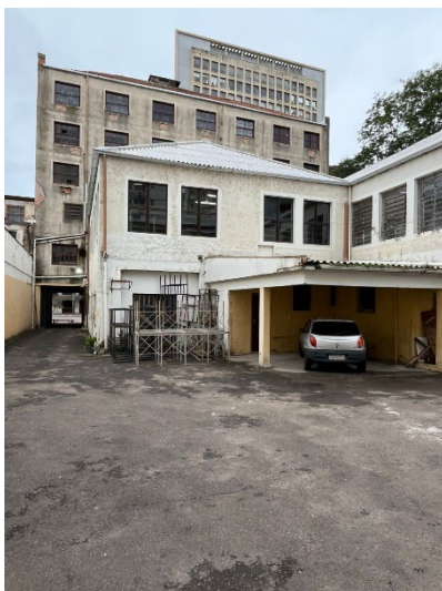
Figura 41 Área coberta que abriga os sanitários.
