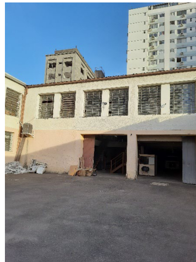
Figura 40 Entulhos e piso sem capeamento adequado.
