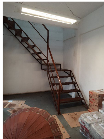
Figura 20 Escada de acesso ao 2º pavimento.
