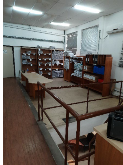
Figura 26 Desnível entre mezaninos.
