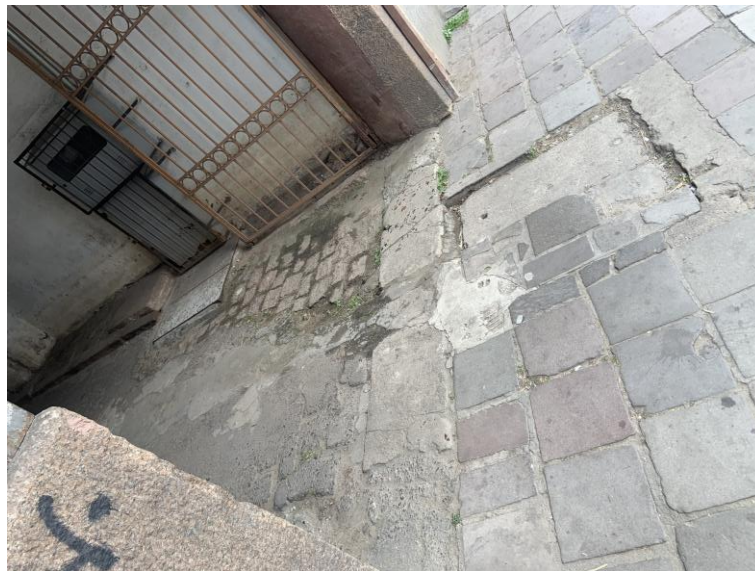
Figura 1 – Medição de energia indireta e caixas de passagem subterrânea
