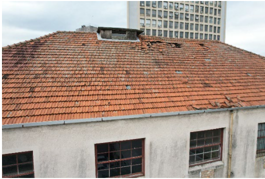
Figura 45 Lacunas e peças soltas sobre o telhado.
