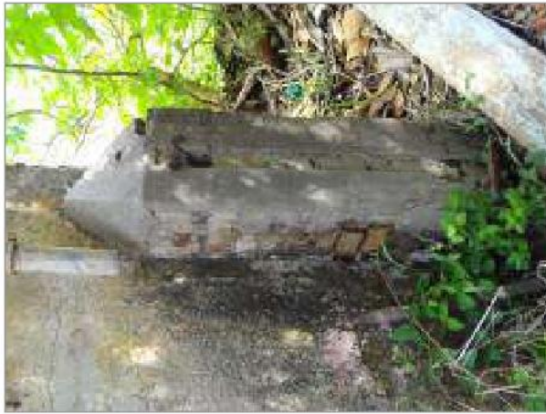
foto 154/168 - Detalhe do pilarete.
