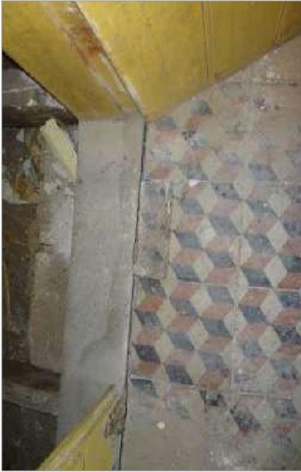
foto 138/168 - Vista da entrada da Cozinha.
