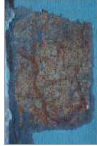
foto 84/168 - Detalhe de escaiola em rodapé.
