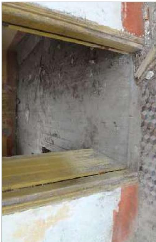
foto 115/168 - Forro do Ambiente 05.
