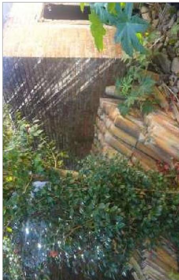
foto 157/168 - Telhas acumuladas junto à garagem.
