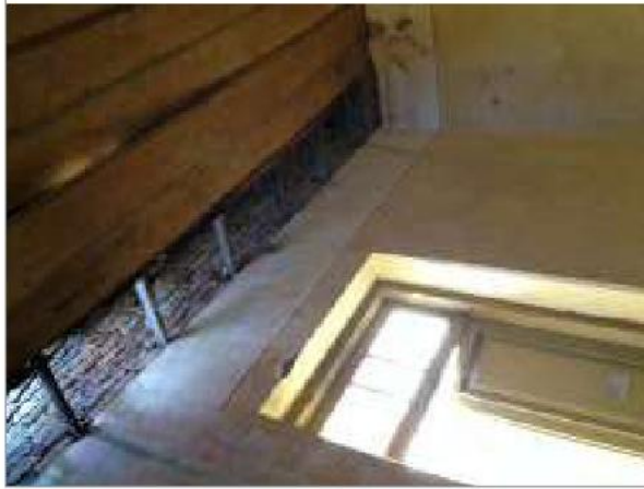
foto 112/168 - Forro do Ambiente 05.
