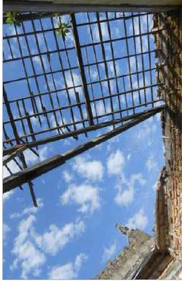
foto 96/168 - Vista da estrutura de telhado em arruamento sobre o Ambiente 04.
