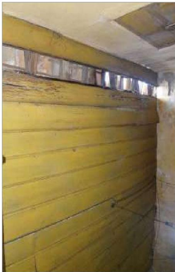
foto 142/168 - Forro da cozinha.
