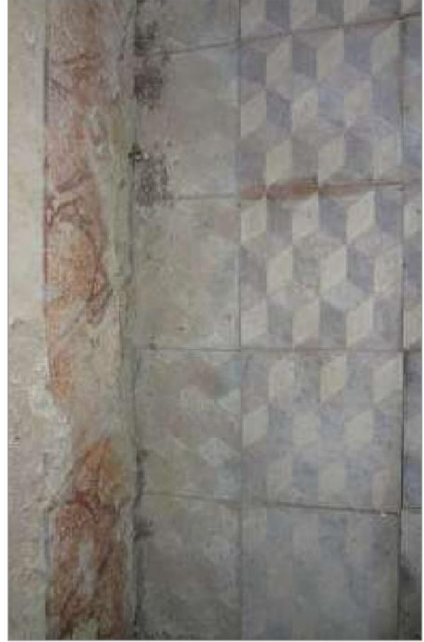
foto 145/168 - Detalhe da escaiola no rodapé da cozinha.
