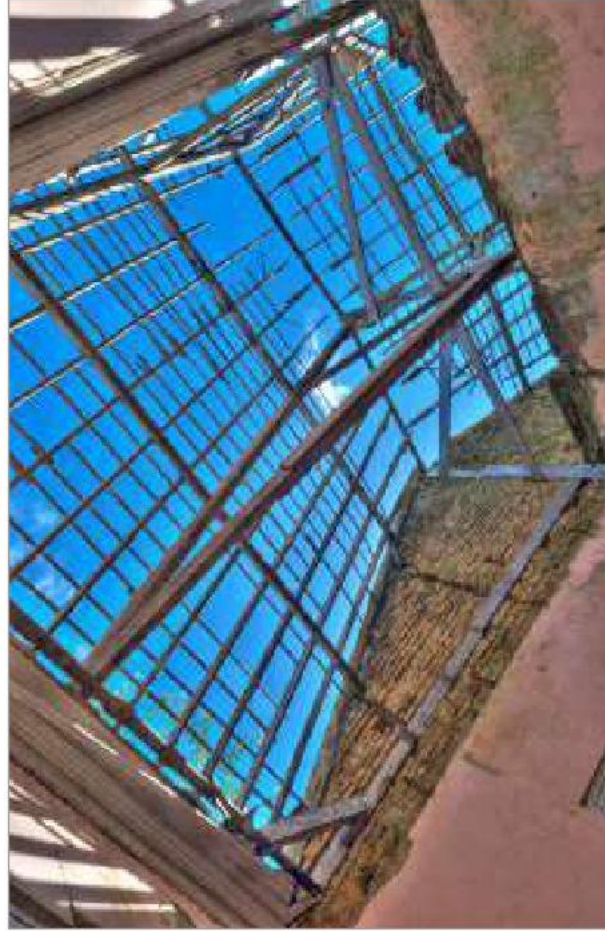
foto 90/168 - Estrutura de telhado em arruamento sobre o Ambiente 03.
