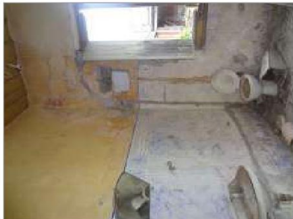
foto 128/168 - Vista parcial do banheiro.
