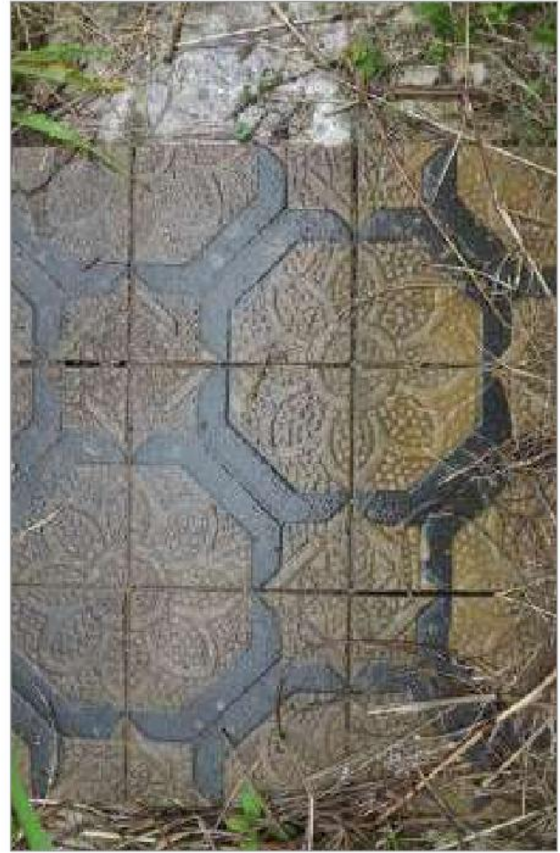
foto 164/168 - Ladrilho hidráulico externo.
