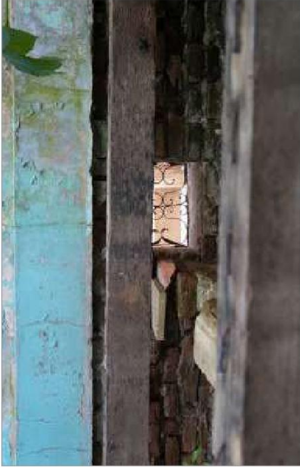
foto 85/168 - Detalhe de estrutura de piso e porão do Ambiente 02.
