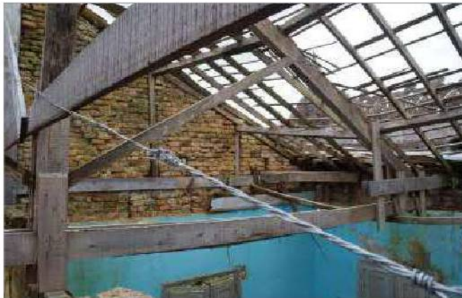
foto 41/168 - Estrutura de telhado em arruamento sobre o Ambiente 02.
