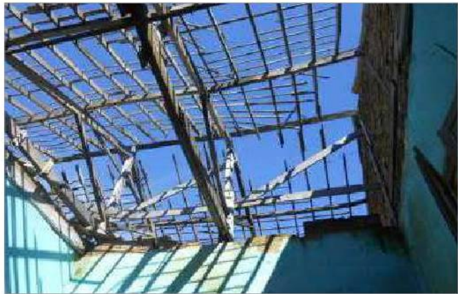
foto 80/168 - Vista da estrutura de telhado remanescente sobre o Ambiente 02.
