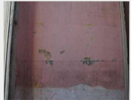
figura 15 – pintura mural do hall a ser restaurada
