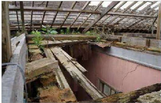
foto 39/168 - Vista da cobertura em arruamento sobre o Hall.
