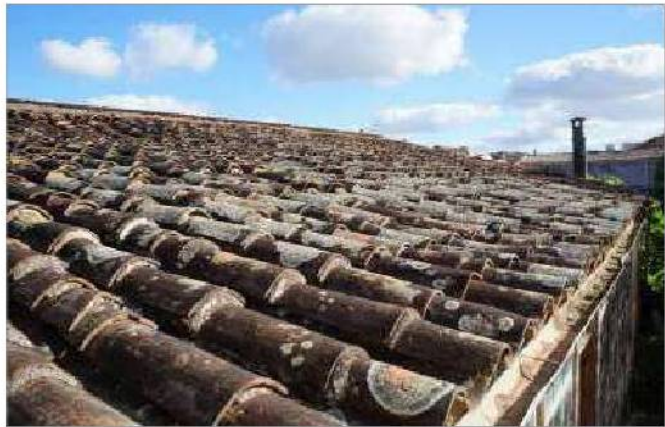
foto 30/168 - Vista do telhado da porção posterior da edificação.
