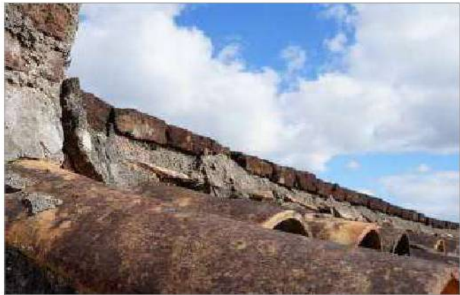
foto 26/168 - Detalhe do telhado e platibanda do volume posterior.
