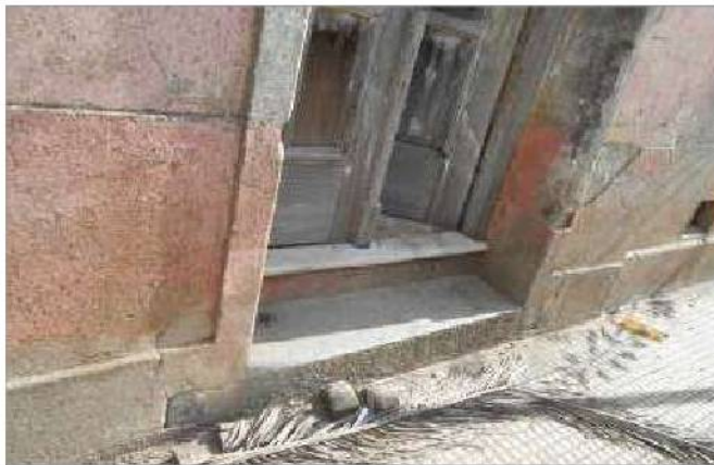
foto 17/168 - Detalhe da soleira da entrada principal.
