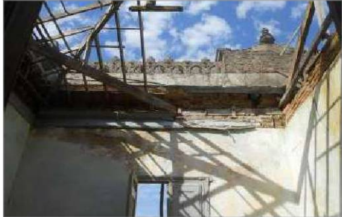
foto 65/168 - Outra vista interna do Ambiente 01, junto à parede lateral da edificação.
