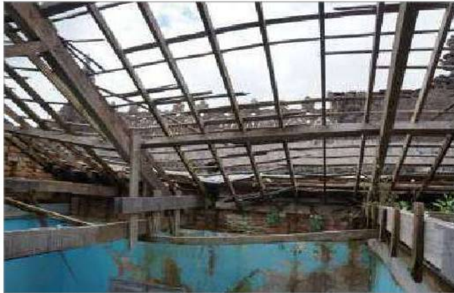
foto 42/168 - Vista da estrutura de telhado sobre o Ambiente 02.
