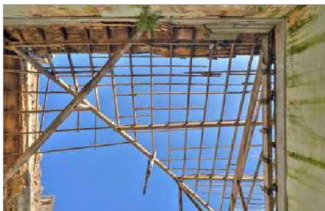
foto 35/168 - Vista do telhado no Ambiente 01.
