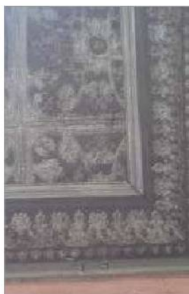
foto 61/168 - Chapa metálica de forro.
