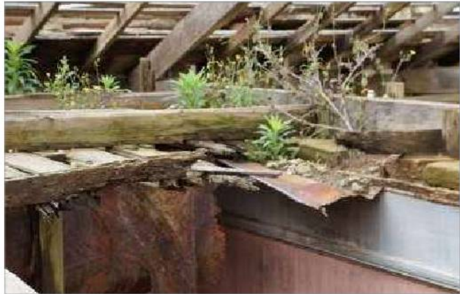
foto 40/168 - Detalhe do forro em arruamento sobre o antigo Hall.
