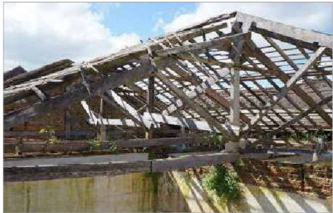
foto 24/168 - Estrutura do telhado.
