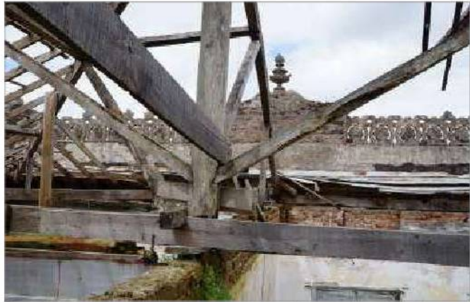
foto 38/168 - Estrutura do telhado sobre a parede divisória dos ambientes 01 e 04.
