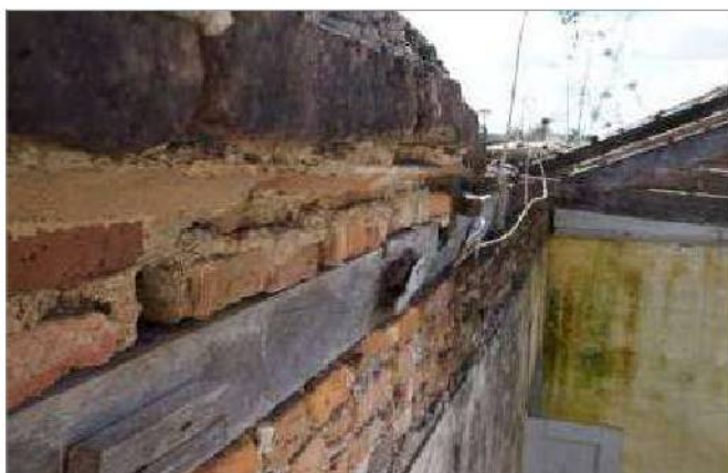
foto 28/168 - Detalhe do apoio do telhado junto à alvenaria.
