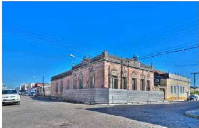
foto 12/168 - Vista geral da edificação.
