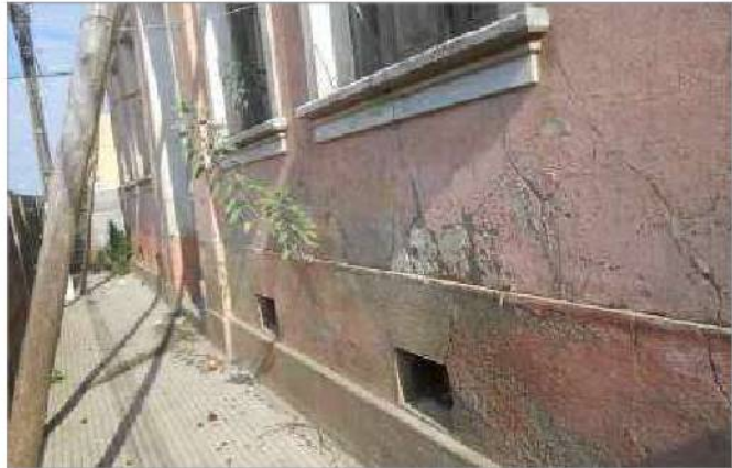
foto 13/168 - Detalhe da fachada principal.
