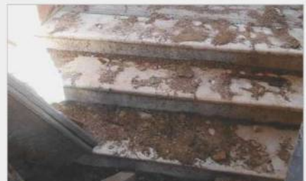
figura 28 – soleira escada hall em mármore a ser restaurada
