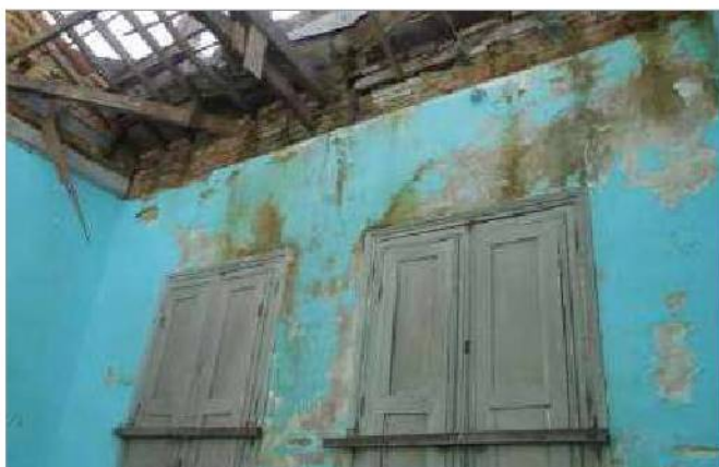
foto 78/168 - Ambiente 02: vista da porção superior da parede interna voltada à fachada.
