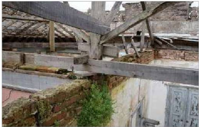
foto 47/168 - Vista da estrutura de telhado.
