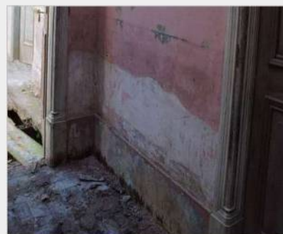
figura 12 – paredes do hall em escaiola a ser restaurada
