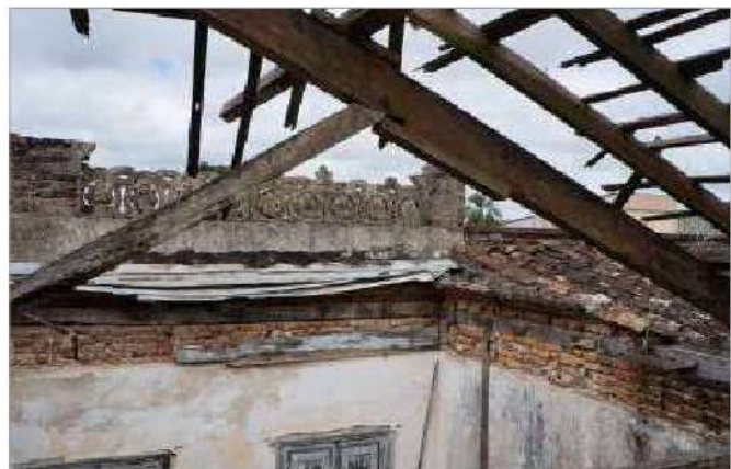
foto 45/168 - Elementos da estrutura do telhado.
