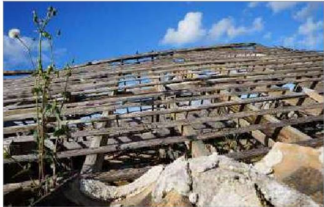
foto 31/168 - Detalhe do telhado da porção anterior.
