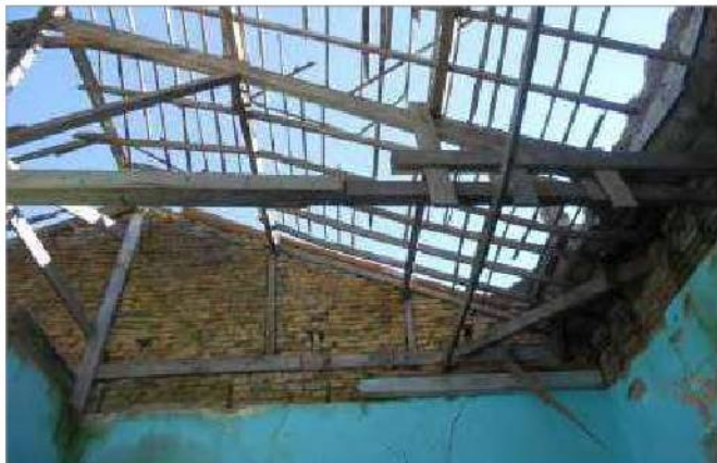
foto 79/168 - Estrutura de telhado remanescente sobre o Ambiente 02.
