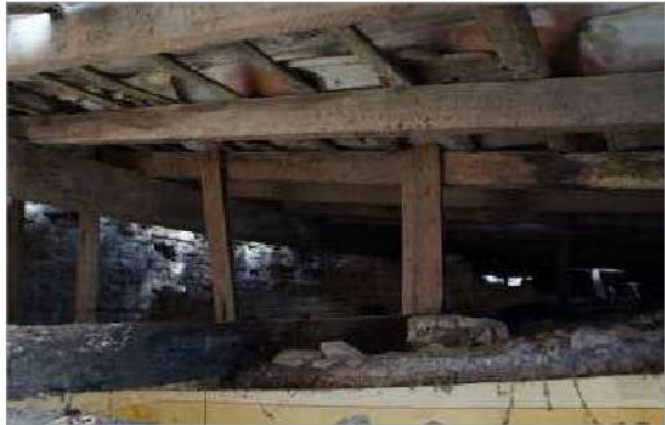
foto 51/168 - Vista da cobertura no outro sentido.
