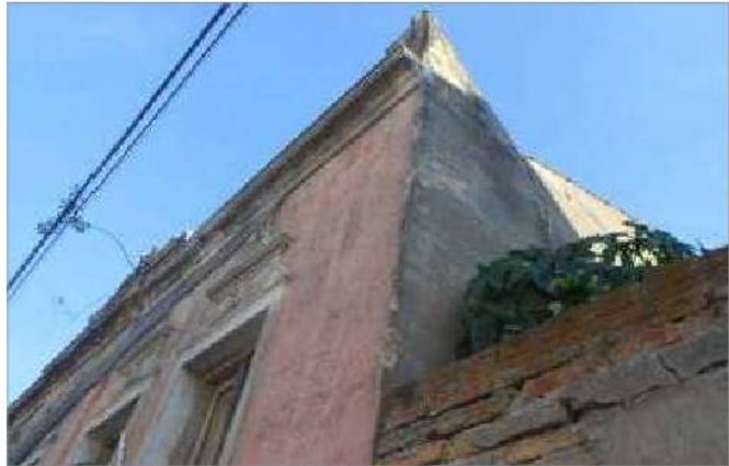
foto 15/168 - Detalhe da fachada principal: extremidade para o interior da quadra.
