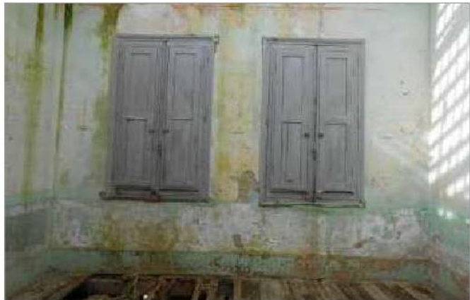
foto 66/168 - Vista interna do Ambiente 01: parede da fachada principal.
