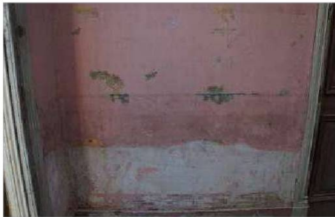
foto 58/168 - Detalhe da parede do Hall.
