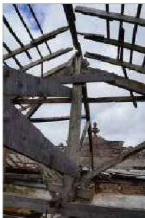
foto 43/168 - Detalhe da estrutura de telhado.
