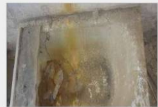
figura 33 – banheira a ser restaurada
