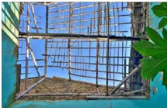
foto 36/168 - Vista do telhado no Ambiente 02.
