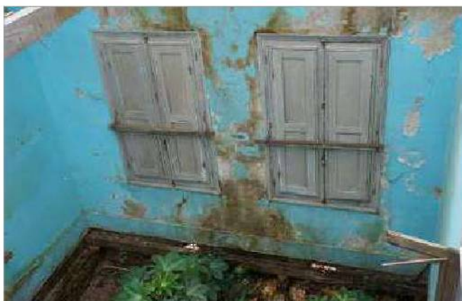
foto 76/168 - Vista interna da parede do Ambiente 02, voltada para a fachada principal.
