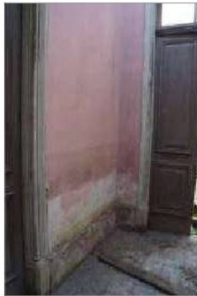
foto 57/168 - Parede do Hall.
