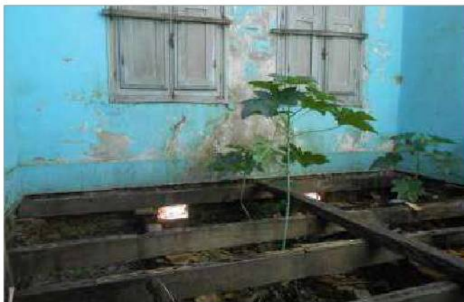
foto 77/168 - Outra vista interna do Ambiente 02.
