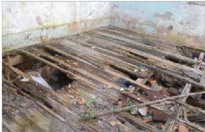
foto 72/168 - Vista do piso do Ambiente 01.
