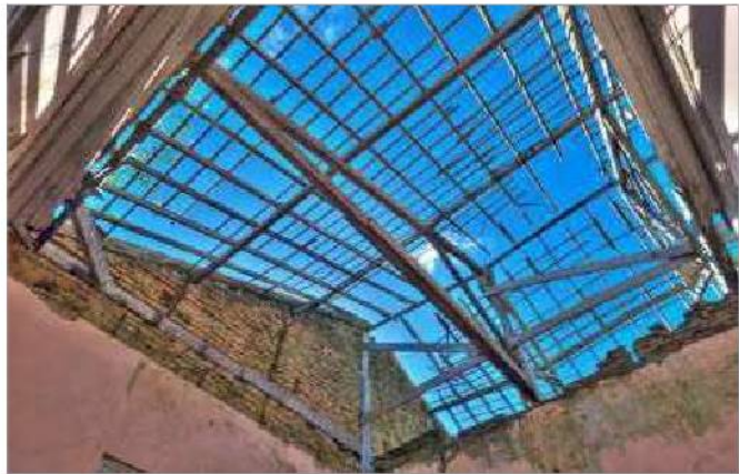
foto 37/168 - Vista do telhado no Ambiente 03.
