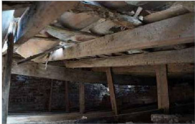
foto 50/168 - Estrutura da cobertura na porção da edificação.
