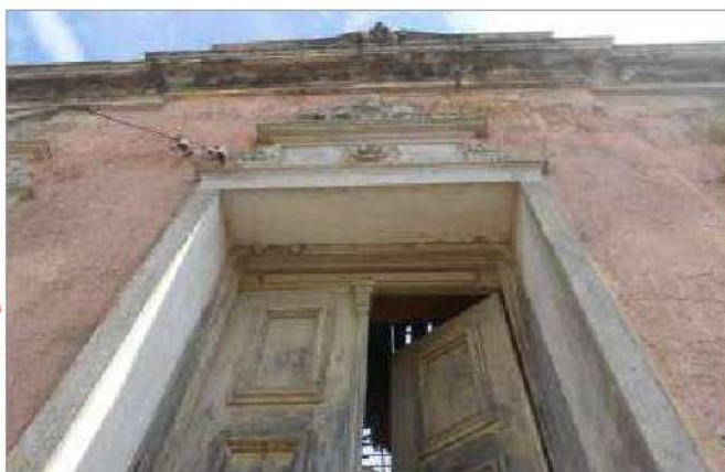
foto 16/168 - Detalhe da entrada principal.
