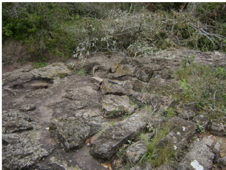
Figura 3.29: Lajeado no leito do arroio a montante do barramento
