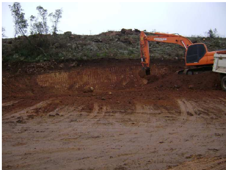
Figura 3.37: Encosta próxima a ombreira esquerda
