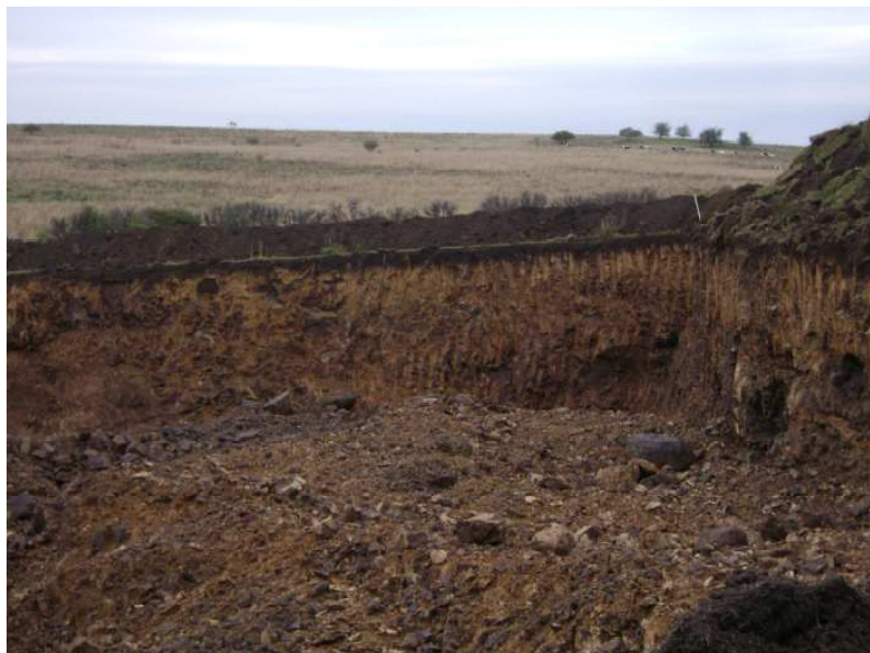
Figura 3.38: Escavação próxima ao britador
