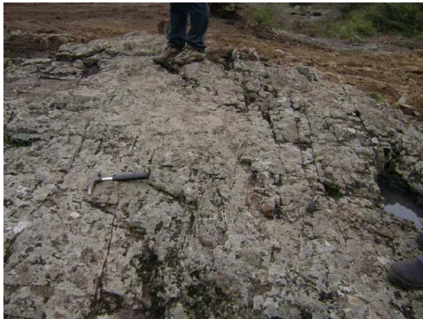
Figura 3.28: Lajeado a montante da ombreira esquerda ao lado do arroio
