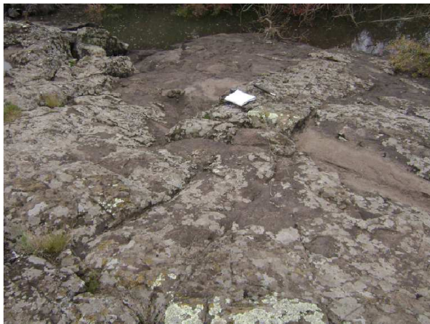
Figura 3.27: Lajeado a montante da ombreira esquerda ao lado do arroio
