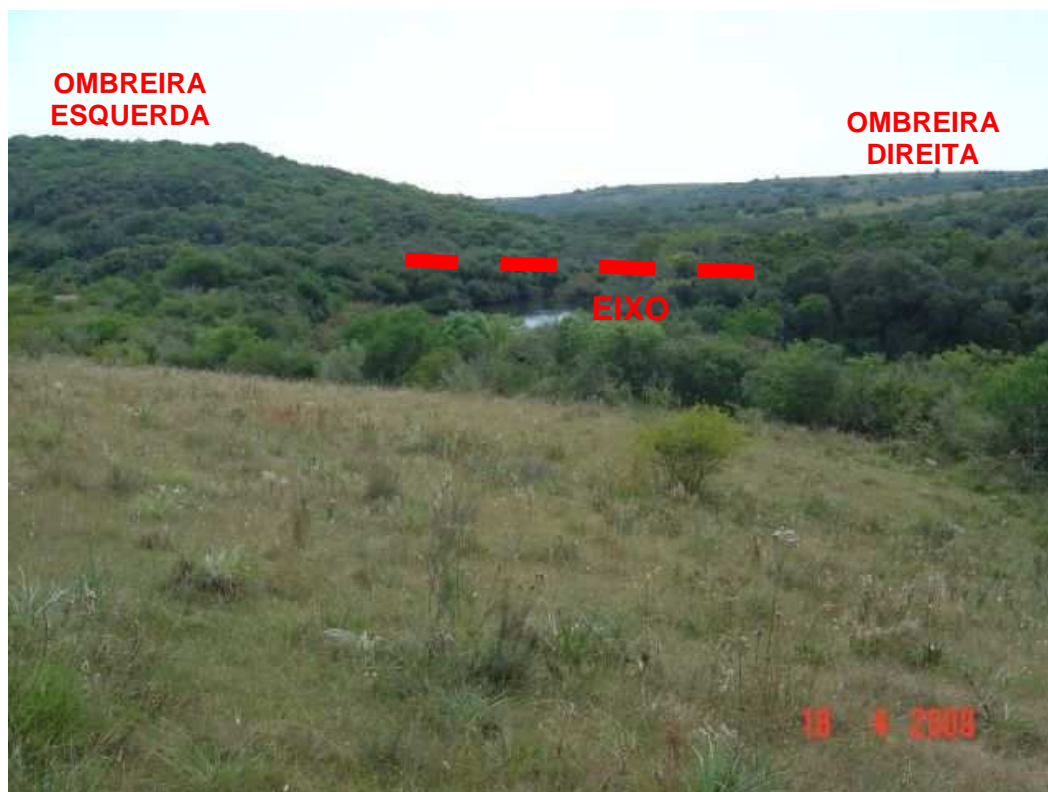
Figura 1.1: Vista de montante para jusante do eixo da futura barragem do Arroio Taquarembó.
