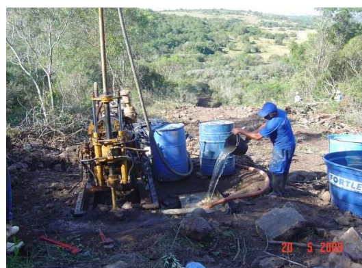
Figura 3.3: Execução do furo SME-07/eixo
