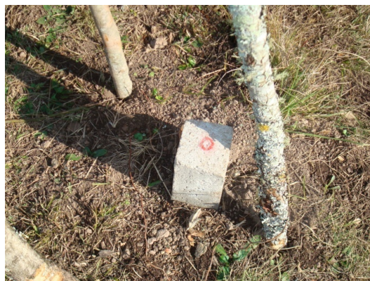
Figura 3.1: Marco M2 implantado na ombreira direita
