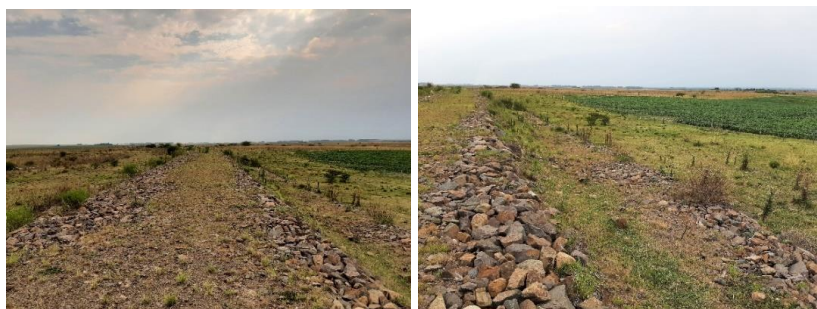
Figura 71 – Aspecto construtivo do dique 1. Imagem direita vista de jusante.
