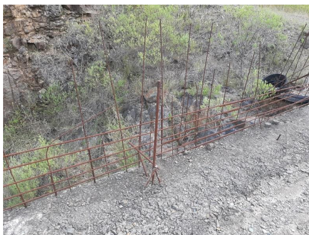
Figura 46 – Detalhe da armadura da face de montante, observada as esperas no topo da barragem.
