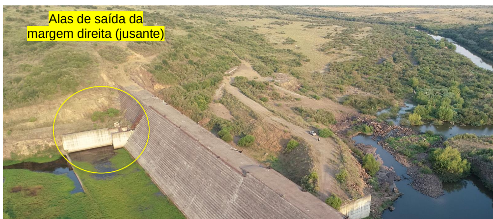
Figura 13 – vista dos taludes da ombreira direita.
