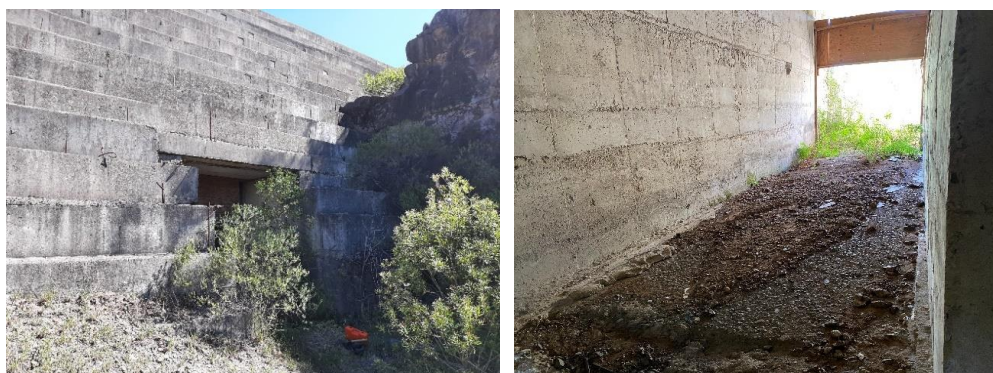
Figura 17 – entradas/saídas da galeria de inspeção e drenagem das fundações.
