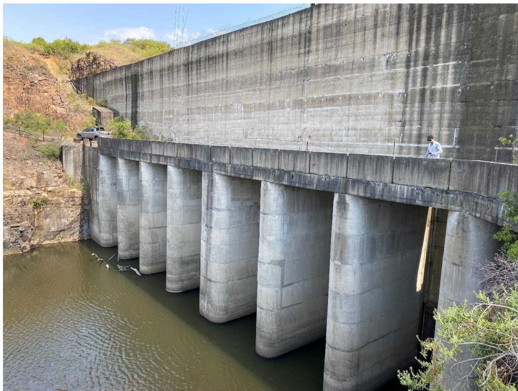
Figura 32 – Face de montante e estrutura de desvio.
