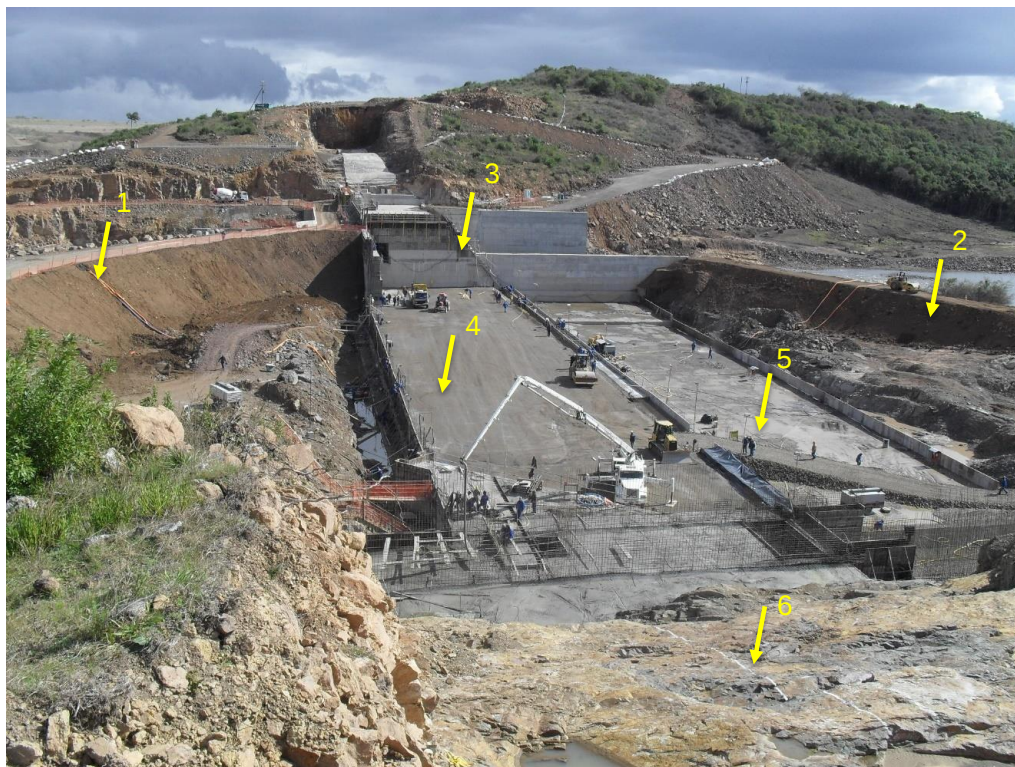
Figura 30 – Segunda etapa sedo alteada após construção da estrutura de desvio (fotos de 2010) – 1 e 2: diques de proteção provisórios; 3: estrutura de desvio; 4: maciço de CCR; 5: bacia de dissipação; 6: rocha (fundações) da obreira direita.
