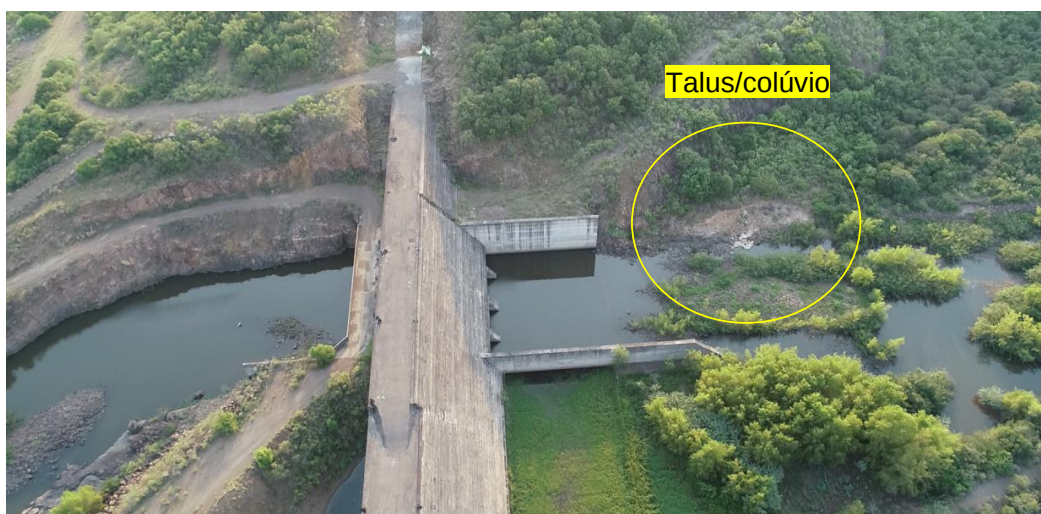
Figura 12 – vista dos taludes da margem esquerda.
