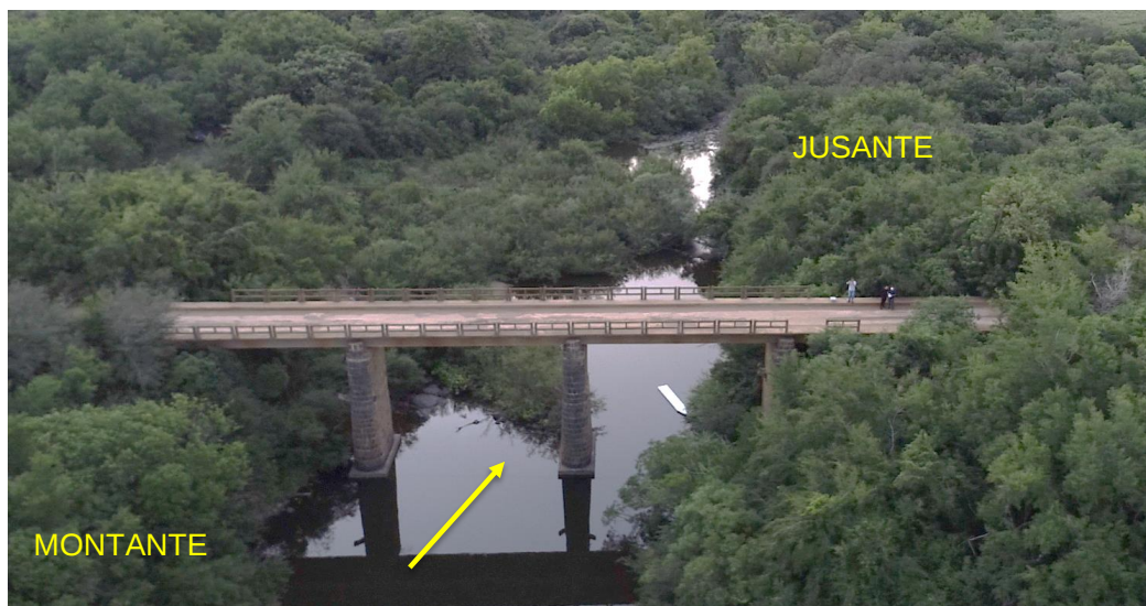
Figura 84 – Vista aérea da ponte sobre o arroio Taquarembó na ERS-630.
