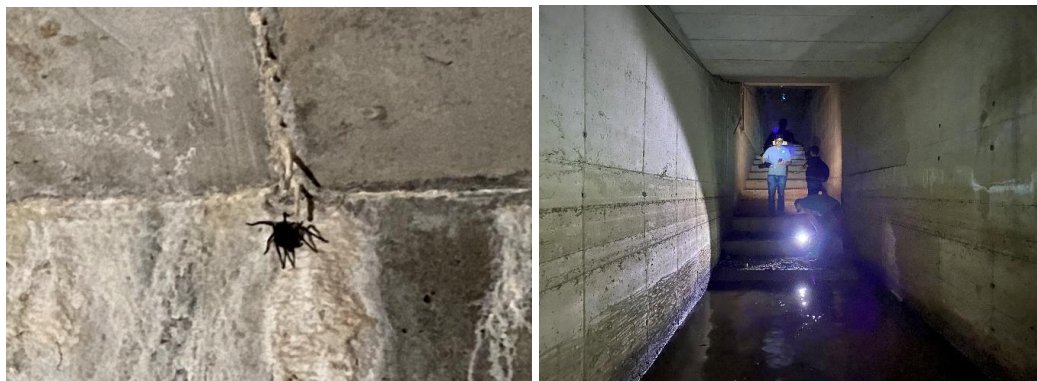
Figura 19 – ambiente interno da galeria de inspeção e drenagem.
