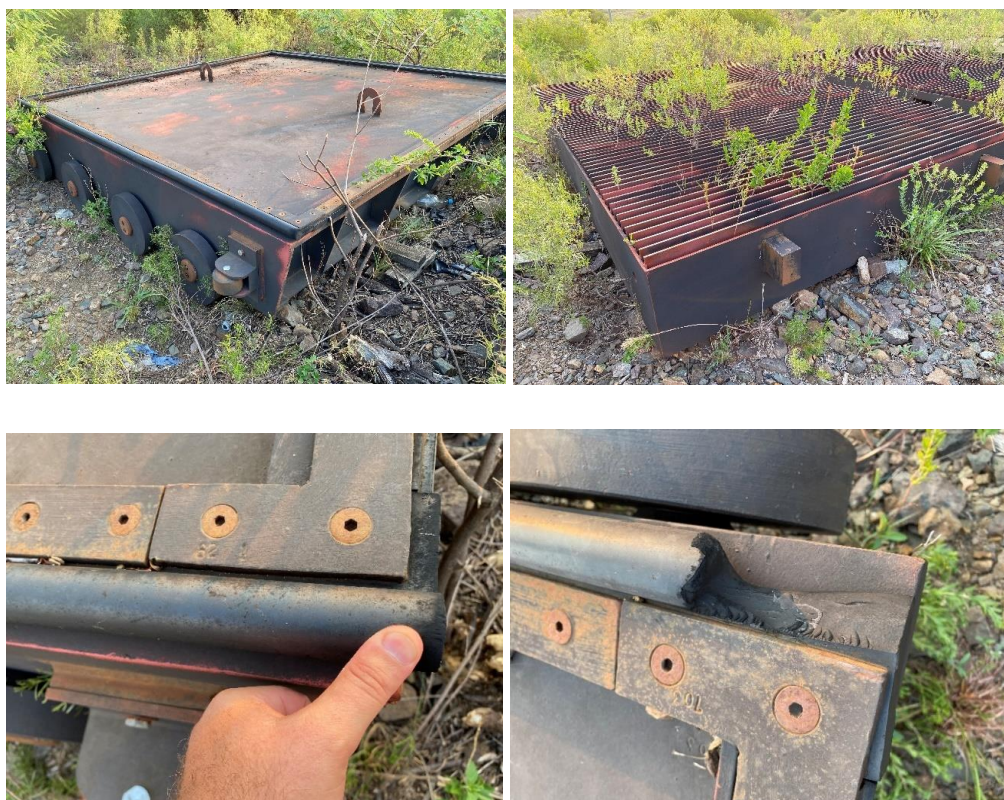
Figura 59 – Peças para a comporta da tomada d'água e adufa.
