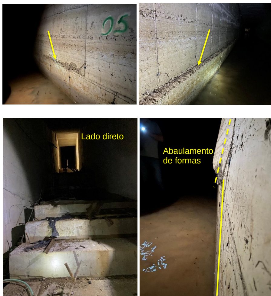
Figura 23 – Aspectos estruturais da galeria.
