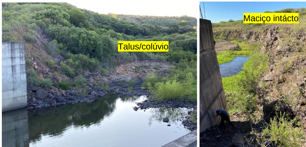
Figura 14 – fotos do talude da margem esquerda (jusante) e direita (jusante), respectivamente.
