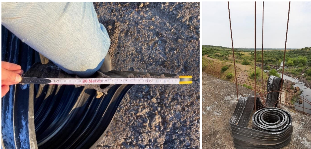
Figura 47 – Veda-juntas Fugenband O-35/10 (marca registrada).
