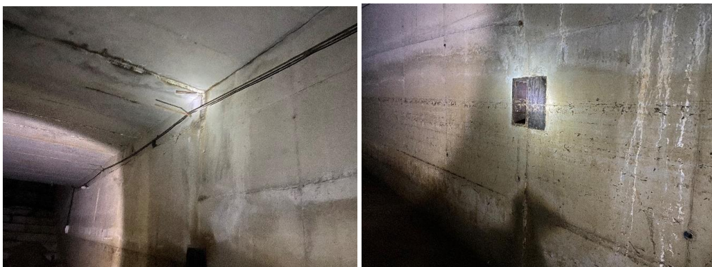
Figura 25 – Aspectos das juntas entre blocos.
