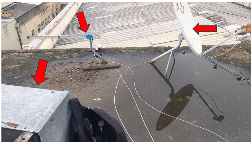
FOTO 5 – REMOVER AS DUAS ANTENAS E O EQUIPAMENTO DE EXAUSTÃO
