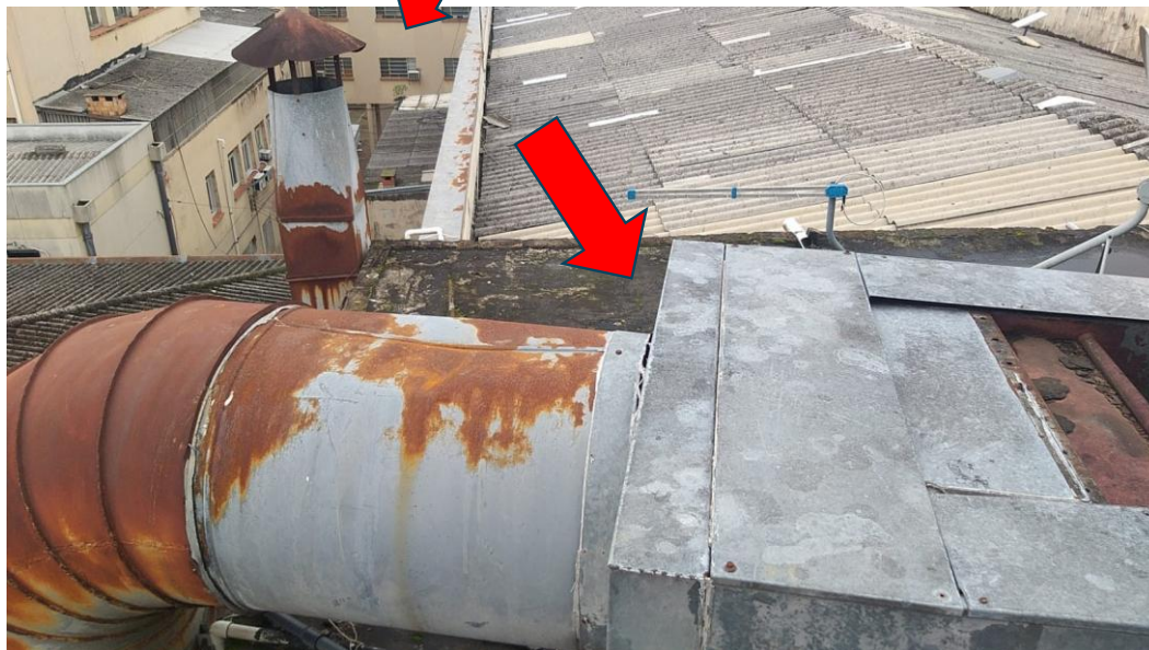
FOTO 6 - À FRENTE VISUALIZA-SE O EQUIPAMENTO A SER REMOVIDO AO FUNDO VERIFICA-SE OS 04 PAVIMENTOS (TÉRREO/TELHADO)/H=19 METROS
