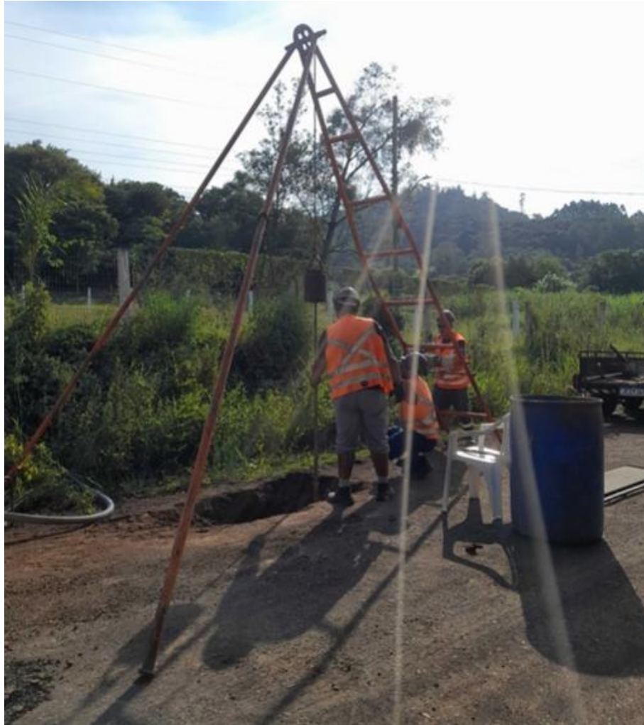
Instalação do furo SP-04
