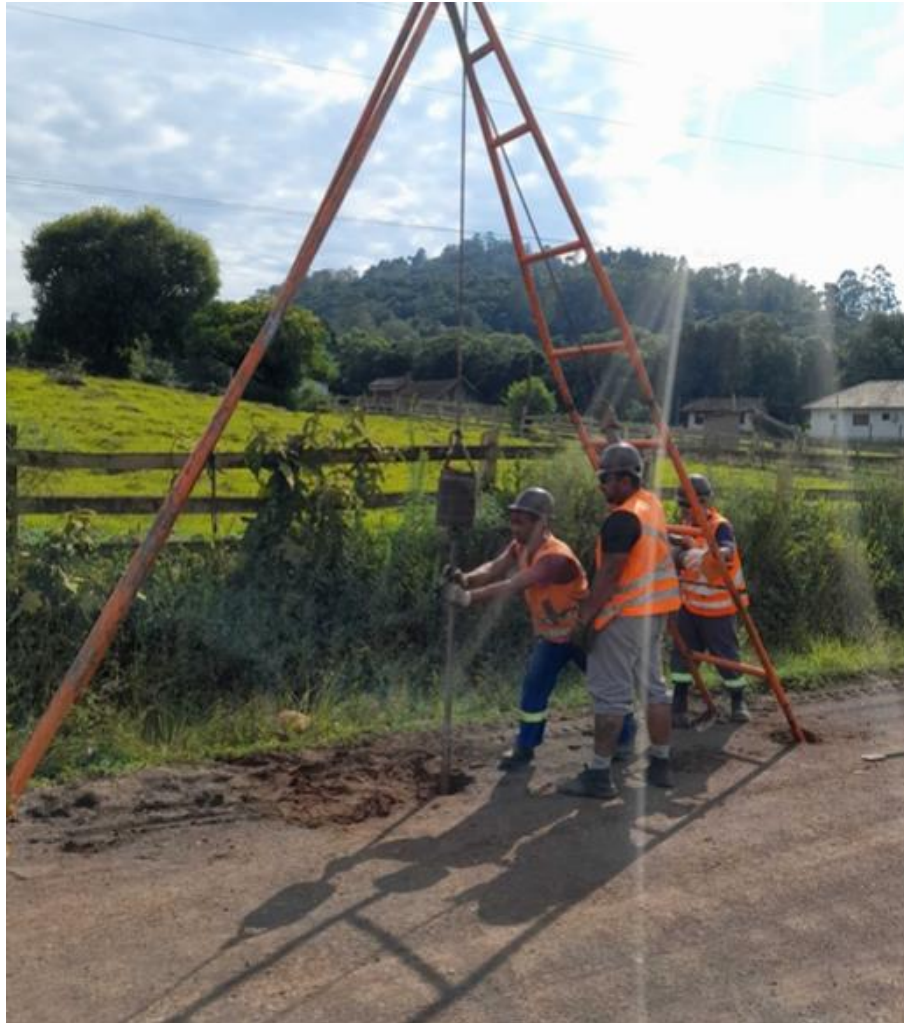
Instalação do furo SP-03 B
