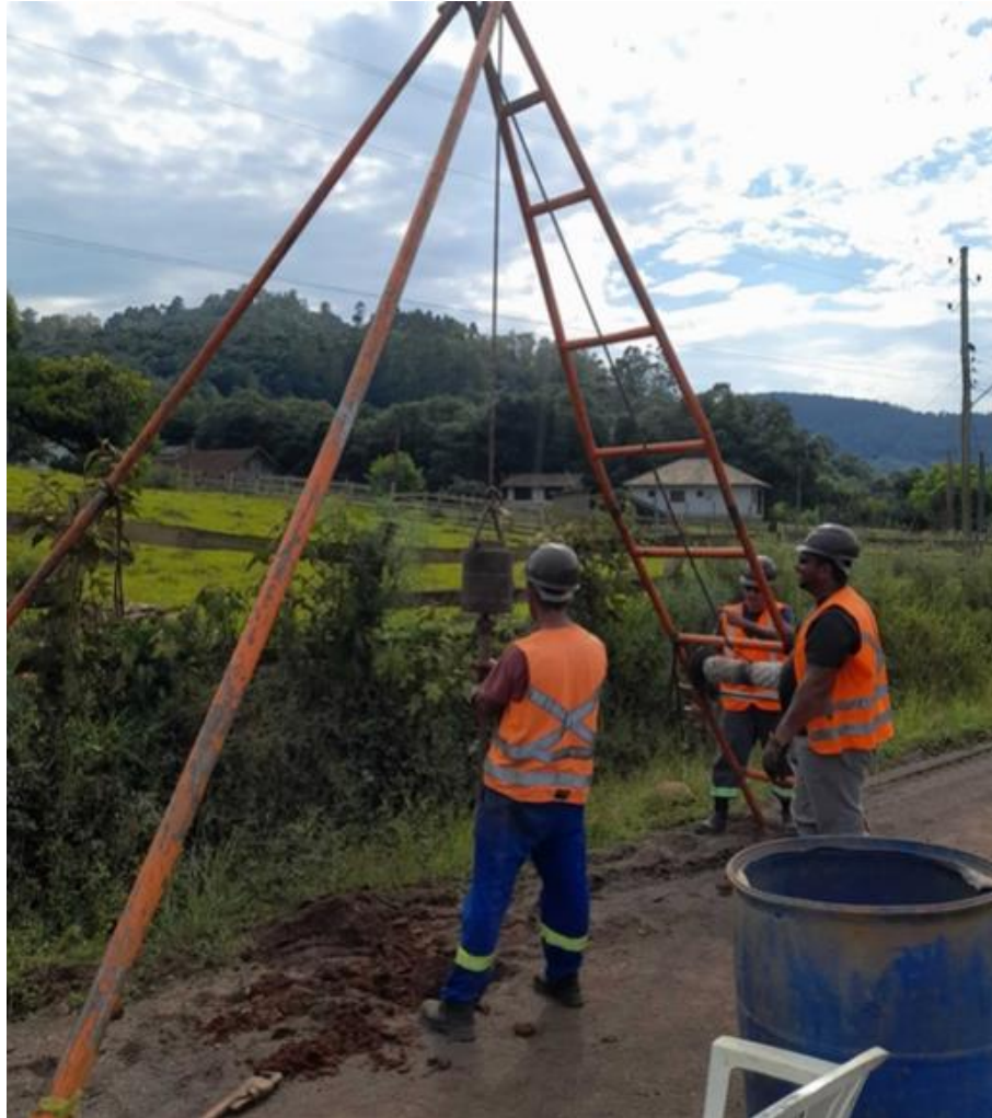
Instalação do furo SP-03 A
