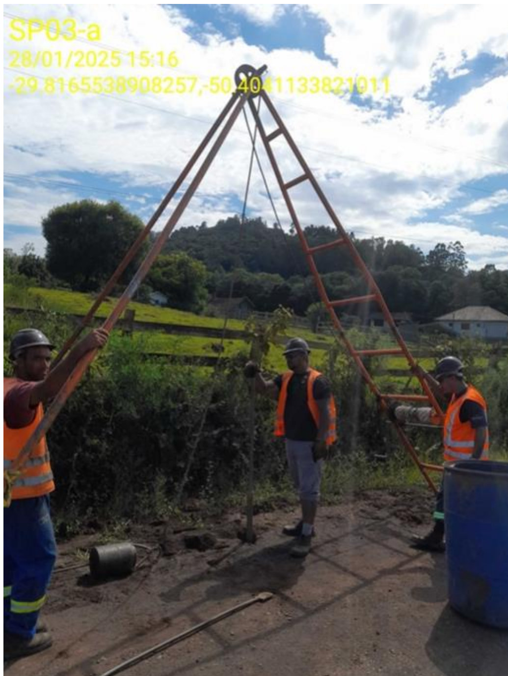
Instalação do furo SP-03
