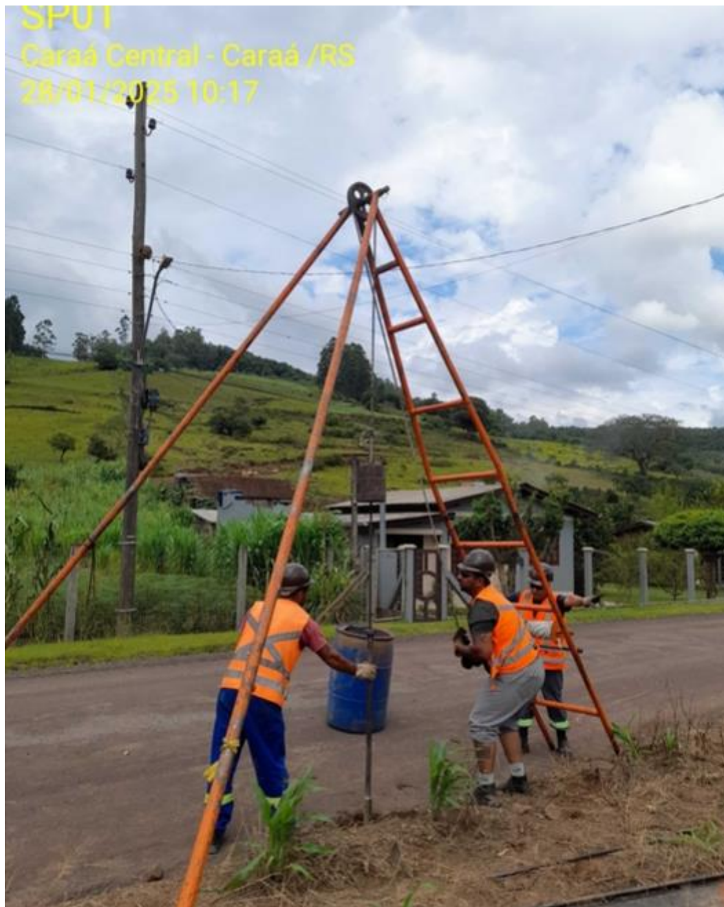
Instalação do furo SP-01
