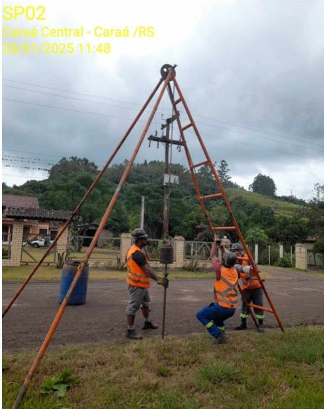
Instalação do furo SP-02
