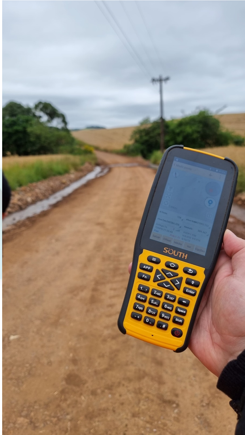
Foto 2 - Execução de levantamento topográfico com RTK (Rover).
