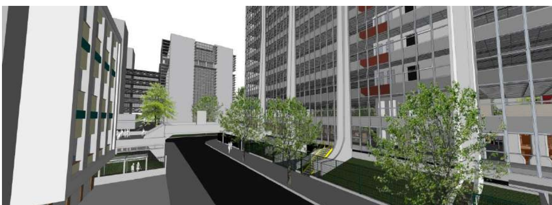
Imagem que ilustra a fachada oeste do edifício a partir da Rua Vicente de Paula Dutra.
