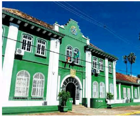
Mesmo com a demolição, a fachada do batalhão será preservada
