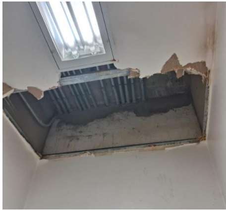
Imagem 3 – Forro da sala escura 01
