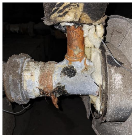
Imagem 84 - Tubulação de AG com oxidação
