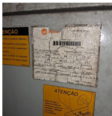
Imagem 88 - Especificação do Fan Coil
