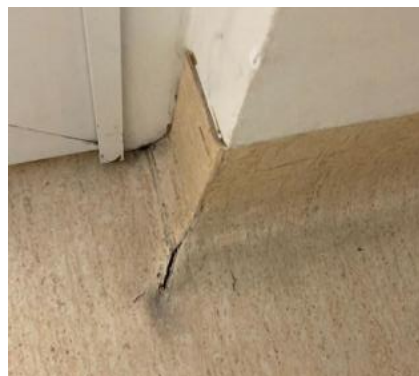
Imagem 14 - Piso e rodapé deficiente - NB2
