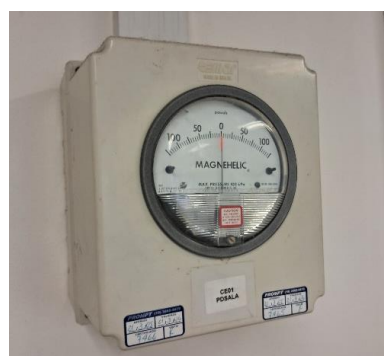
Imagem 22 - Manômetro diferencial de pressão
