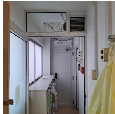
Imagem 25 - Entrada sala eclusa e esquadrias com sistema para abertura.
