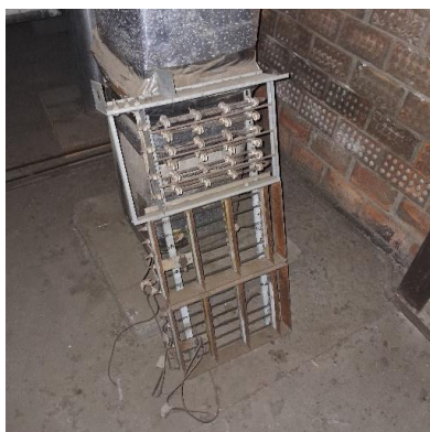
Imagem 87 - Resistência retirada do Fan Coil 01
