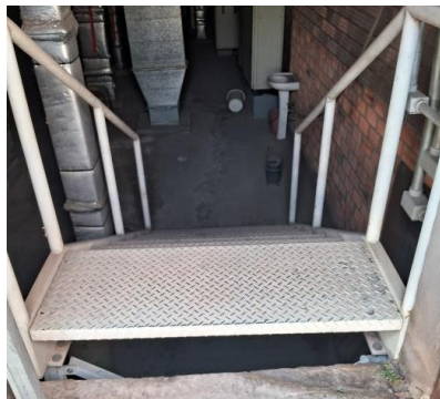
Imagem 75 - Escada com degrau elevado
