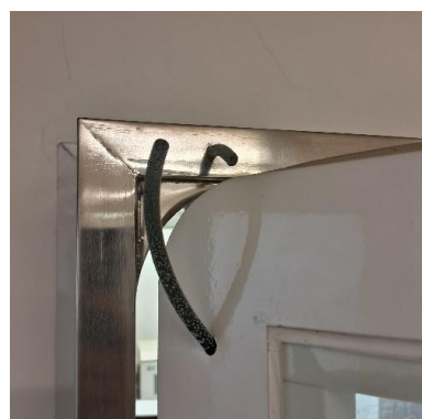
Imagem 41 - Passthrough inoperante - NB3
