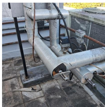
Imagem 61 - Sistema de água gelada inoperante
