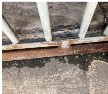
Imagem 76 - Grade de acesso em tubo
