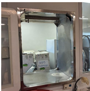
Imagem 40 - Passthrough inoperante - NB3
