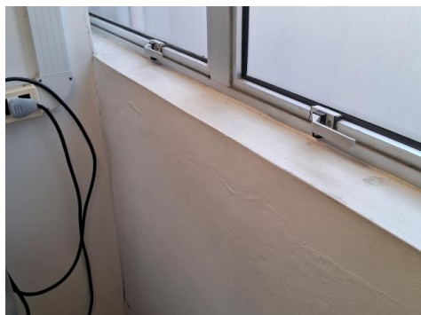
Imagem 8 - Parede com bolhas - NB2
