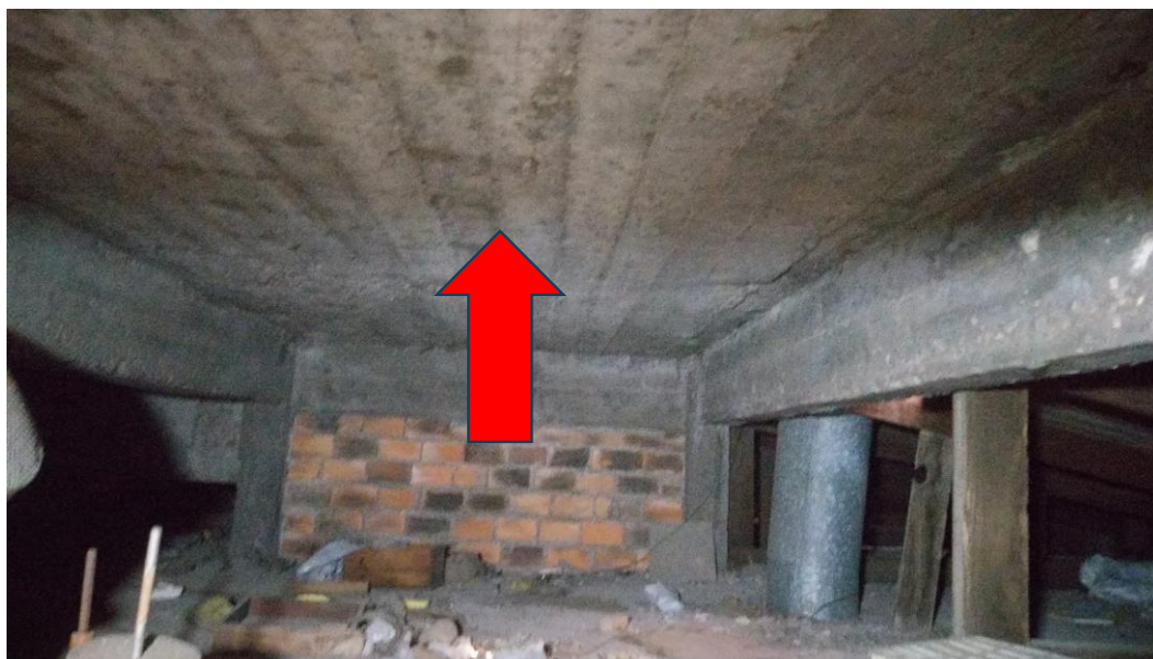
FOTO 4 – FACE INFERIOR DA LAJE DE FUNDO DO RESERVATÓRIO
