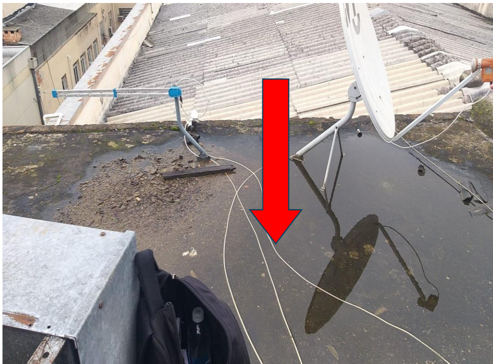
FOTO 3 – FACE SUPERIOR DA TAMPA A SER APLICADA MANTA ARDOSIADA
