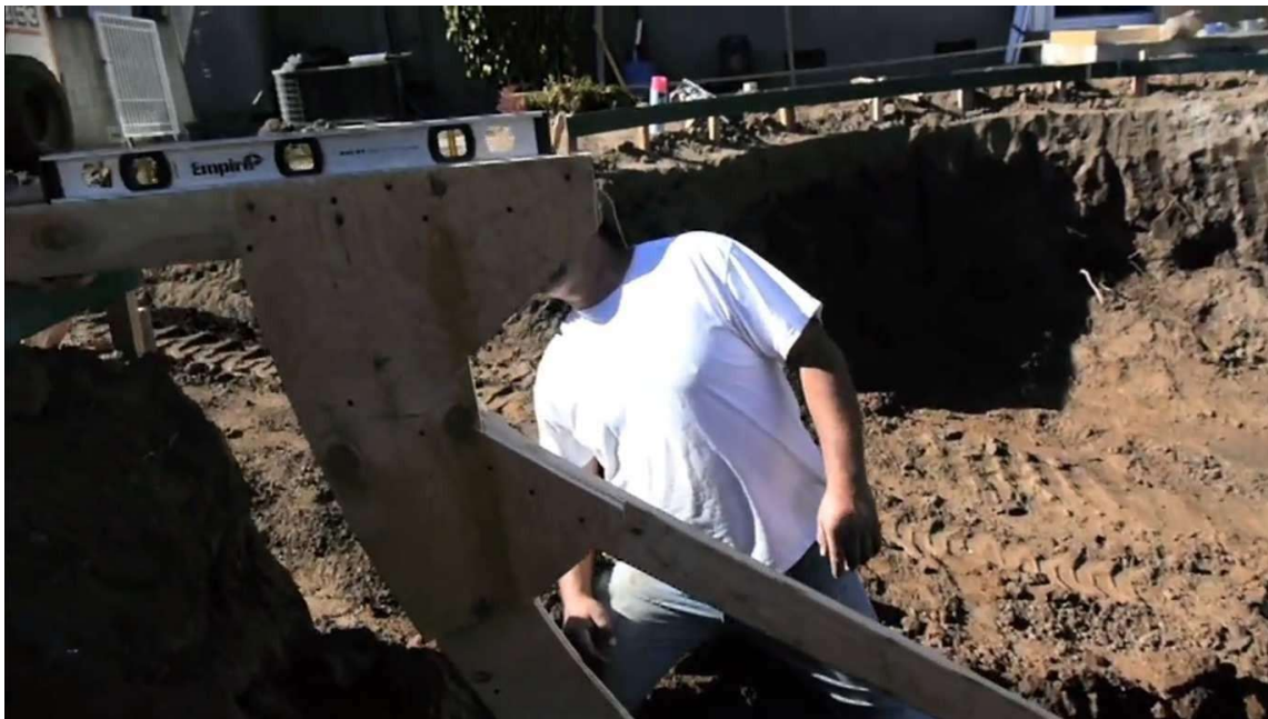
Figura 3 - foto ilustrativa da escavação
