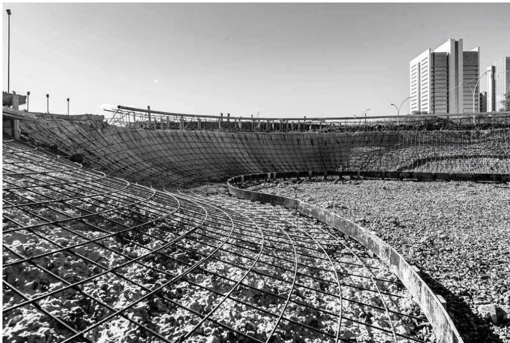
Figura 13 - foto ilustrativa das armaduras da laje de piso
