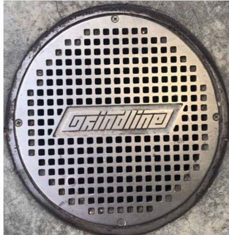
Figura 9 - foto ilustrativa do ralo metálico
