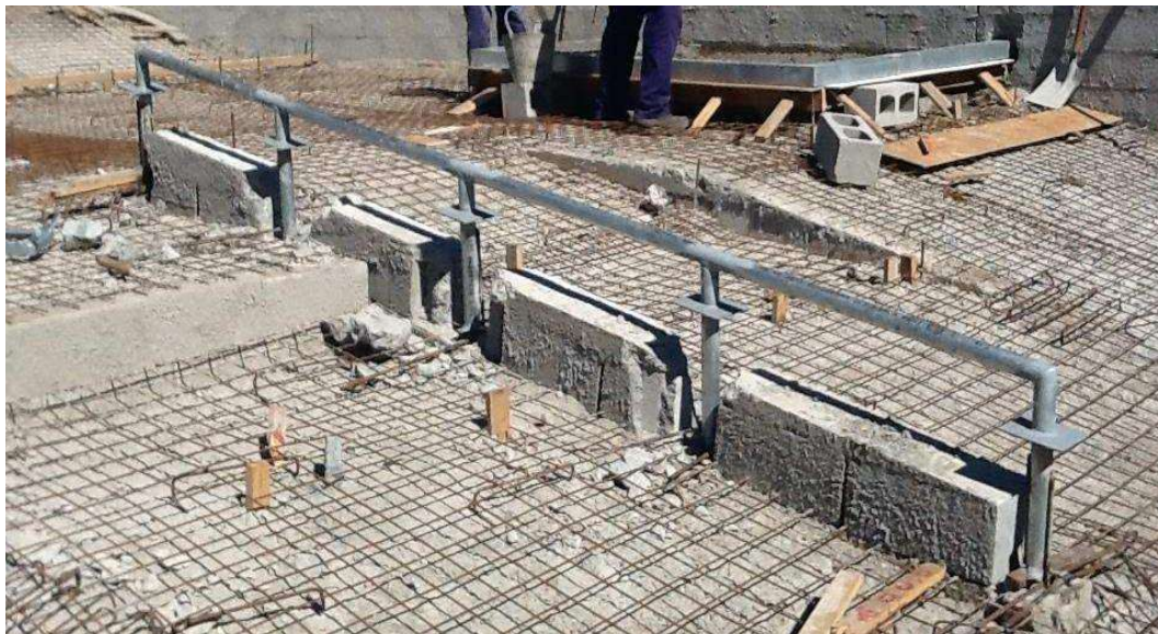
Figura 8 - foto ilustrativa da fixação do corrimão
