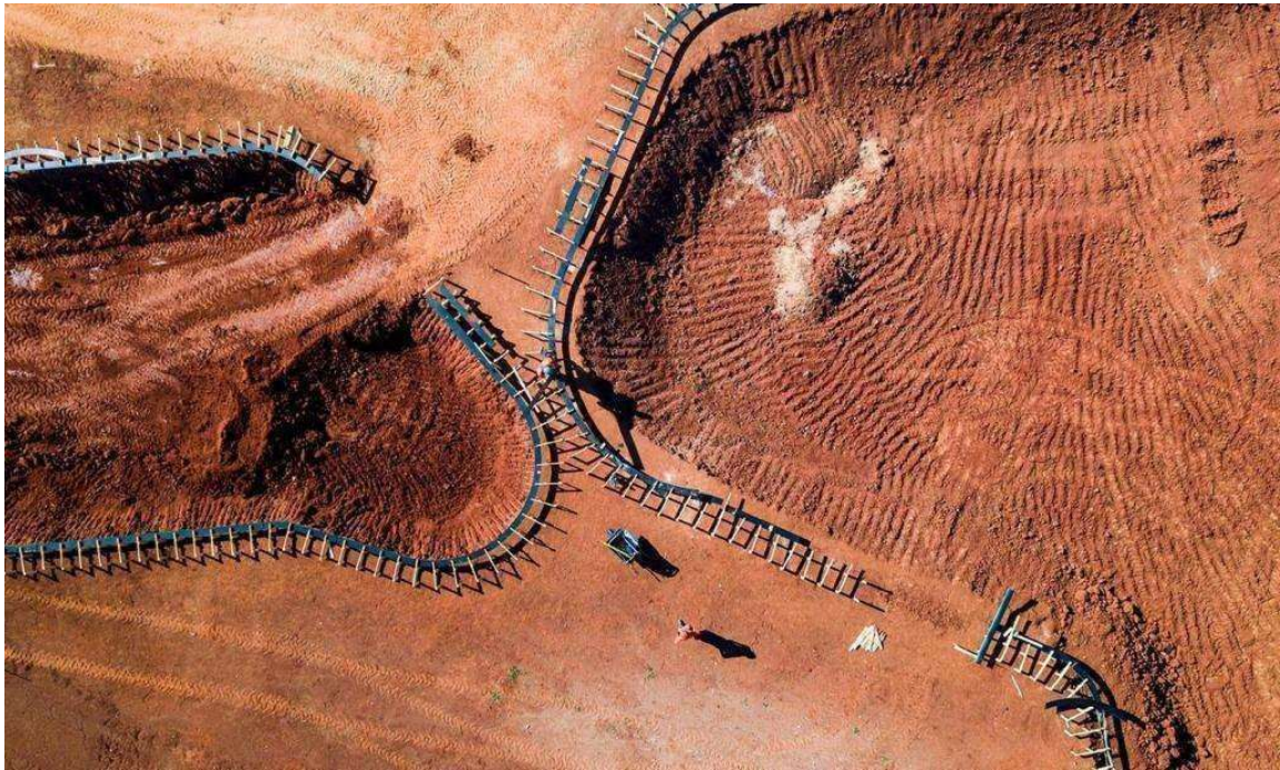
Figura 2 - foto ilustrativa da escavação
