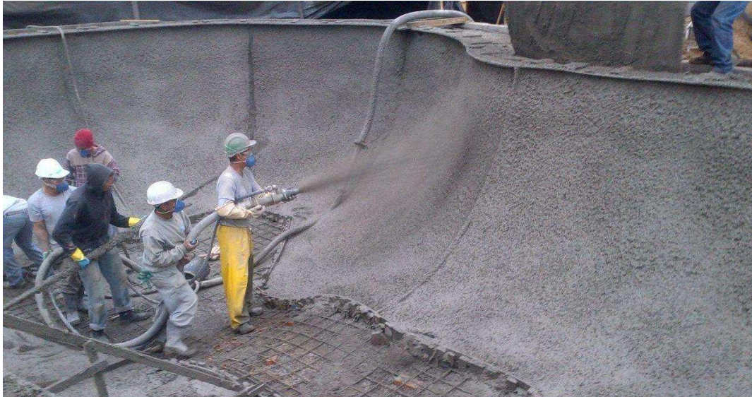
Figura 10 - foto ilustrativa da projeção do concreto magro
