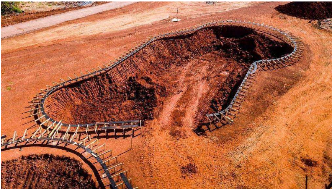
Figura 1 - foto ilustrativa da escavação
