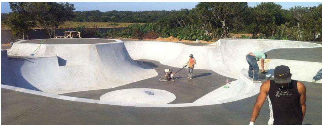
Figura 23 - foto ilustrativa concretagem dos pisos planos
