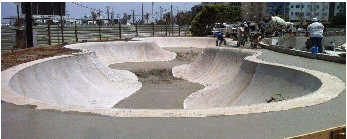
Figura 22 - foto ilustrativa concretagem de pisos planos
