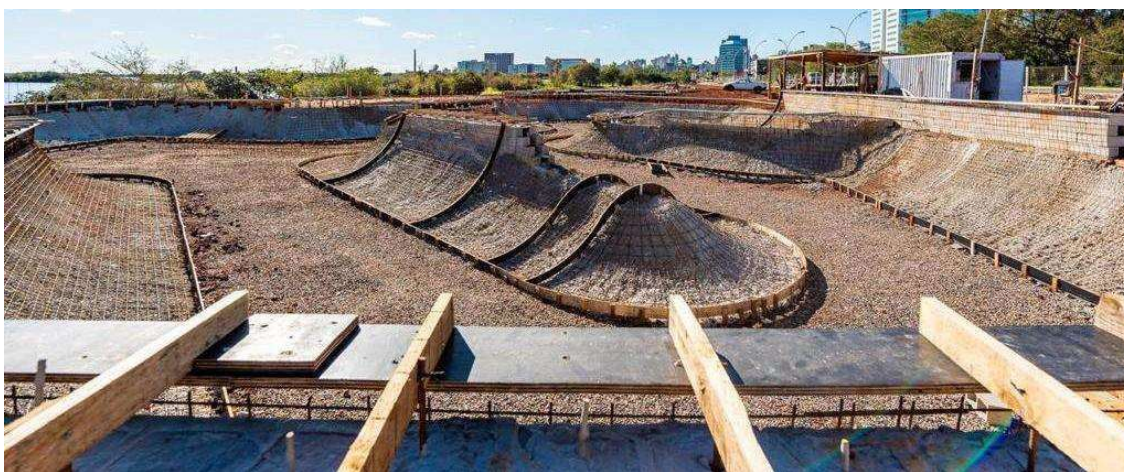
Figura 12 - foto ilustrativa das formas de madeira
