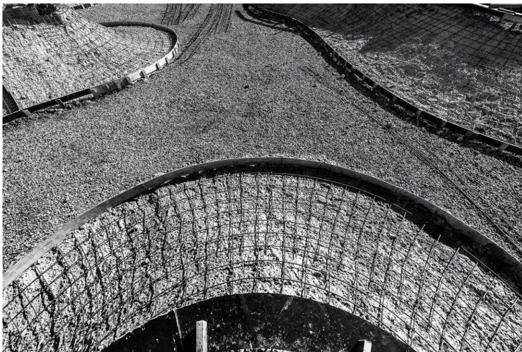
Figura 14 - foto ilustrativa das armaduras da laje de piso
