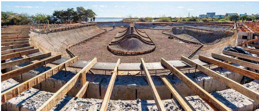
Figura 11 - foto ilustrativa das formas de madeira
