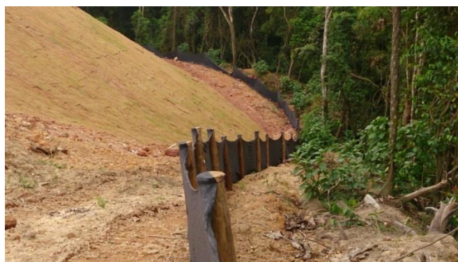
Figura 12 - Detalhe de instalação dos pontaletes em barreira de sedimentos
