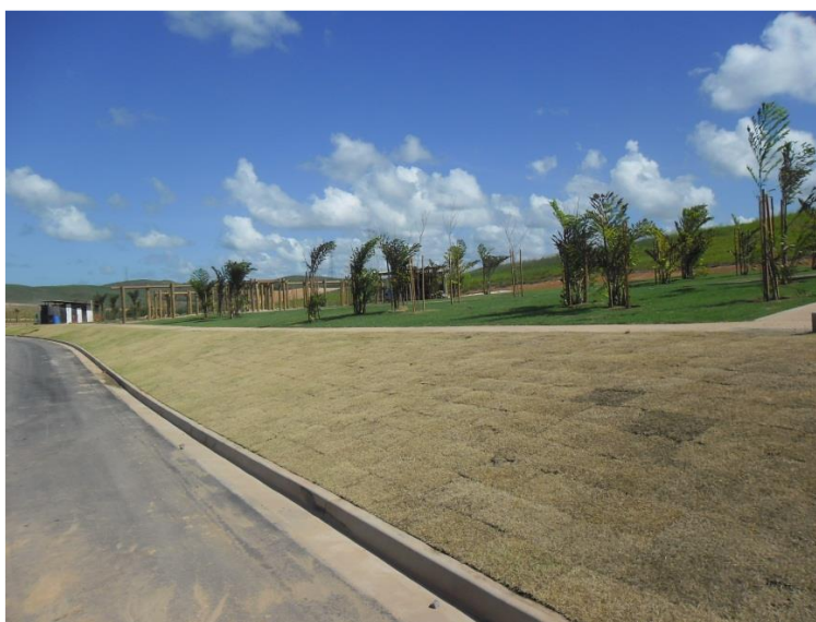
Figura 4 - Rua pavimentada / Coberturas em Quadras
