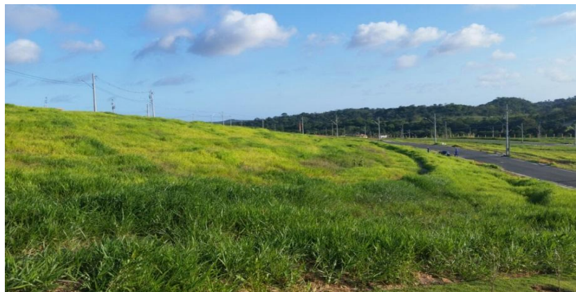
Figura 10 - Exemplo 3 de terraceamento e lote com camada vegetal pronto para entrega
