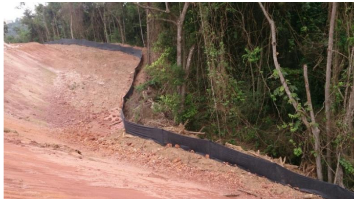
Figura 13 - Aplicação da manta geotêxtil no pé do talude de aterro, início da APP
