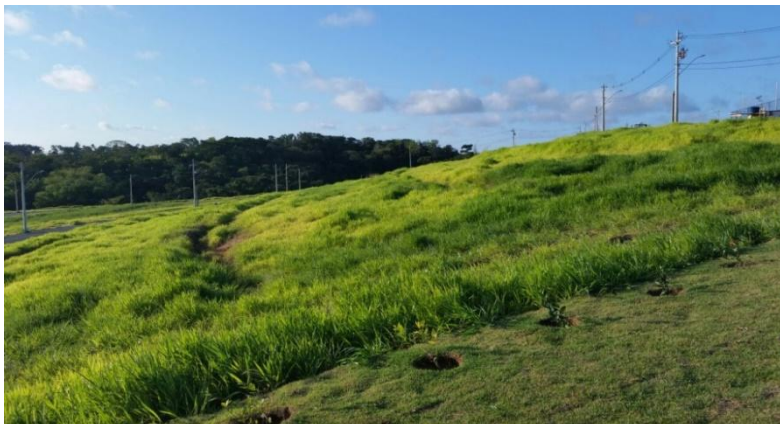
Figura 11 - Exemplo 4 de terraceamento e lote com camada vegetal pronto para entrega
