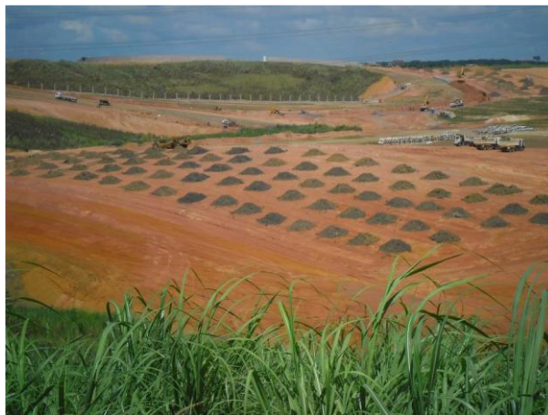
Figura 2 – Limpeza/Depósito de camada vegetal
