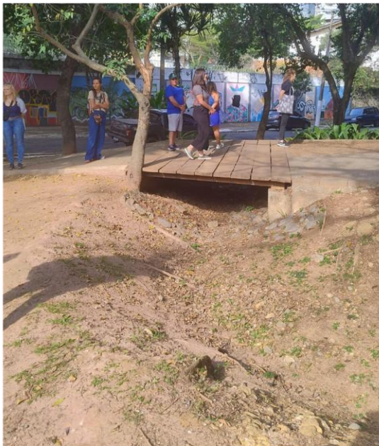
Exemplo de biovaleta sem cobertura vegetal adequada nos taludes e na base plana indicando necessidade de ação corretiva
