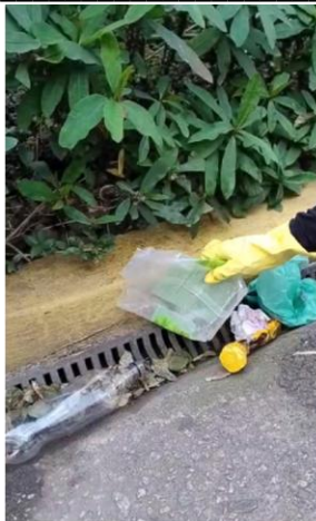
Indicador de obstrução de entrada ou saída de água em tipologia de infraestrutura verde.
