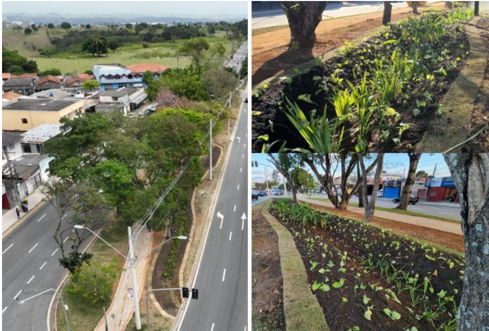
Figura 11 – Biovaleta implantada em São José dos Campos – SP. Fonte: Geasa Engenharia, 2023.
