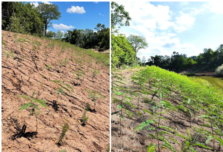
Figura 5. Exemplo da implantação de arbustivas autóctones sobre uma margem fluvial em recuperação. Fonte das Imagens: Salix Engenharia Natural, 2025.
