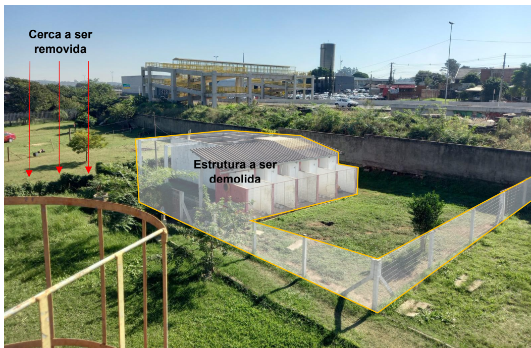
Figura 1 Estruturas a serem demolidas
