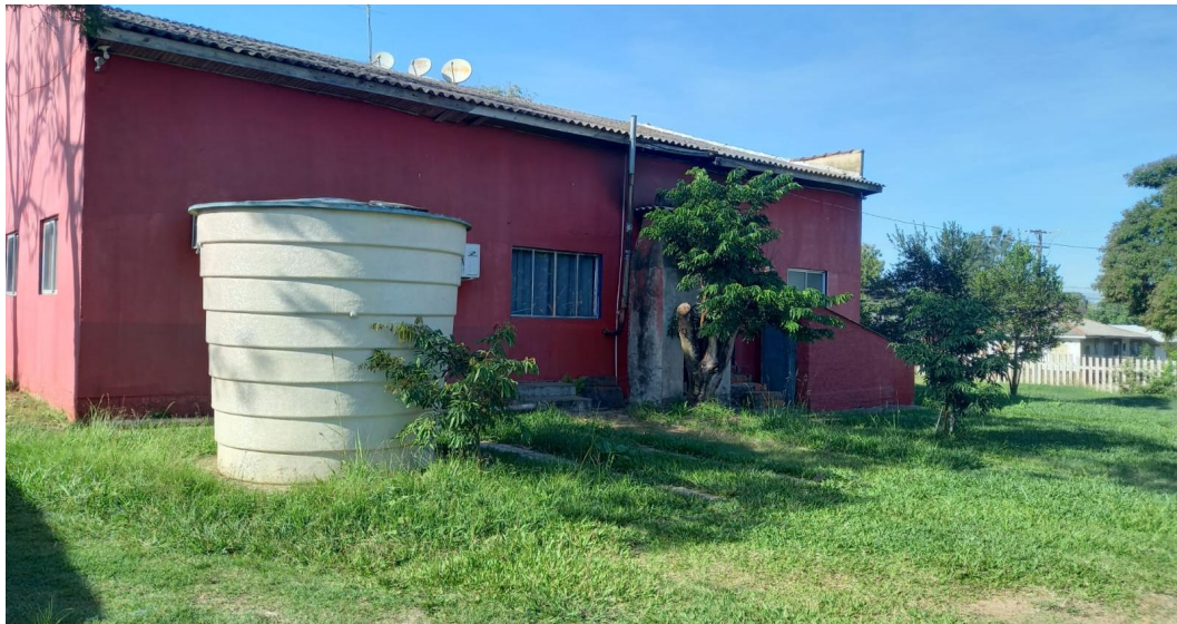
Figura 2 Reservatório em fibra a ser removido
