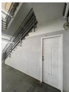
Figura 28 – Escada e acesso ao Almoxarifado (Bloco Siqueira).
