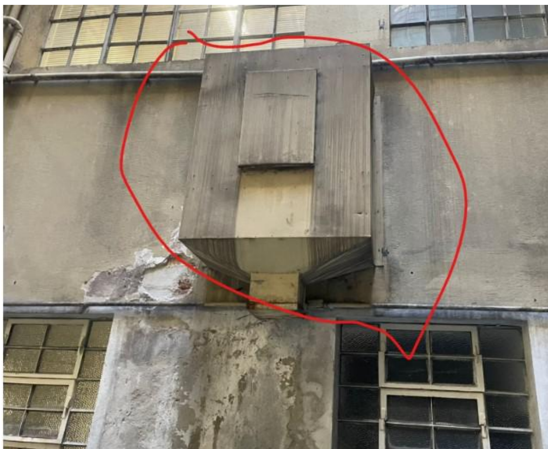
Figura 3 – Detalhe do equipamento a ser removido.
