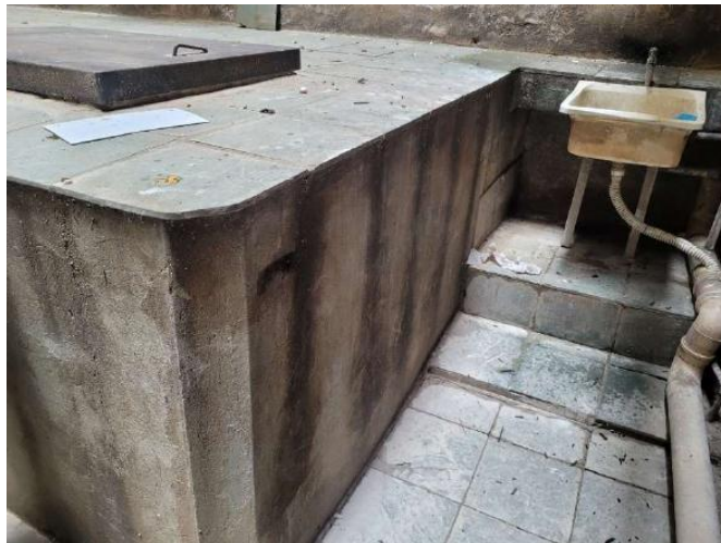
Figura 10: Detalhe lateral do Reserv Inf bloco Siqueira;
