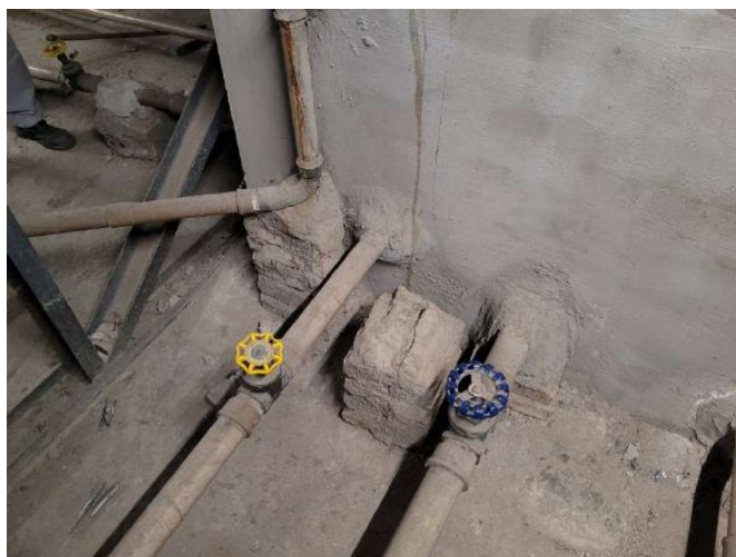
Figura 8: Detalhe saída e registros existentes do do Reserv Sup bloco Mauá;
