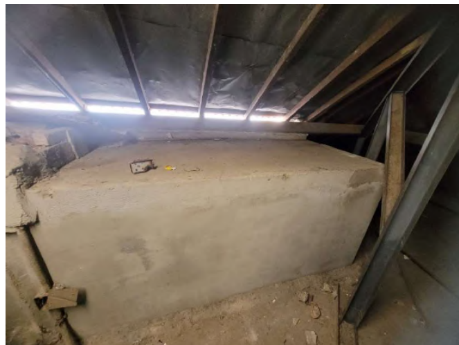
Figura 6: Detalhe lateral do Reserv Sup bloco Mauá;
