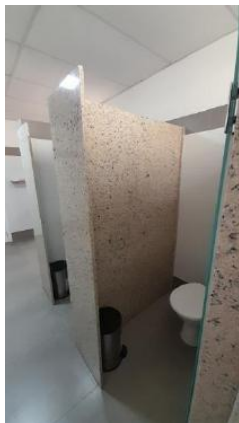
Figura 35 – Cabines dos sanitários em granito Amarelo Icaraí.
