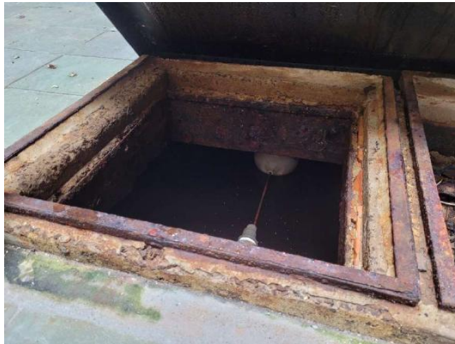
Figura 9: Detalhe tampa aberta do Reserv Inf bloco Siqueira;
