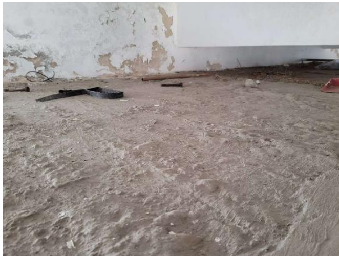
Figura 11: Detalhe da base do Reserv Sup bloco Siqueira;
