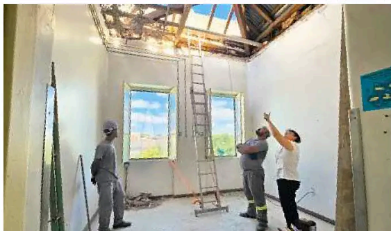
Sob intervenção da prefeitura, obra deve levar um mês
