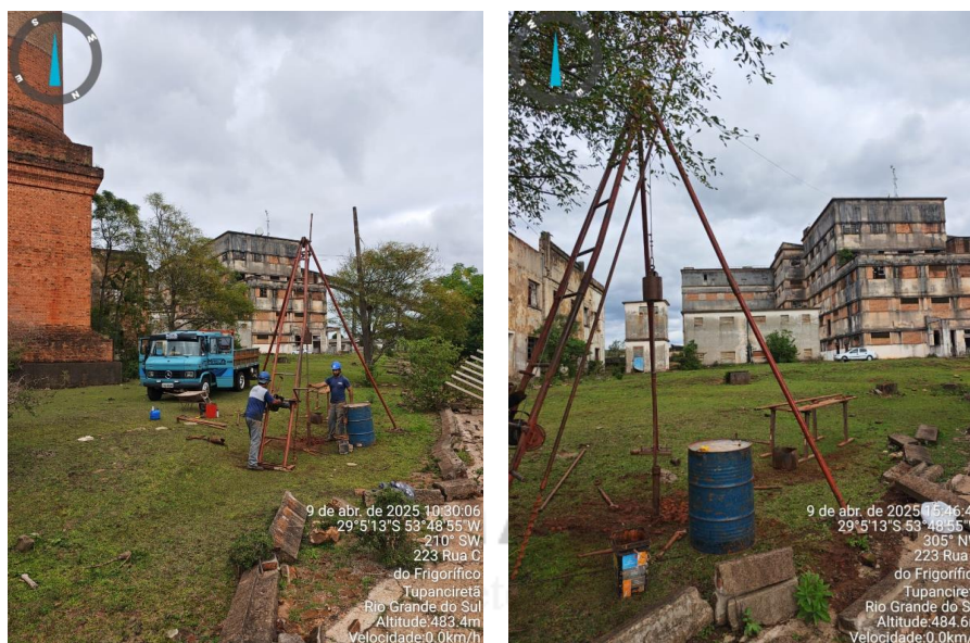
Figura 3 – Execução dos três ensaios de sondagem SPT (a) (b).
