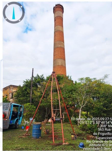
Figura 4 – Execução dos três ensaios de sondagem SPT (c).
